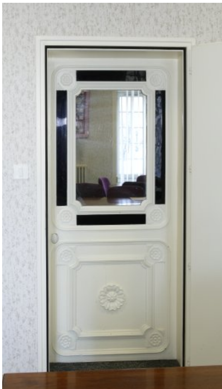
Porte (moderne) de l'une des pièces du rez-du-chaussée.
