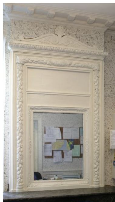
Trumeau de cheminée (du XIXe siècle) de l'une des pièces du rez-de-chaussée. Phot. Patrice Giraud IVR52_20078500032NUCA
