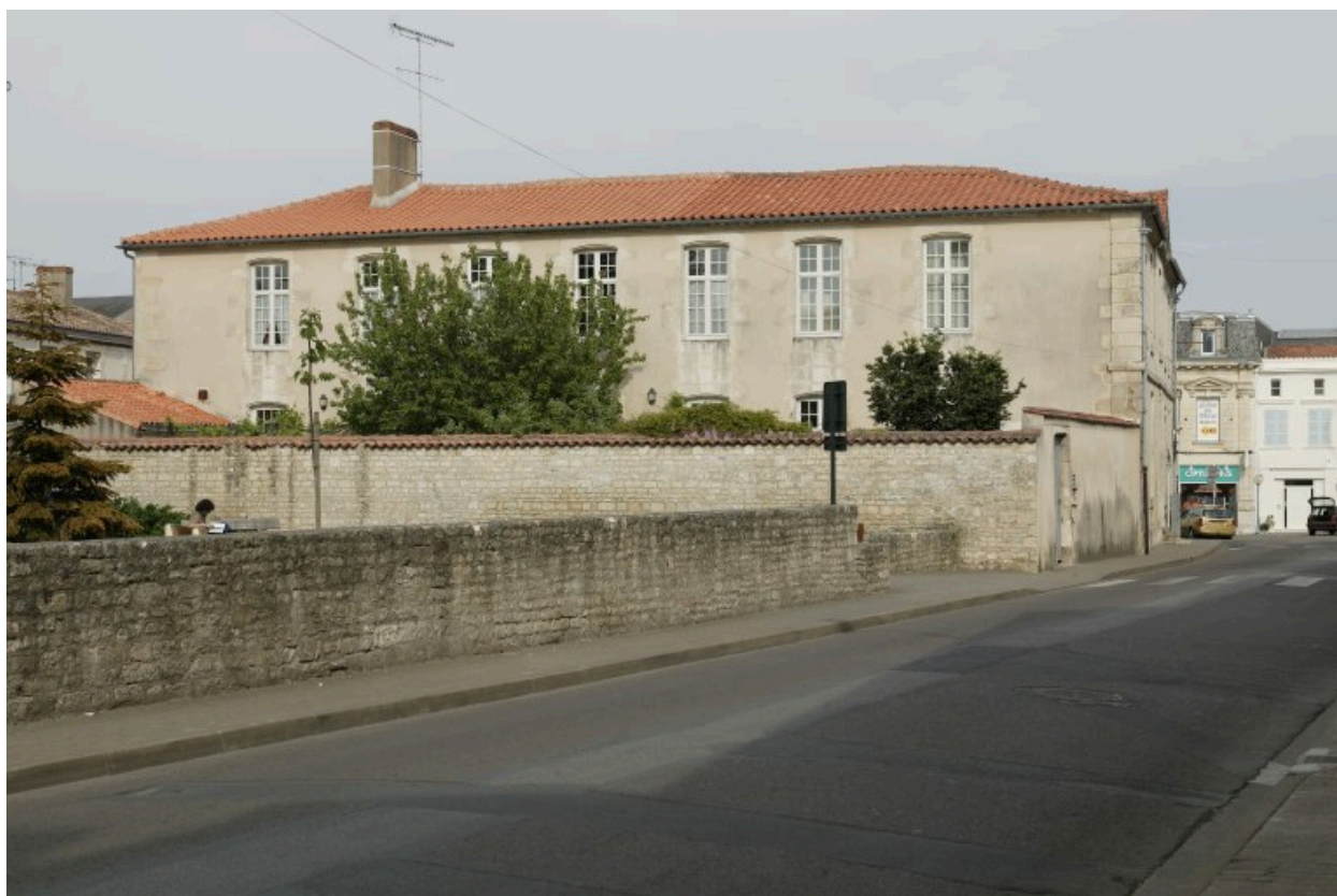
Façade ouest sur jardin.
