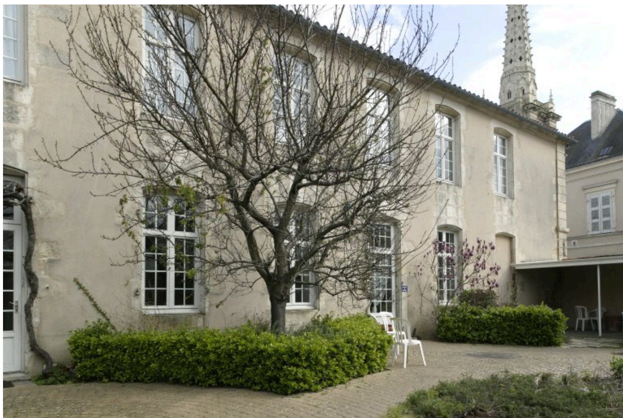
Vue partielle de la façade sur jardin.
