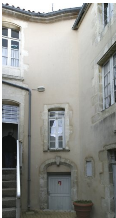
Partie ouest de la cour intérieure. Noter la courbe du mur. Phot. Patrice Giraud IVR52_20078500024NUCA
