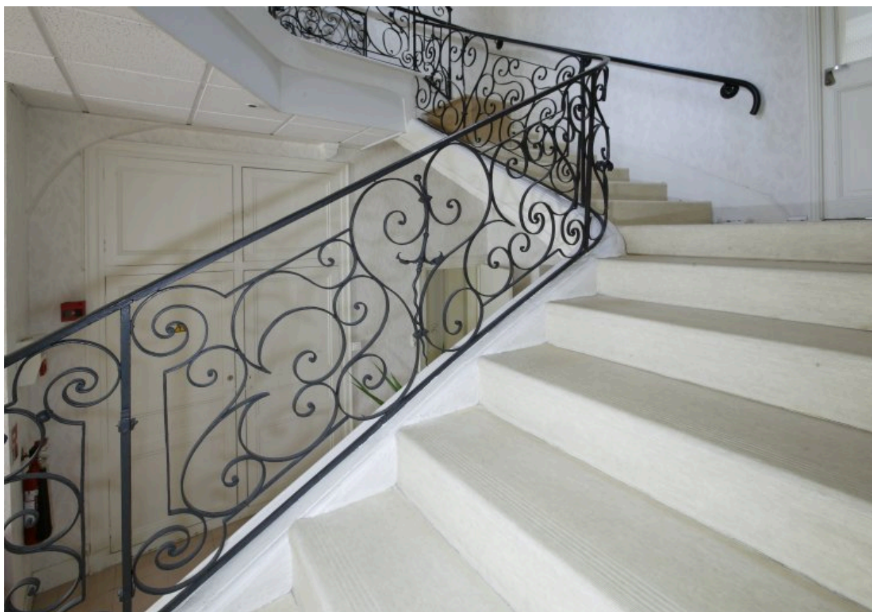
Garde-corps de l'escalier.
