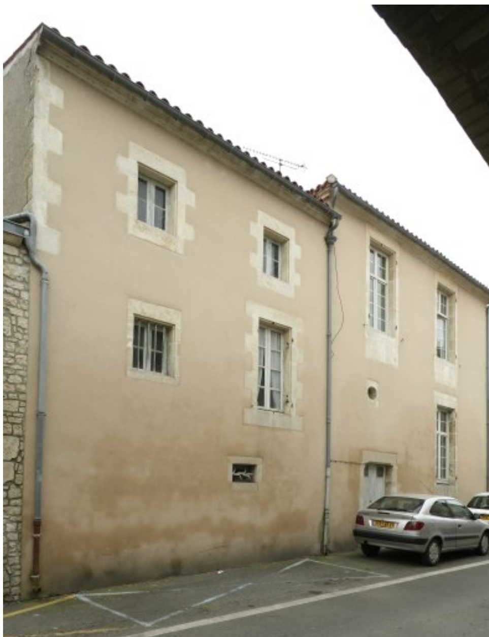
Façade nord, rue Millandy.
