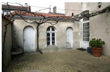
Dépendance en retour de la façade sur jardin, le long de la rue Millandy, postérieure à 1845 (non figurée sur le cadastre). Phot. Patrice Giraud IVR52_20078500022NUCA
