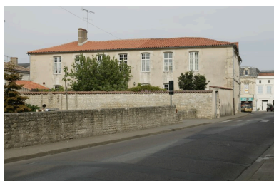
Façade ouest sur jardin. Phot. Patrice Giraud IVR52_20078500163NUCA
