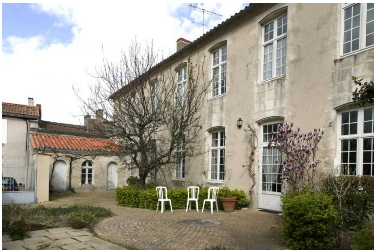
Vue partielle de la façade sur jardin.
