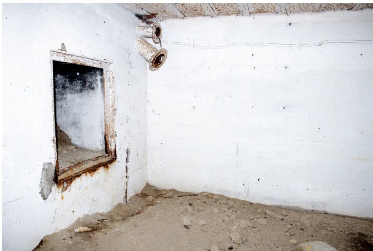
Vue de la pièce principale.
