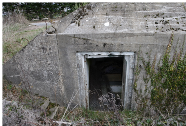
Détail de la porte d'entrée.
