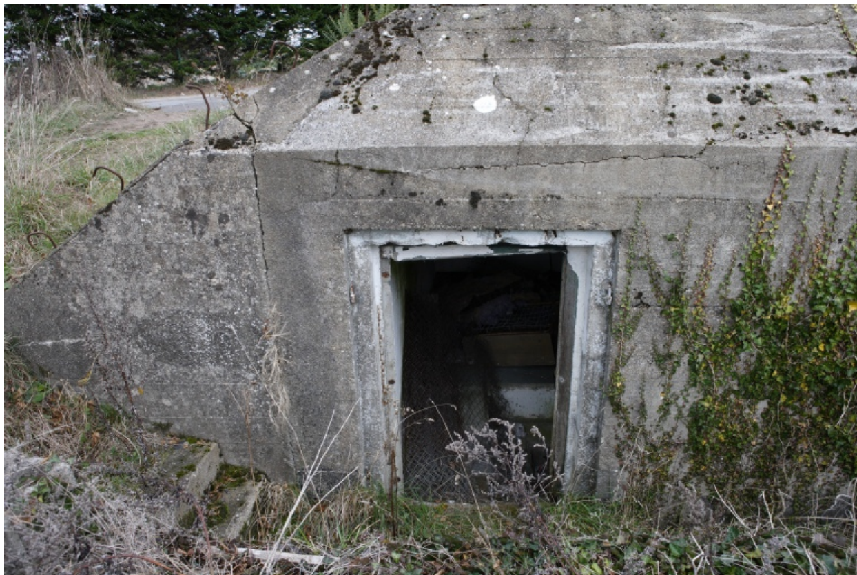
Détail de la porte d'entrée.
