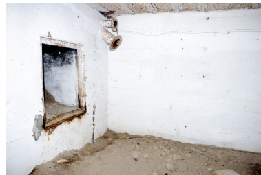
Vue de la pièce principale.
