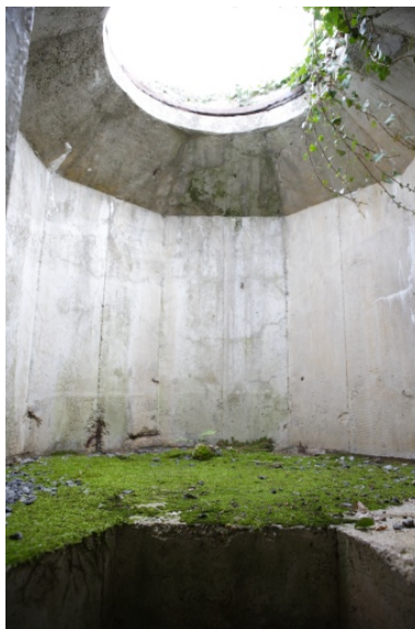
Vue de l'intérieur de la tourelle de défense.
