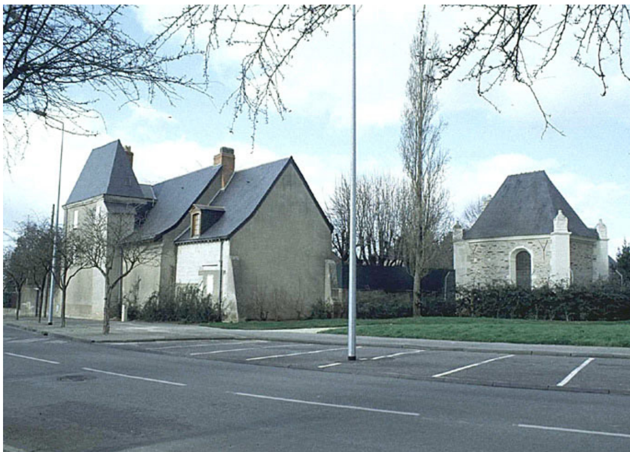
Vue d'ensemble sur rue.
