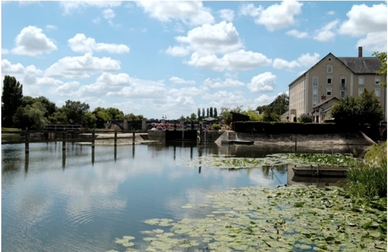
Vue d'ensemble de l'écluse.
