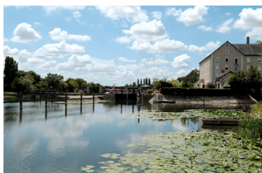
Vue d'ensemble de l'écluse. Phot. Bruno Rousseau IVR52_20064901622NUCA
