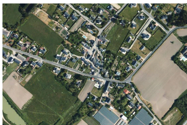
Vue aérienne de l'écart de Mouzac. IVR52_20084404112NUCA
