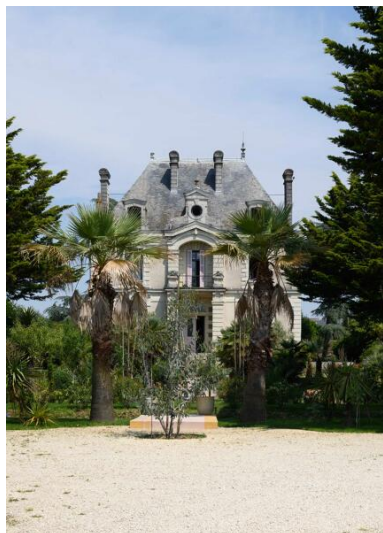
Vue générale, maison dite le Plessis, Montjean-sur-Loire. Phot. Armelle Maugin IVR52_20244900515NUCA
