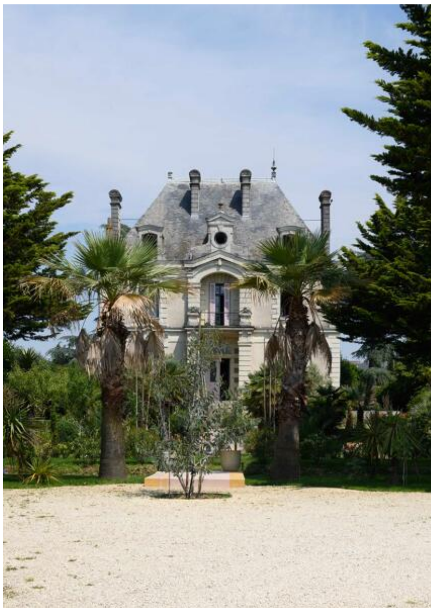
Vue générale, maison dite le Plessis, Montjean-sur-Loire.
