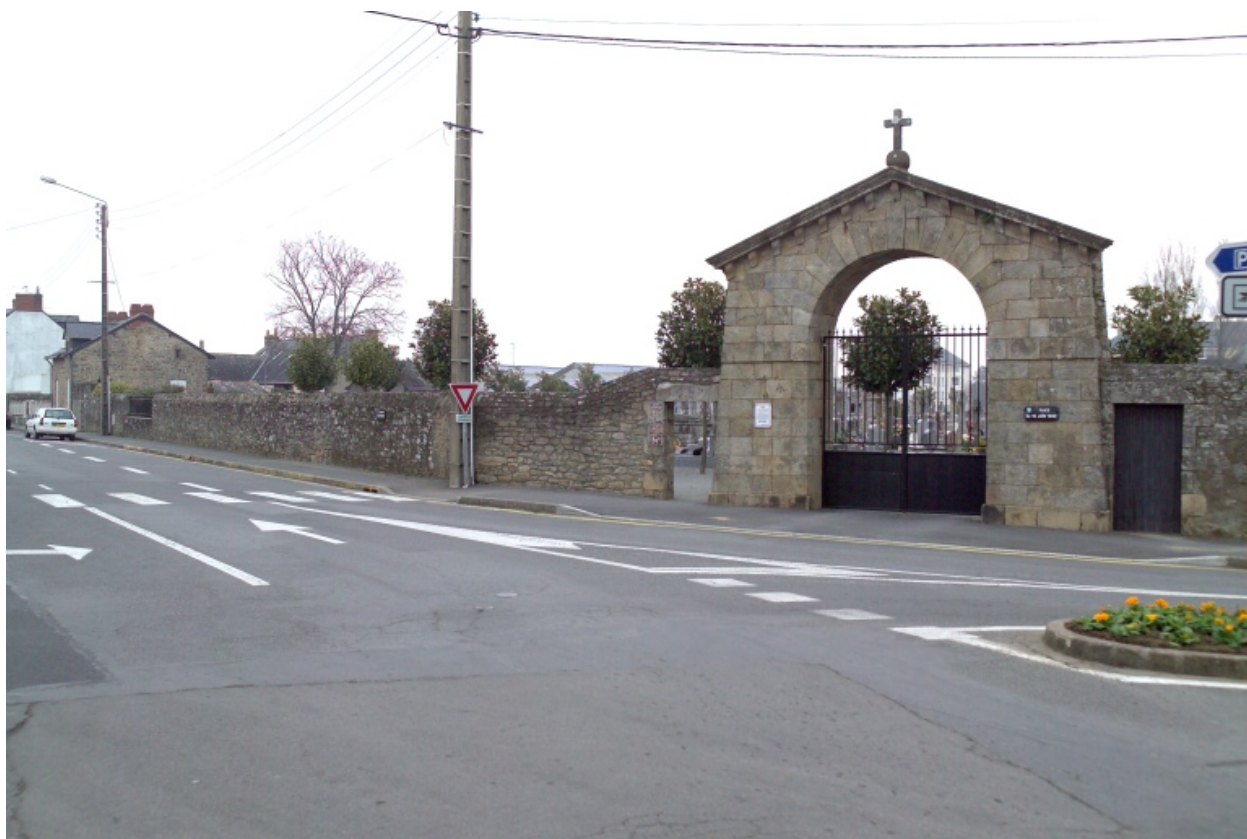
Vue du portail et mur de clôture bordant le boulevard E. Pourieux.
