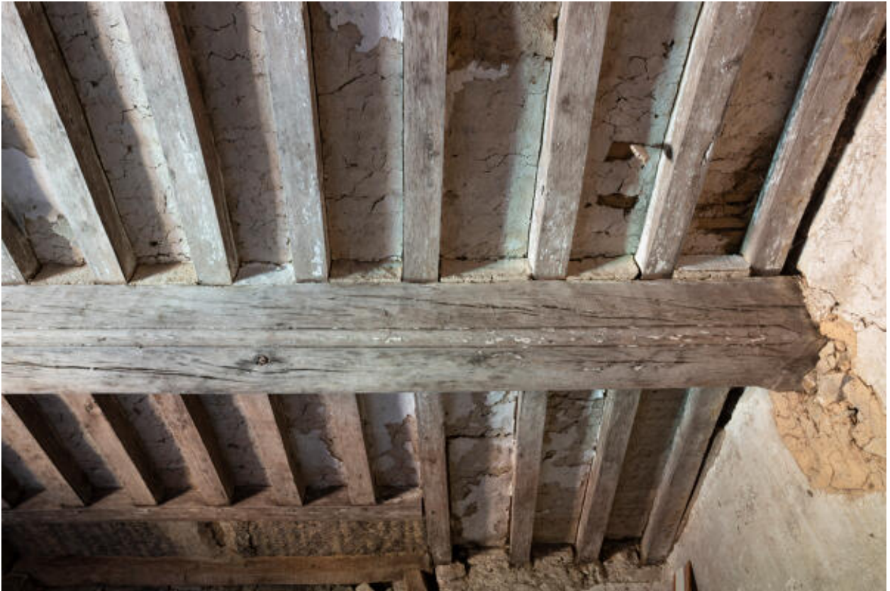
Le plafond d'une ancienne chambre.
