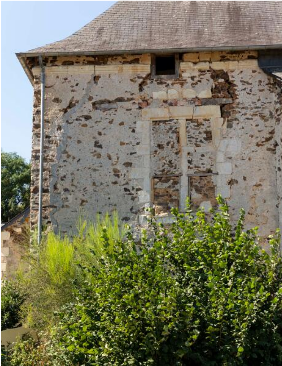
Une fenêtre murée de la façade postérieure.
