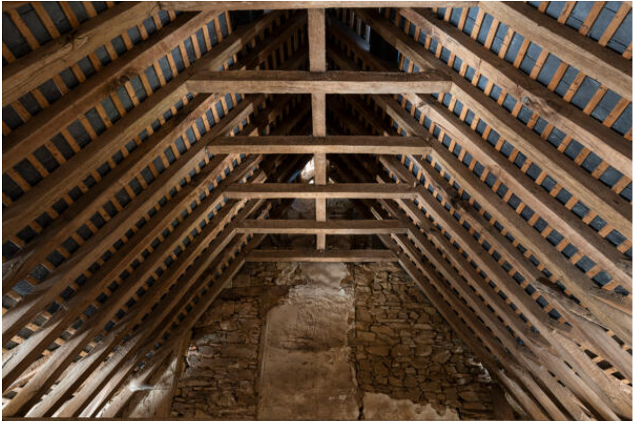
La charpente du bâtiment en abside.
