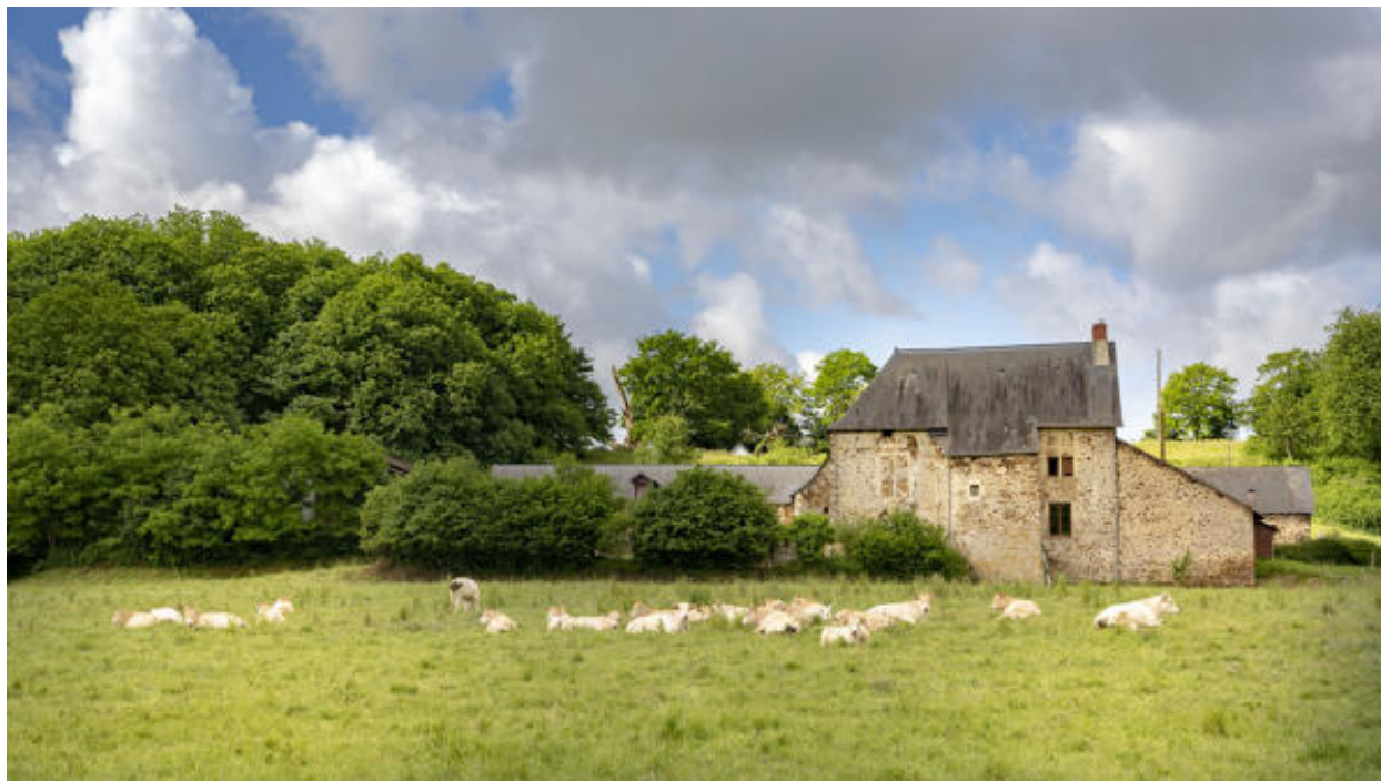
La façade postérieure du manoir depuis les bords de la Mayenne.
