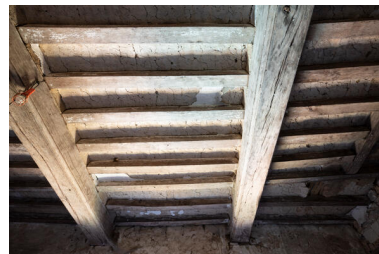
Le plafond d'une ancienne chambre. Phot. Thierry Seldubuisson IVR52_20225300770NUCA
