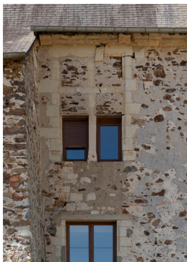
Une fenêtre murée de la façade postérieure. Phot. Thierry Seldubuisson IVR52_20225300747NUCA
