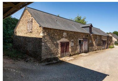
Les anciennes étables. Phot. Thierry Seldubuisson IVR52_20225300749NUCA
