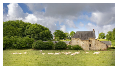
La façade postérieure du manoir depuis les bords de la Mayenne. Phot. Pierre-Bernard Fourny IVR52_20225300514NUCA
