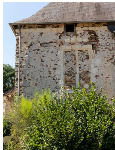
Une fenêtre murée de la façade postérieure. Phot. Thierry Seldubuisson IVR52_20225300746NUCA
