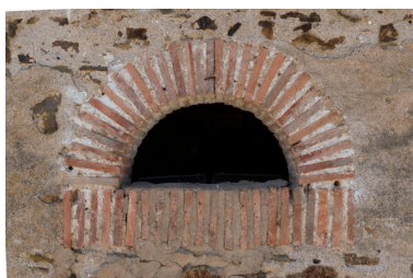
L'ancienne écurie, détail d'une baie. Phot. Thierry Seldubuisson IVR52_20225300761NUCA
