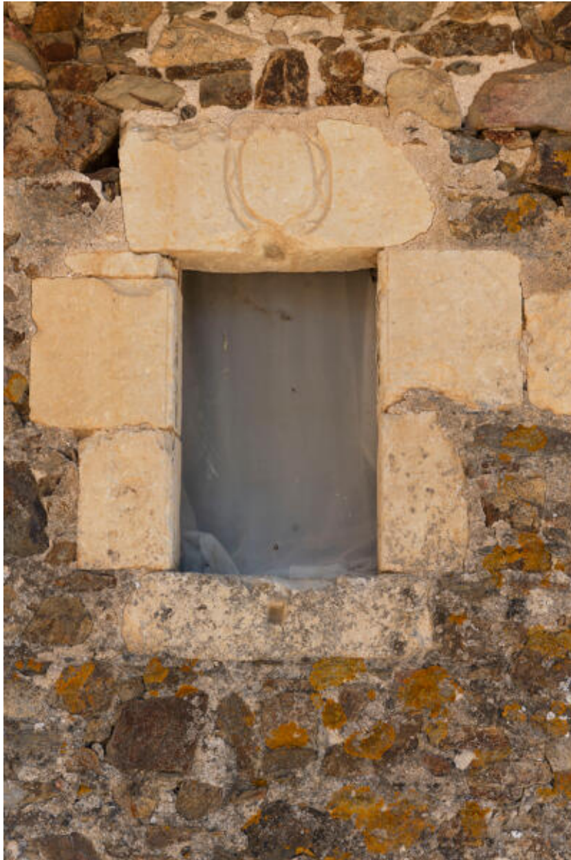
La petite baie à linteau gravé du bâtiment en abside.
