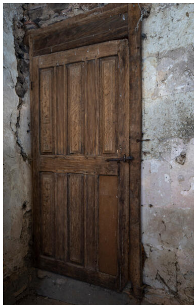
La porte d'une ancienne chambre du logis. Phot. Thierry Seldubuisson IVR52_20225300775NUCA
