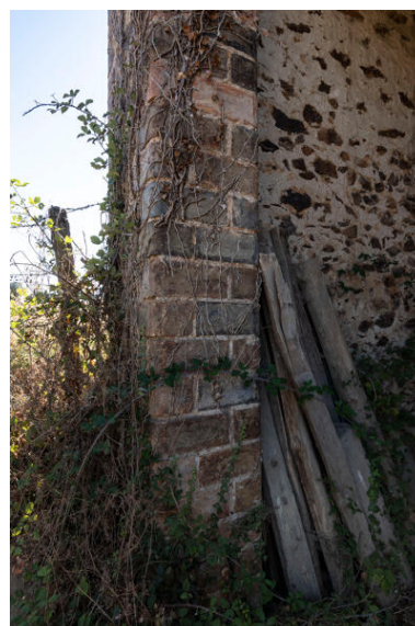
Un détail de la maçonnerie de la remise. Phot. Thierry Seldubuisson IVR52_20225300782NUCA
