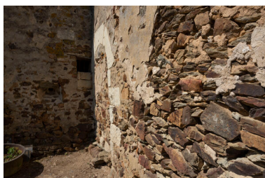
Le porte murée de la façade latérale sud du logis et la bouche à feu à l'arrière du bâtiment en abside. Phot. Thierry Seldubuisson IVR52_20225300753NUCA
