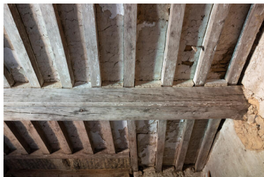
Le plafond d'une ancienne chambre. Phot. Thierry Seldubuisson IVR52_20225300771NUCA
