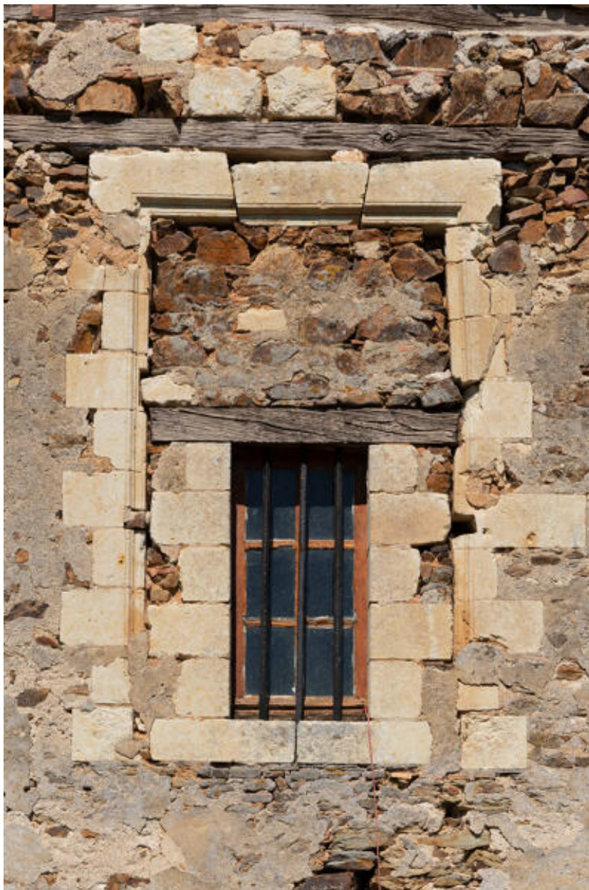
La fenêtre murée de la façade latérale sud du logis.
