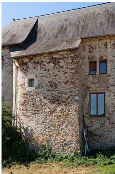
La tour d'escalier. Phot. Thierry Seldubuisson IVR52_20225300748NUCA
