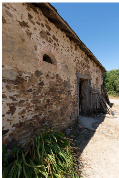
L'ancienne écurie. Phot. Thierry Seldubuisson IVR52_20225300760NUCA
