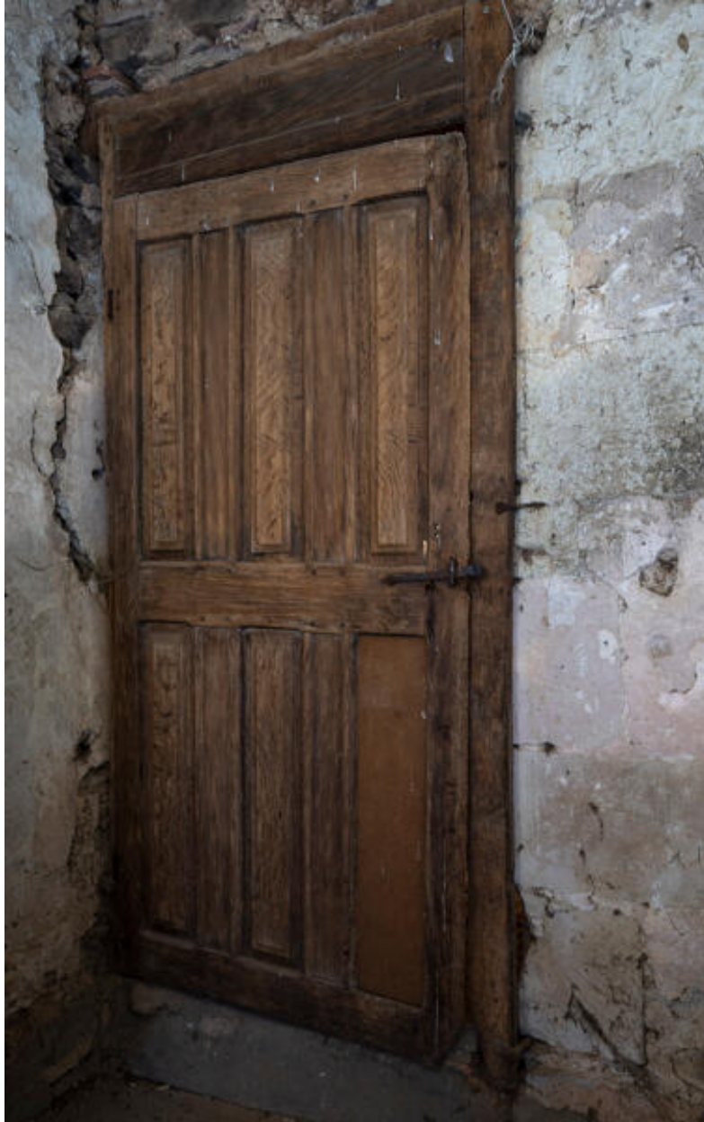
La porte d'une ancienne chambre du logis.
