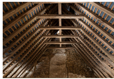
La charpente du bâtiment en abside. Phot. Thierry Seldubuisson IVR52_20225300774NUCA
