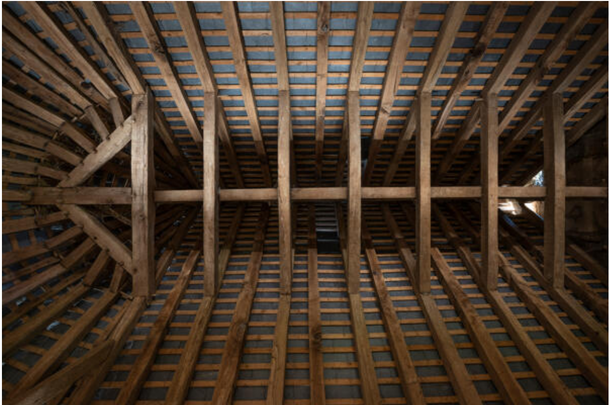
La charpente du bâtiment en abside.
