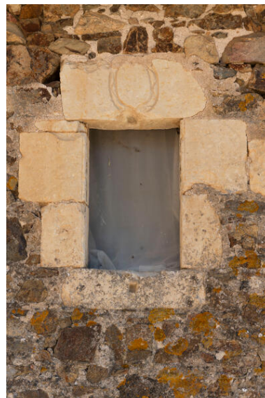
La petite baie à linteau gravé du bâtiment en abside. Phot. Thierry Seldubuisson IVR52_20225300765NUCA
