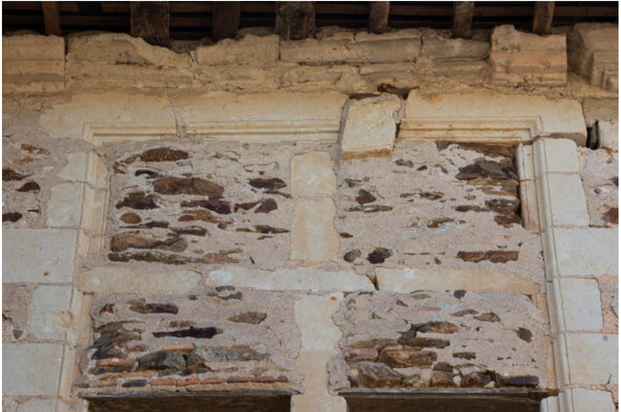
Une fenêtre murée de la façade postérieure.
