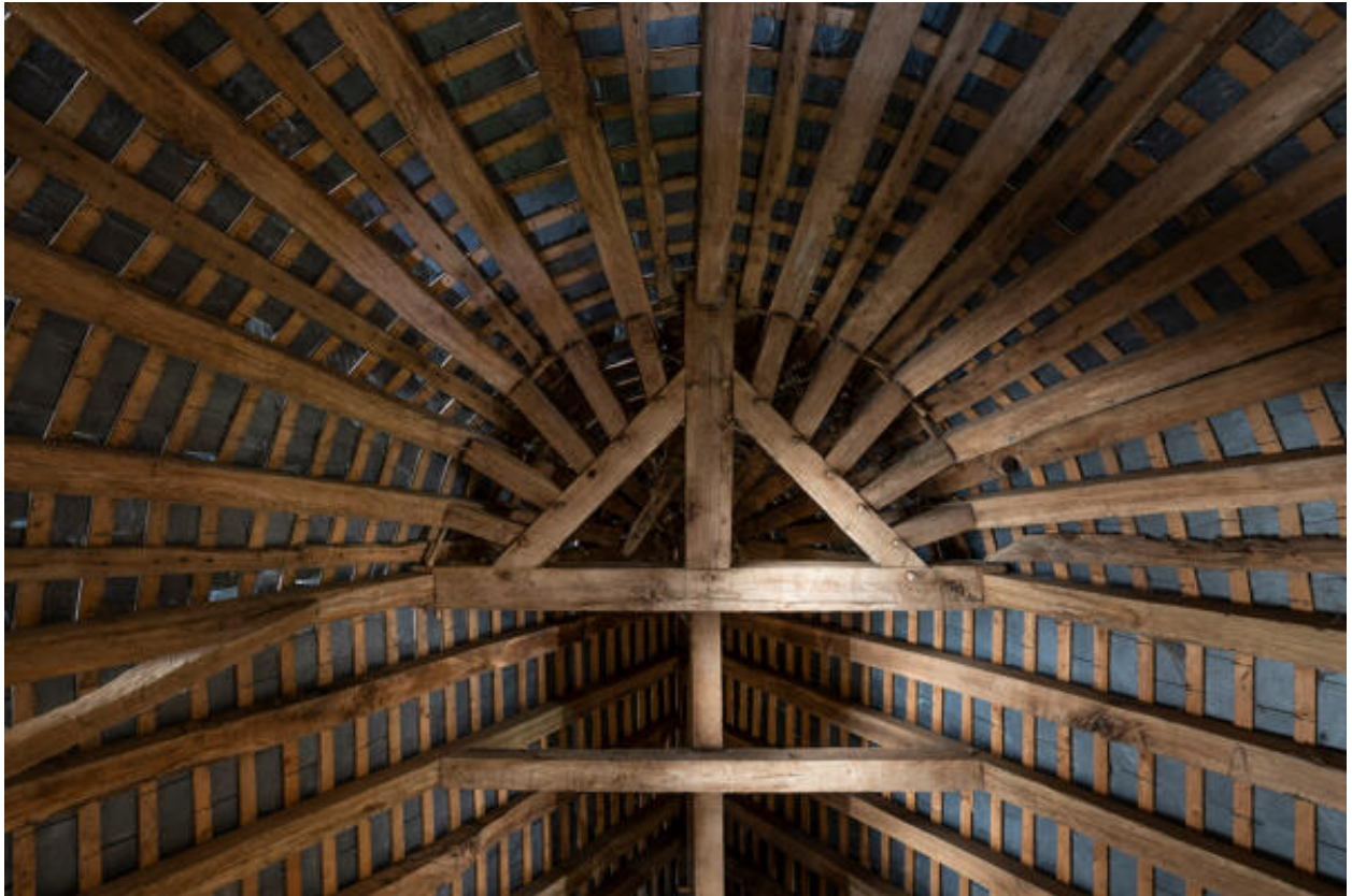
La charpente du bâtiment en abside.
