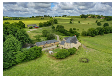
Une vue aérienne du Grand-Coudray. Phot. Pierre-Bernard Fourny IVR52_20225300560NUCA
