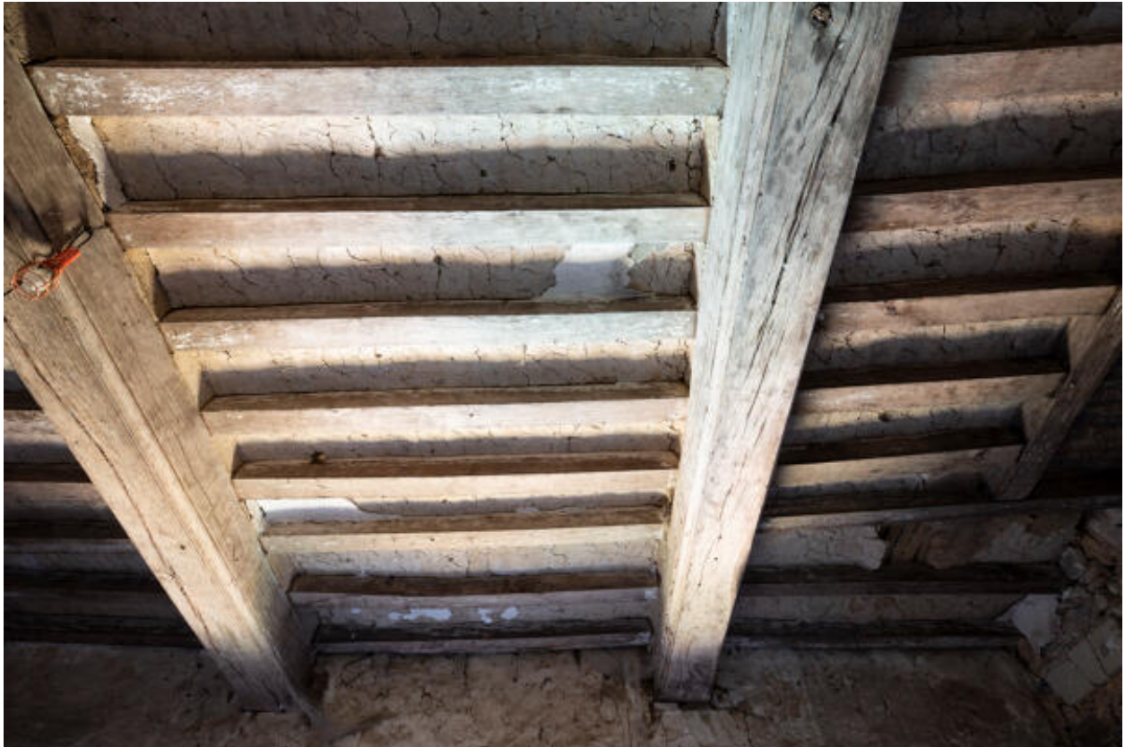
Le plafond d'une ancienne chambre.
