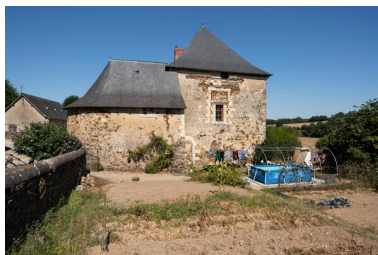
La façade latérale sud du logis. Phot. Thierry Seldubuisson IVR52_20225300751NUCA
