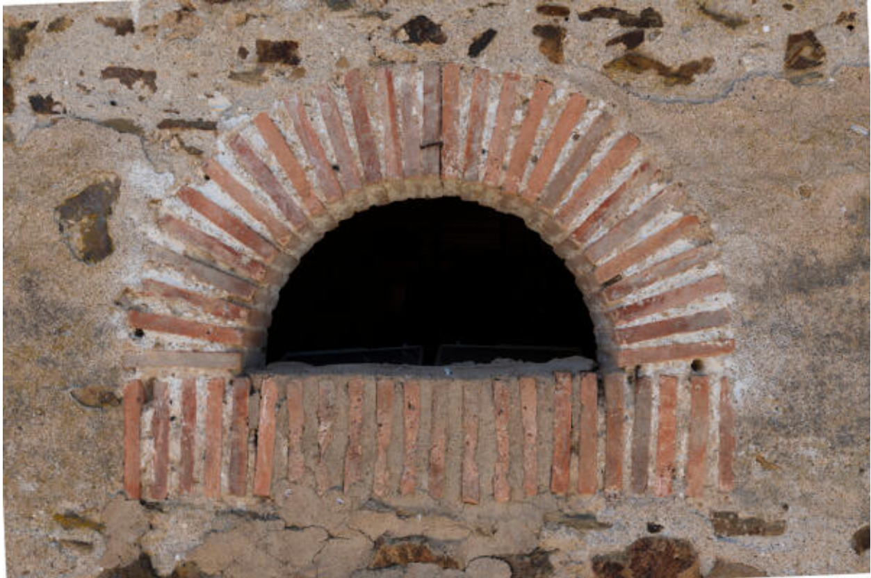
L'ancienne écurie, détail d'une baie.
