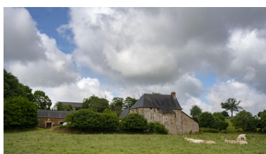
La façade postérieure du manoir depuis les bords de la Mayenne. Phot. Pierre-Bernard Fourny IVR52_20225300513NUCA
