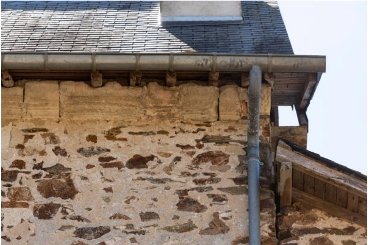
Un détail de la corniche du logis.
