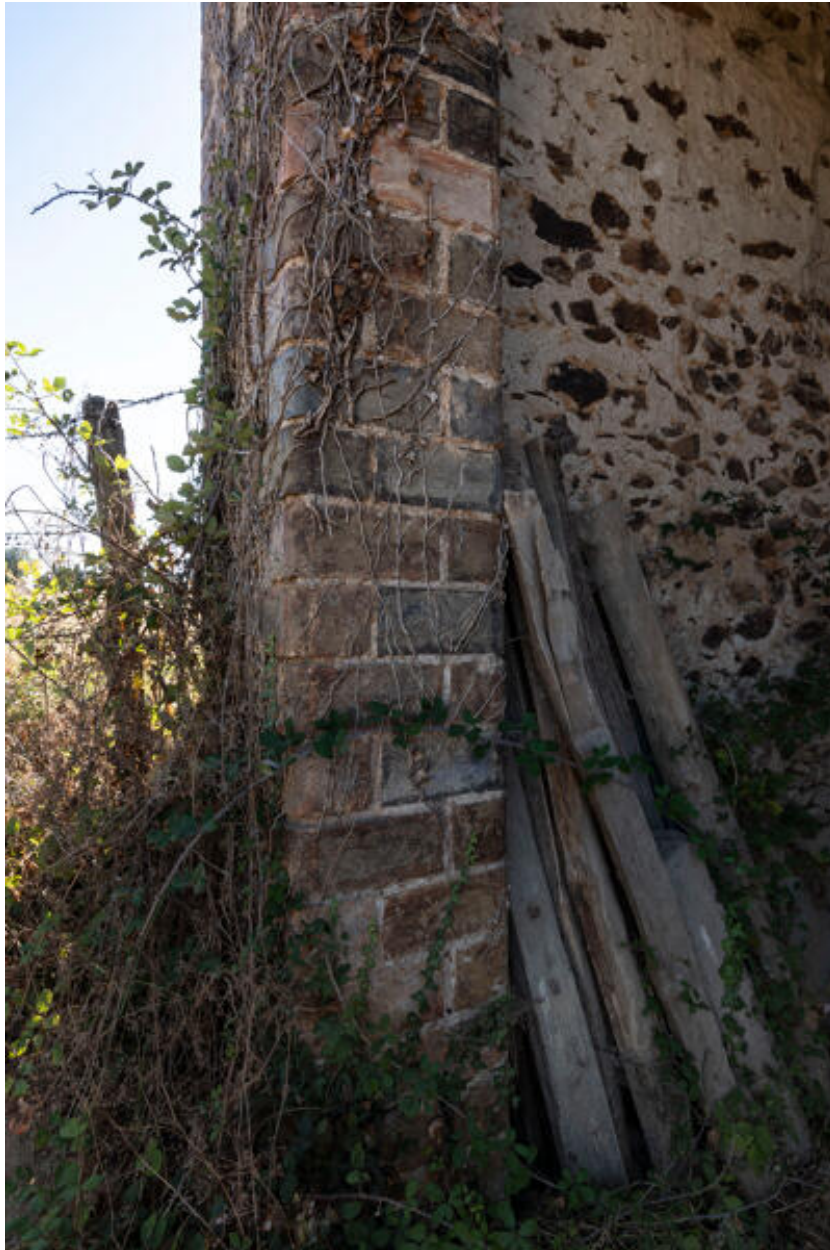
Un détail de la maçonnerie de la remise.
