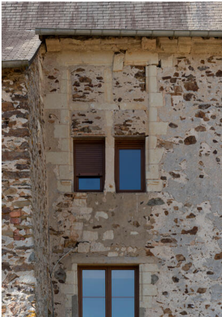
Une fenêtre murée de la façade postérieure.
