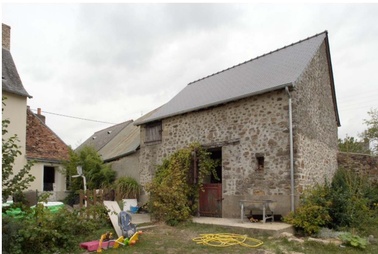
Vue depuis la cour au sud.
