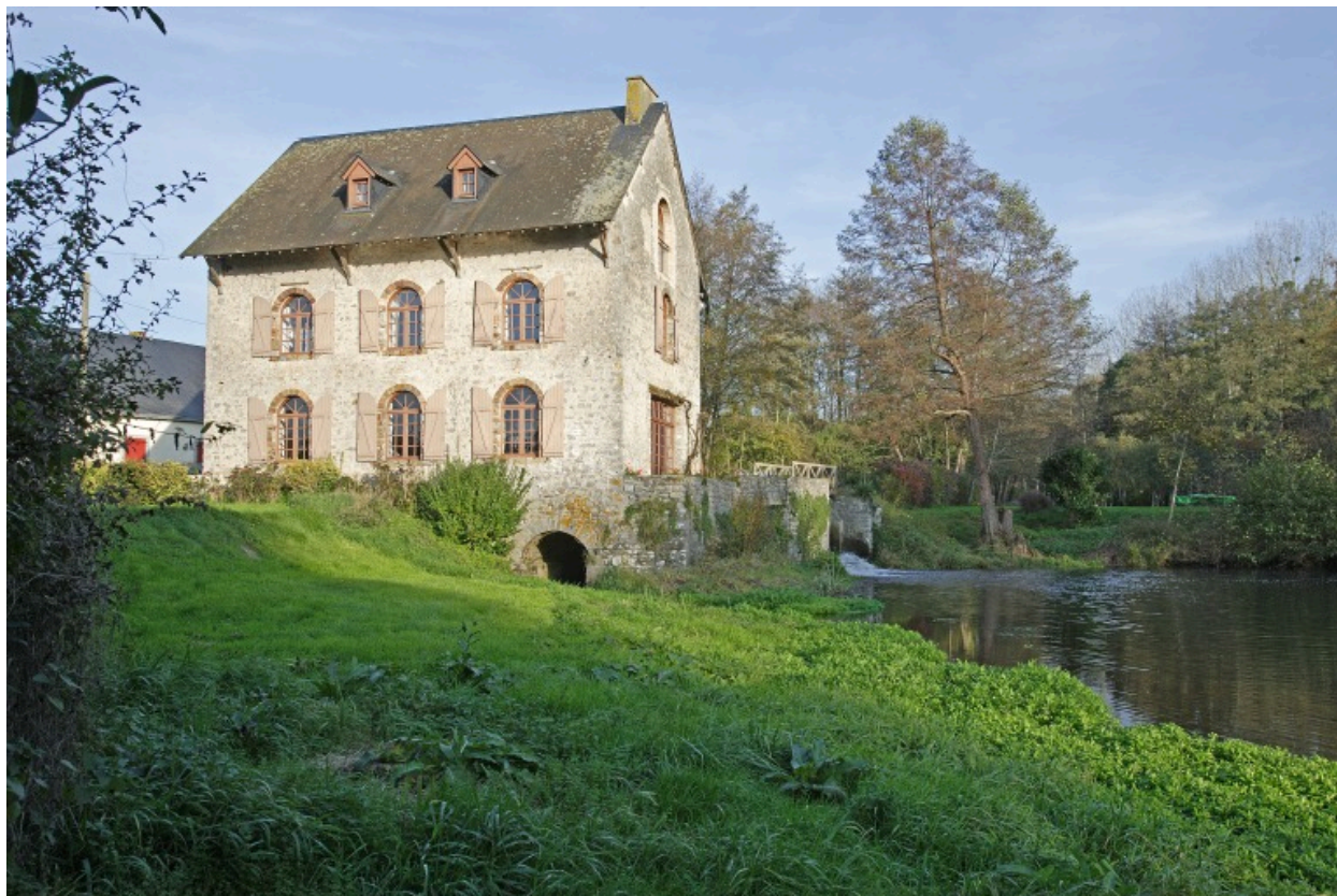
Le moulin vu depuis l'ouest.
