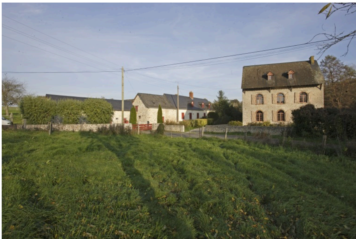
Vue d'ensemble depuis l'ouest : la porcherie, le logis-étable, le moulin.
