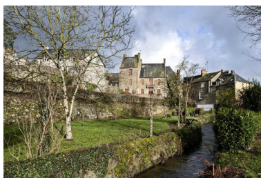
La rivière du Lassay coulant au sud des jardins de la ville ; maison du 26 Grande-Rue, façade sur jardin. Phot. Yves Guillotin IVR52_20225300018NUCA
