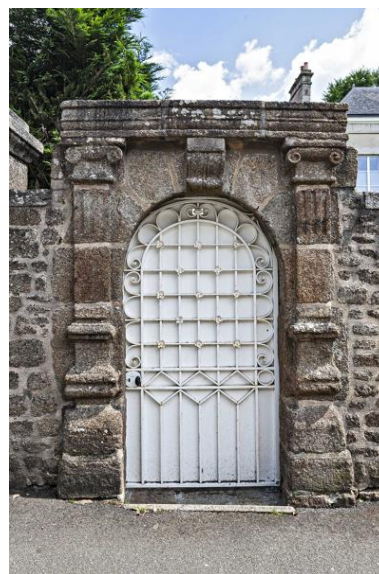
Portail extérieur, remploi provenant du 26 Grande-Rue. Phot. Yves Guillotin IVR52_20215300807NUCA
