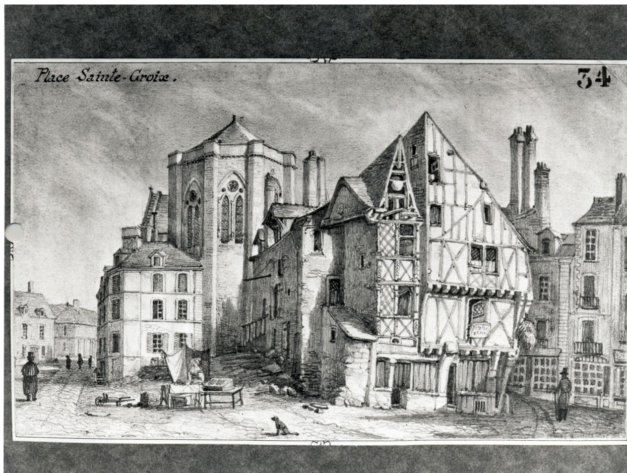
Place Ste Croix agrandie par la destruction de l'église Sainte-Croix et avant la démolition des maisons adossées au chevet de la cathédrale, dessin, par F. Benoist, [av. 1843].
