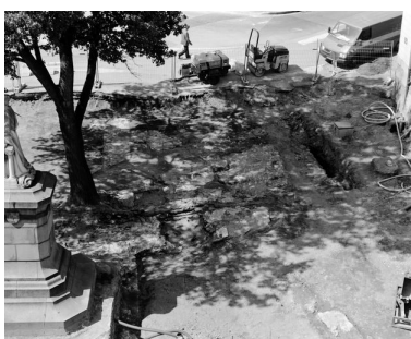
Le site, lors du chantier de fouilles, vu depuis le nord (de la maison d'Adam). Phot. François Lasa IVR52_19964900728X
