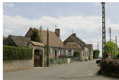
Jauzé, bourg : maison 1 et ensemble de Blanchetière vue depuis le Nord. Phot. François Lasa IVR52_20077200790NUCA
