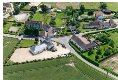
Vue aérienne partielle depuis l'ouest. Phot. Julien Hardy IVR52_20137201281NUCA
