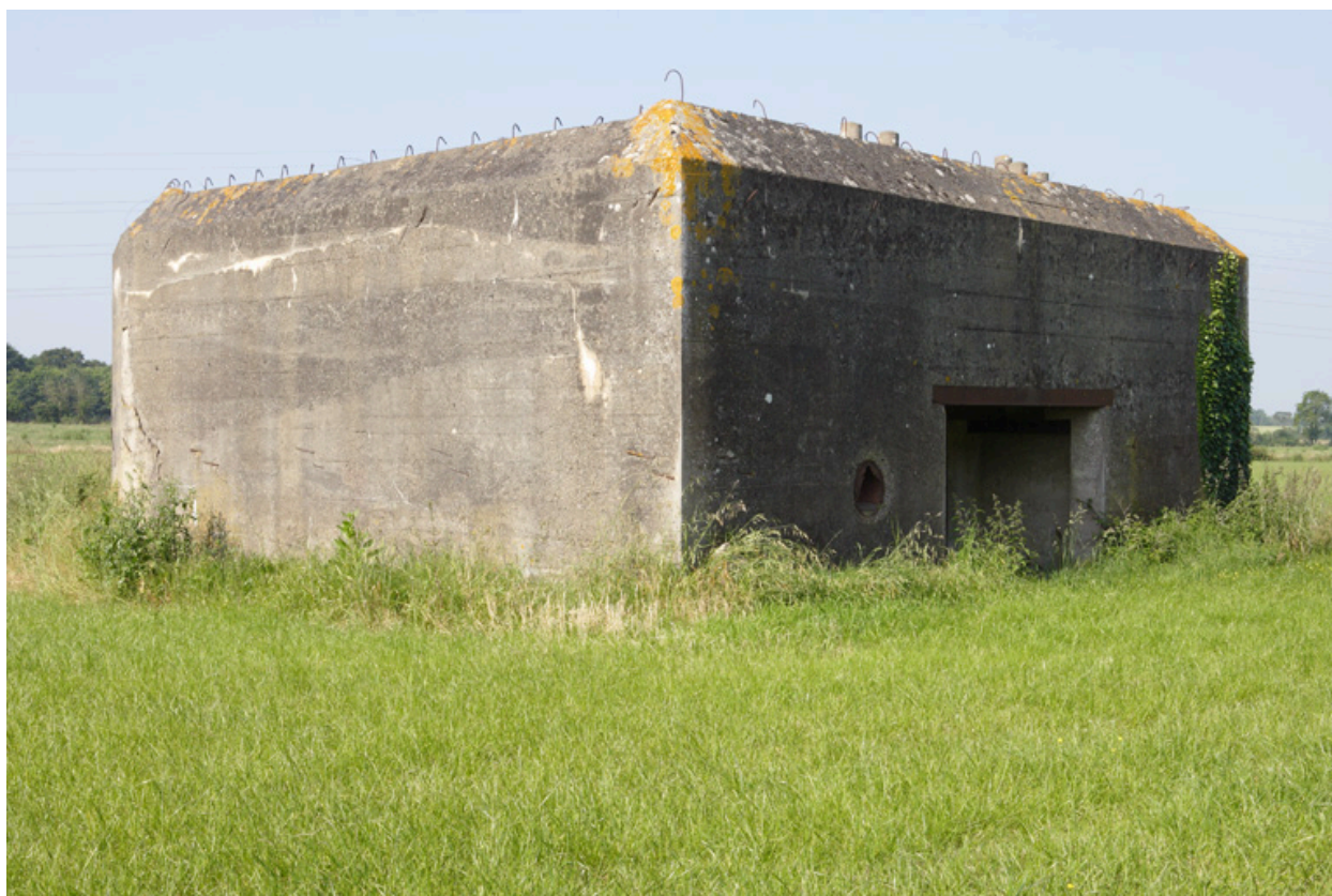
Vue de la casemate n° 1 (coté entrée).
