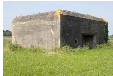
Vue de la casemate n° 1 (coté entrée). Phot. Denis Pillet IVR52_20084401745NUCA
