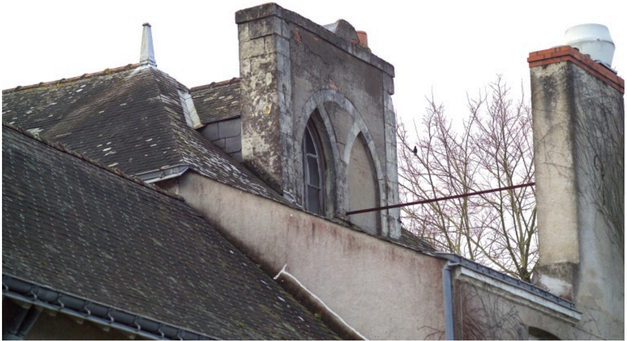
Partie principale, détail d'une souche de cheminée.
