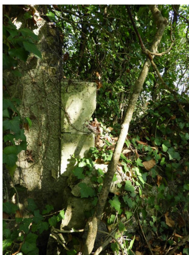
Vestiges d'un encadrement d'ouverture.
