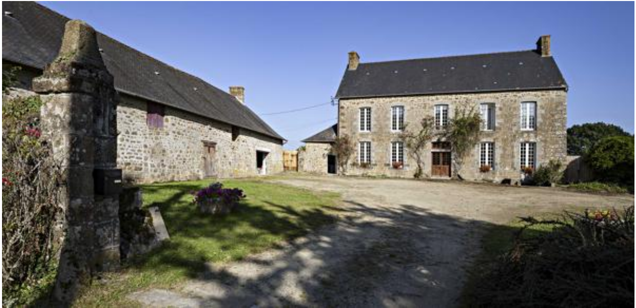
Maison de maître, façade sud.
