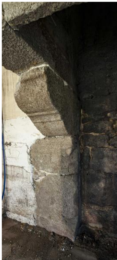
Ferme occidentale, logis central, cheminée. Phot. Yves Guillotin IVR52_20215301429NUCA
