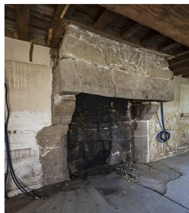
Ferme occidentale, logis central, cheminée. Phot. Yves Guillotin
