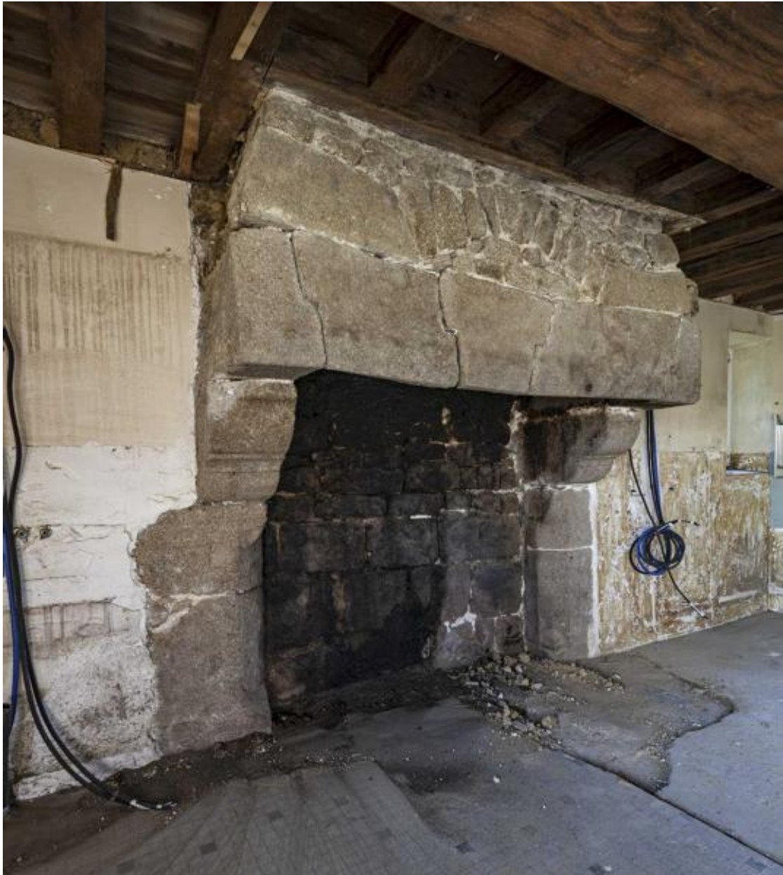
Ferme occidentale, logis central, cheminée.
