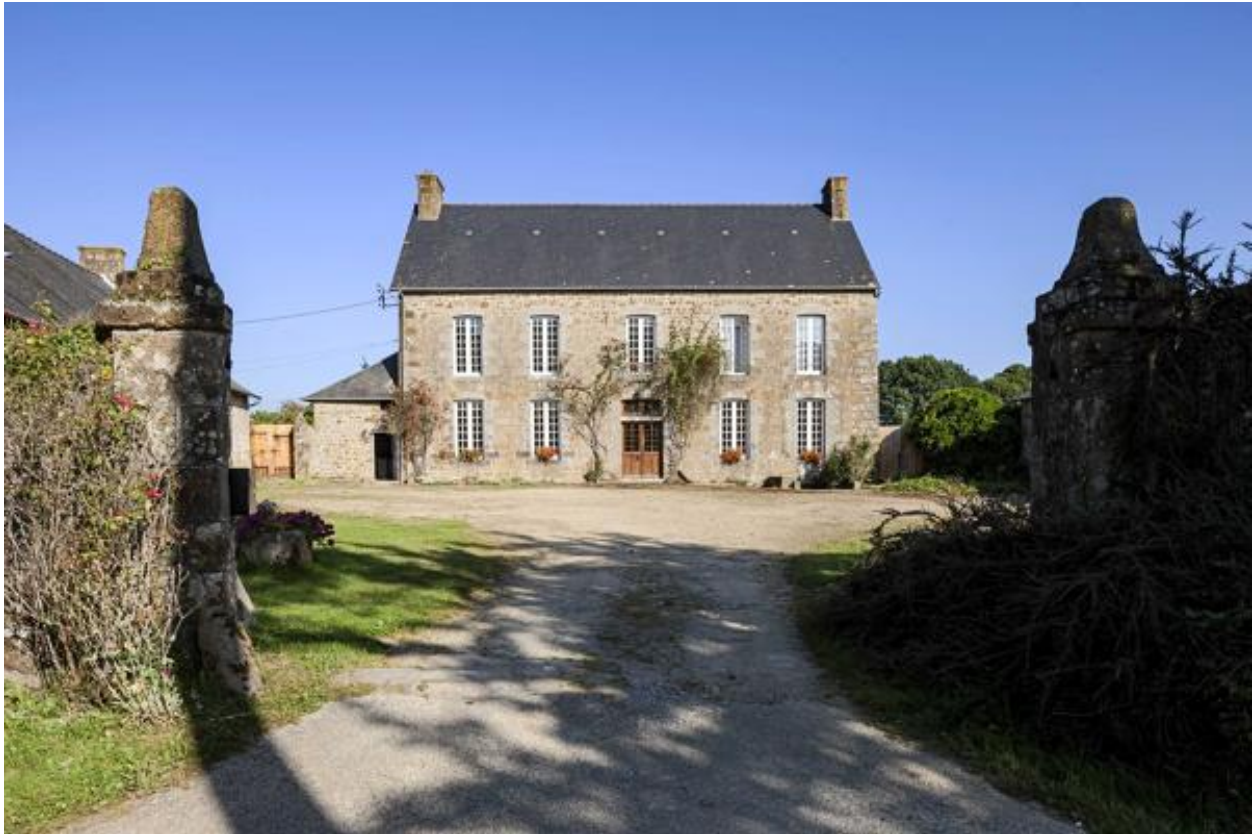
Maison de maître, façade sud.
