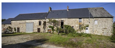
Ferme occidentale. Phot. Yves Guillotin IVR52_20215301426NUCA
