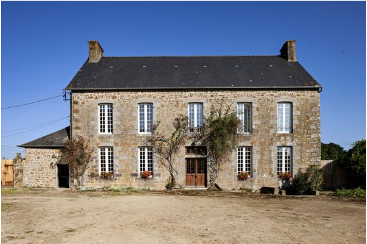
Maison de maître, façade sud.
