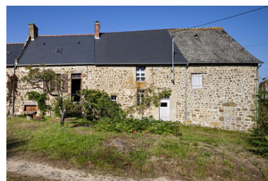
Ferme occidentale. Phot. Yves Guillotin IVR52_20215301425NUCA
