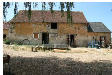
Dépendances : écuries, étable et grenier. Phot. Jean-Baptiste Darrasse IVR52_20067206758NUCA
