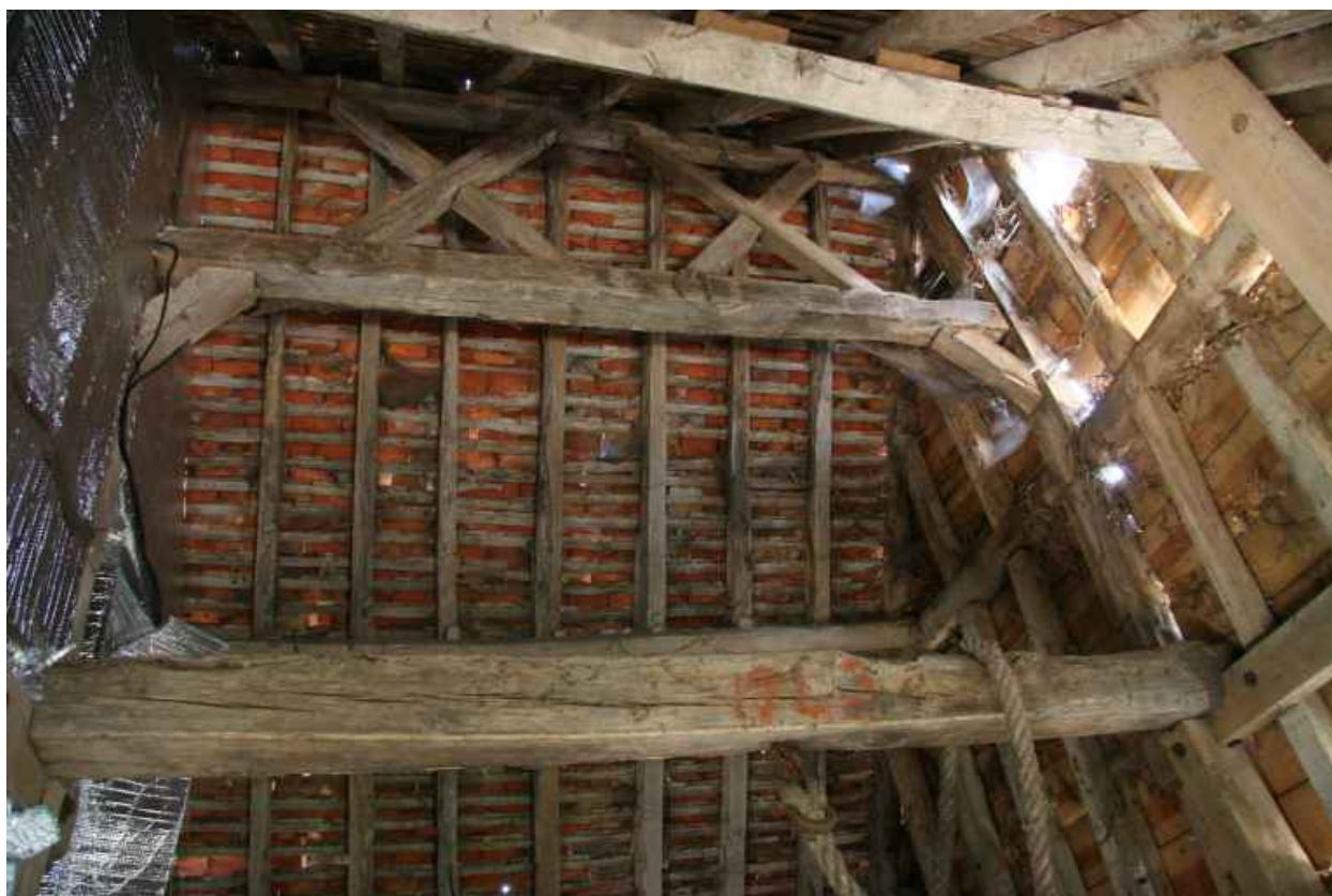
Charpente à pannes avec double sous-faîtage.
