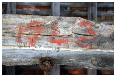
Sablière de sous-faîtage du moulin dont la date portée est 1743. Phot. Jean-Baptiste Darrasse IVR52_20067206748NUCA
