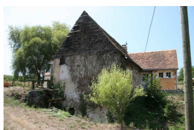
Pignon du moulin sur le bief. Phot. Jean-Baptiste Darrasse IVR52_20067206756NUCA
