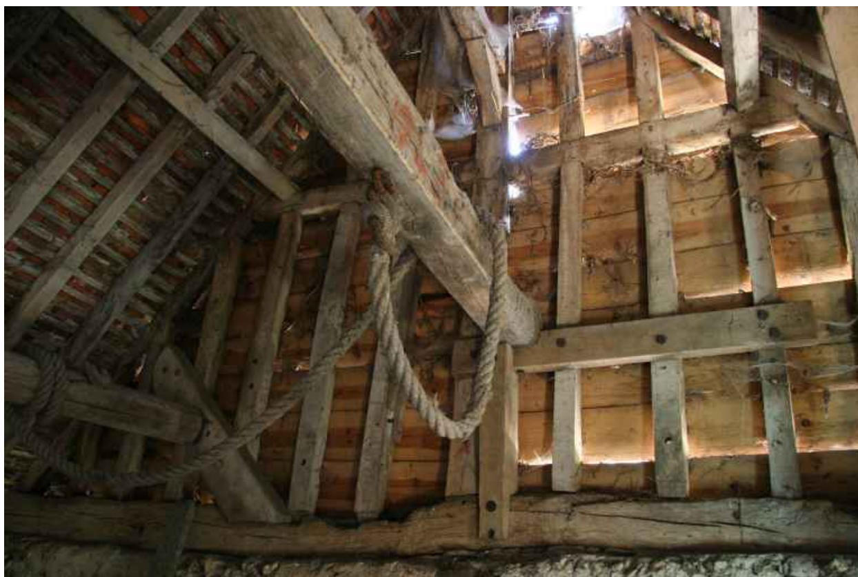
Pignon en charpente de la salle des meules.
