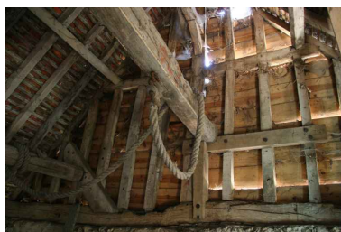
Pignon en charpente de la salle des meules. Phot. Jean-Baptiste Darrasse IVR52_20067206752NUCA
