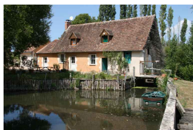
Vue de volume prise du bief. Phot. Jean-Baptiste Darrasse IVR52_20067206753NUCA
