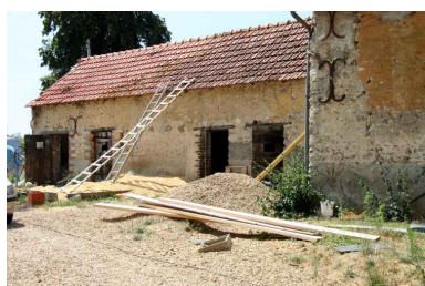
Dépendances : toit à porcs. Phot. Jean-Baptiste Darrasse IVR52_20067206759NUCA
