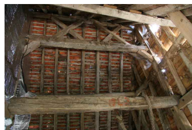
Charpente à pannes avec double sous-faîtage. Phot. Jean-Baptiste Darrasse IVR52_20067206749NUCA
