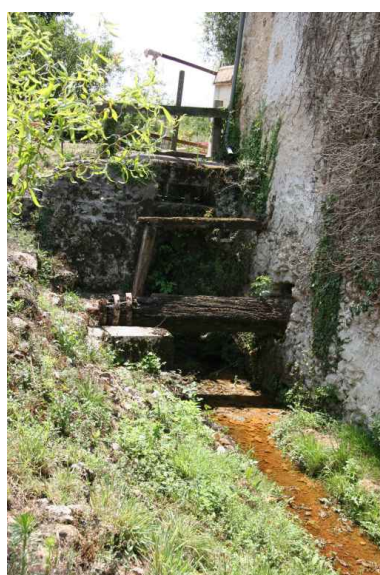
Pignon du moulin : la chute d'eau. Phot. Jean-Baptiste Darrasse IVR52_20067206754NUCA
