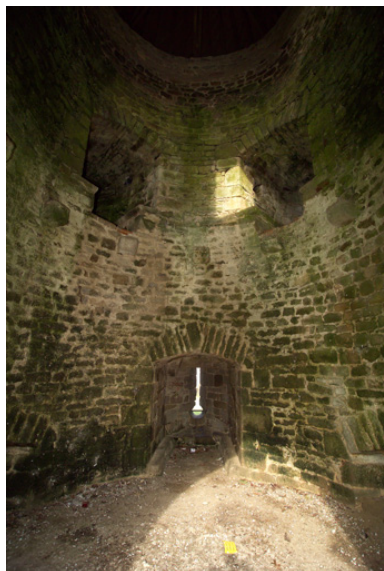
Élévation interne. Phot. Denis Pillet IVR52_20064402121NUCA
