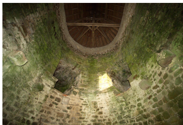
Élévation interne, premier étage. Phot. Denis Pillet IVR52_20064402120NUCA
