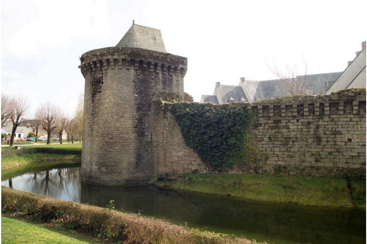
Vue générale vers le Sud-Est.
