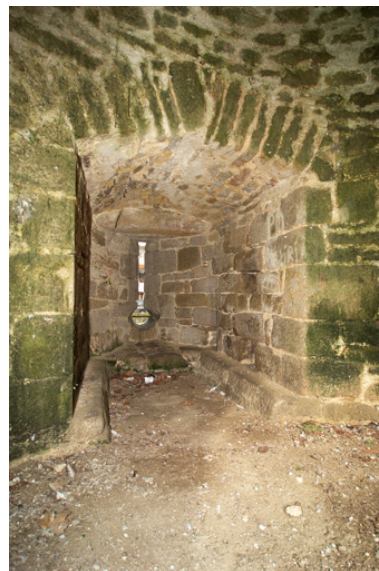
Ouverture de tir. Phot. Denis Pillet IVR52_20064402122NUCA
