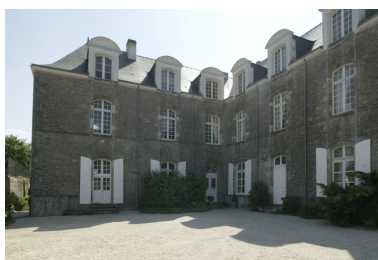
Vue de l'hôtel depuis la cour. Phot. Denis Pillet IVR52_20074401038NUCA
