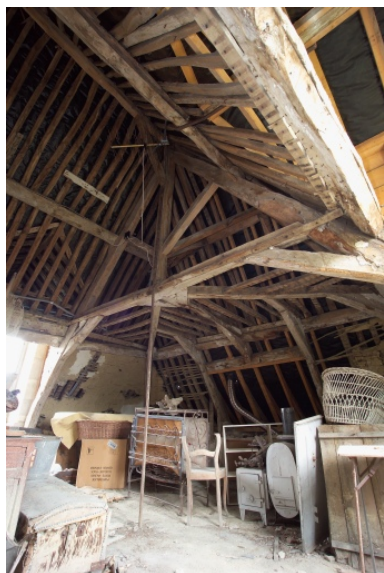
Vue de la croupe de charpente de l'aile sud. Phot. Denis Pillet IVR52_20074400846NUCA
