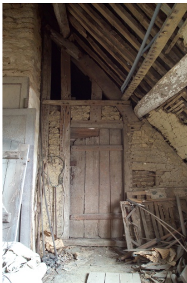
Cloison de torchis sur lattis dans le comble. Phot. Denis Pillet IVR52_20074400847NUCA
