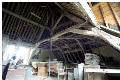
Vue de la croupe de charpente de l'aile sud. Phot. Denis Pillet IVR52_20074400845NUCA
