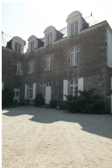
Vue de l'aile sud depuis la cour. Phot. Denis Pillet IVR52_20074401037NUCA
