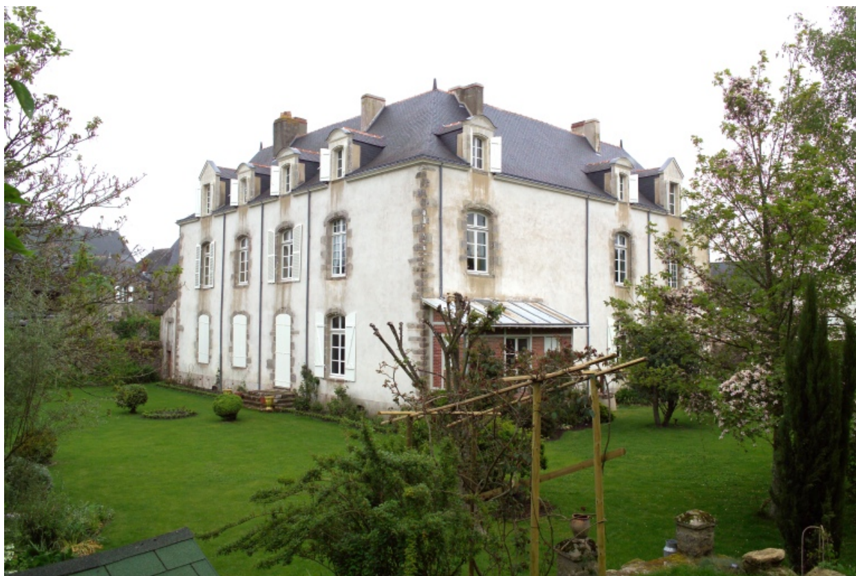
Vue des façades sur jardin.
