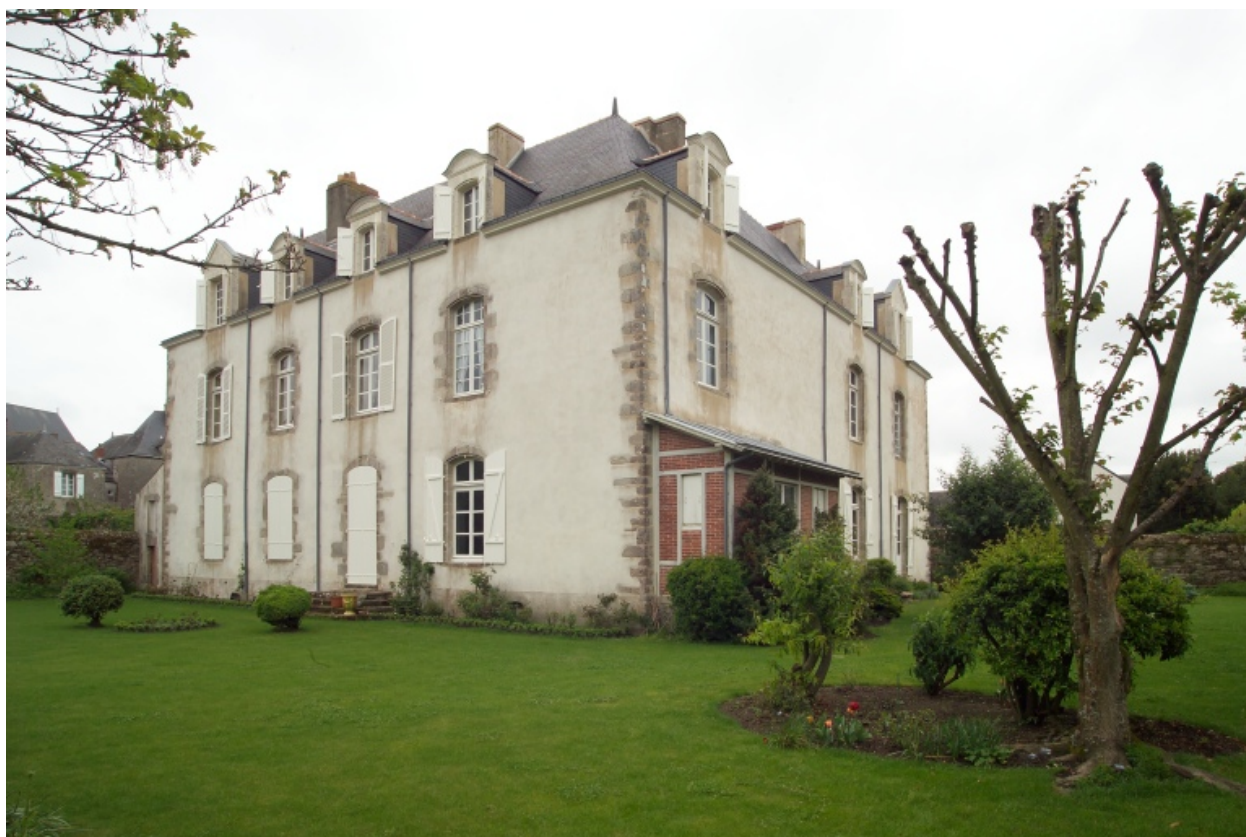
Vue des façades sur jardin.
