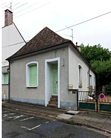
Ancienne maison du jardinier dite des Grands Jardins, actuellement 3, rue de Luynes. Phot. Yves Guillotin IVR52_20177200716NUCA
