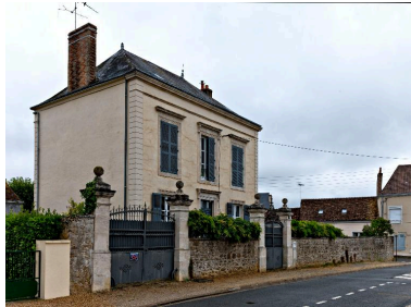
Maison 4, rue d'Isly, construite vers 1881.
