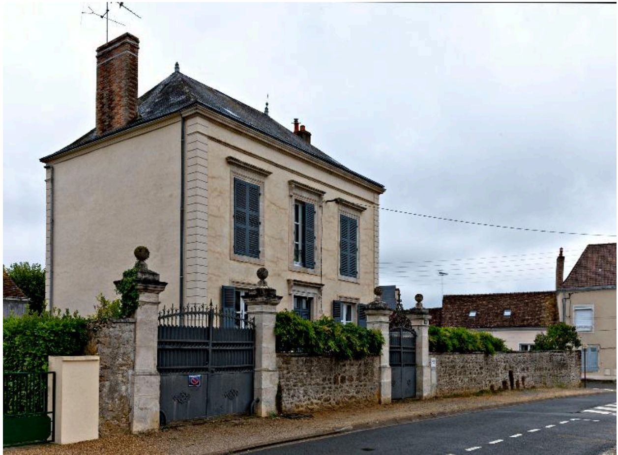
Maison 4, rue d'Isly, construite vers 1881.
