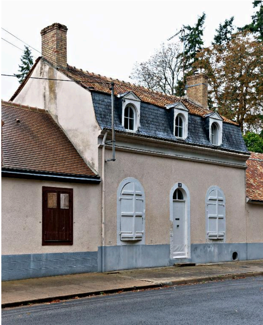
Maison 24, rue de Luynes, 1 ère moitié du XIX e siècle.
