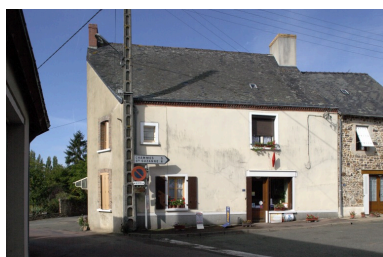
Vue depuis la place. Phot. François Lasa IVR52_20055302033NUCA
