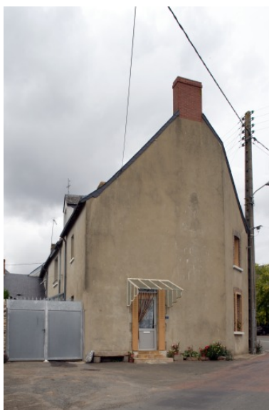
Vue depuis la route de Saint-Jean. Phot. François Lasa IVR52_20055302128NUCA
