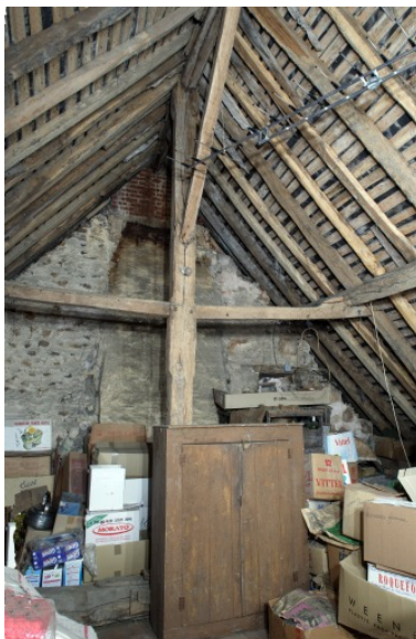
Comble : la ferme de charpente sud vue depuis le nord. Phot. François Lasa IVR52_20055302129NUCA
