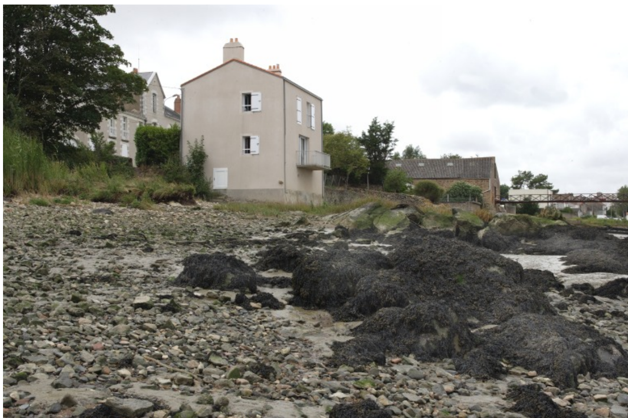
La rive nord de l'îlot 2, de l'amont vers l'aval.
