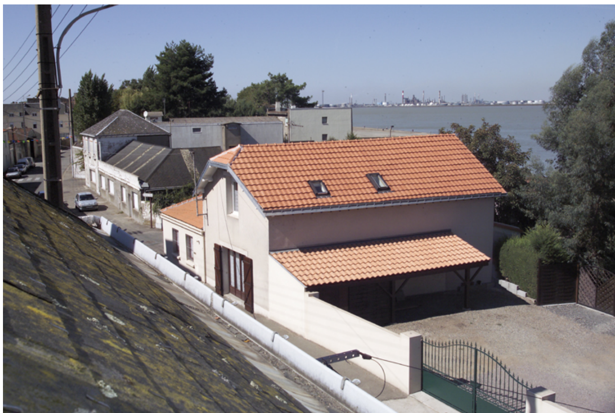
Vue de la façade sud de l'îlot 2 depuis la maison n° 5 rue Pitre-Chevalier vers l'aval.
