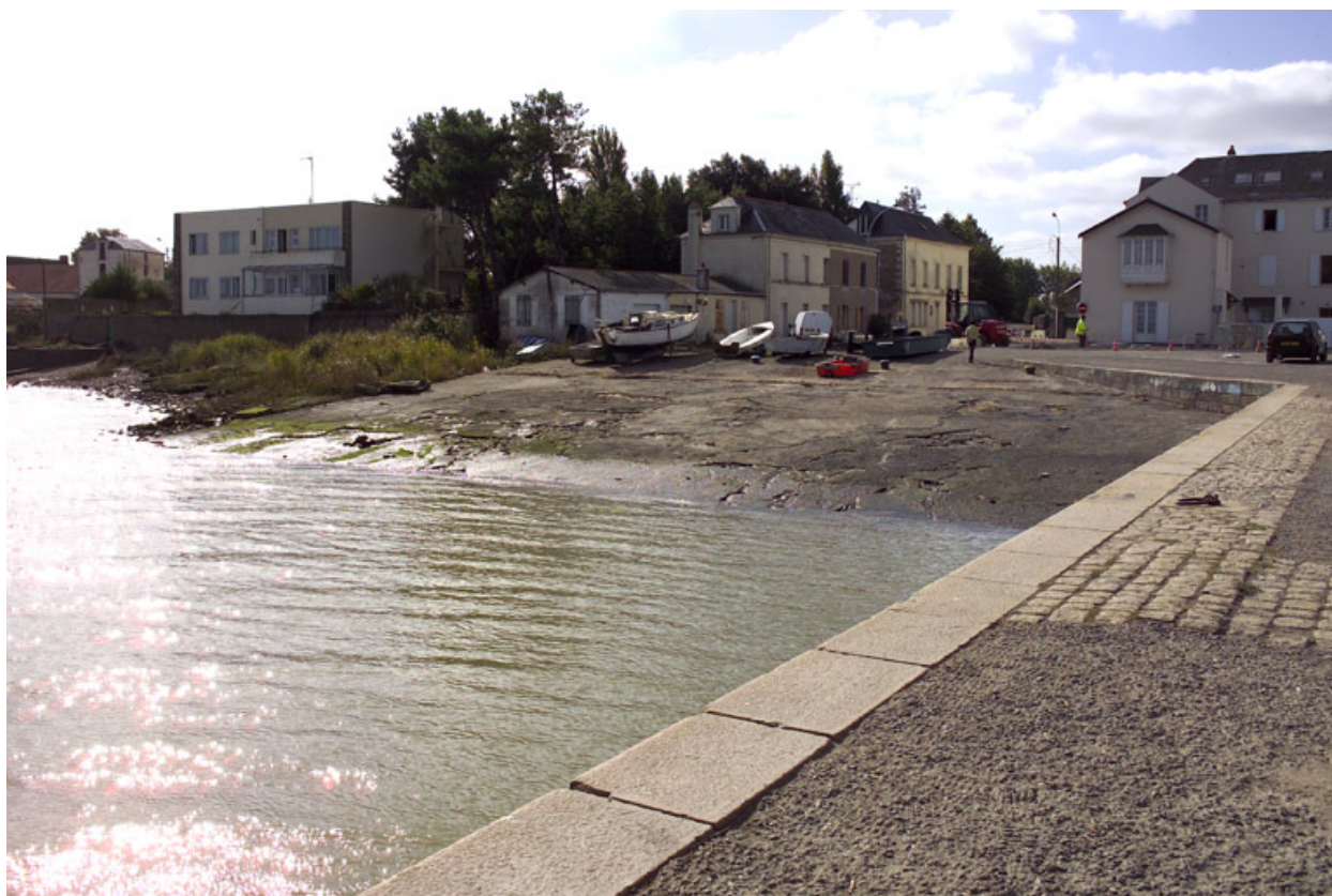
La rive nord de l'îlot 2, le quai Sadi-Carnot.
