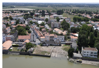
Vue aérienne de la partie aval, 2010. Phot. Denis Pillet IVR52_20104401369NUCA
