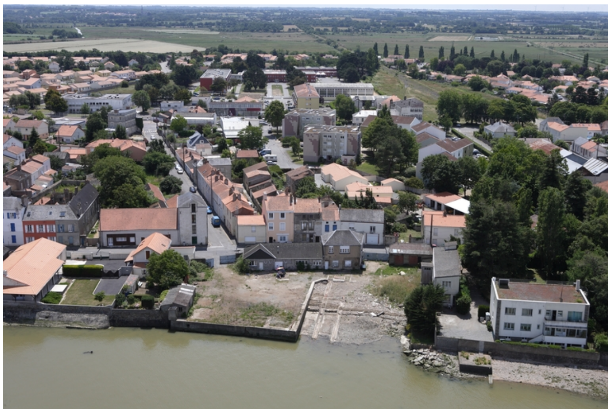
Vue aérienne de la partie aval, 2010.
