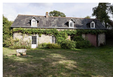
Maison et remise, sud-est de la maison principale. Phot. Yves Guillotin IVR52_20205300282NUCA
