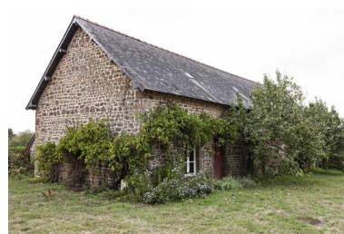
Fournil et étable, nord- ouest de la Guette. Phot. Yves Guillotin IVR52_20205300294NUCA
