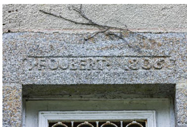
Linteau de porte de la maison, portant l'inscription "I. FOUBERT 1806" Phot. Yves Guillotin IVR52_20235301241NUCA
