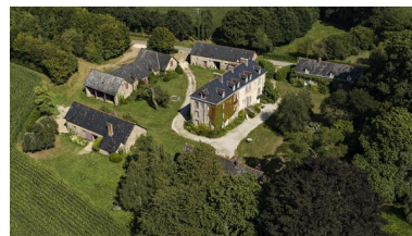
Vue aérienne. Phot. Yves Guillotin IVR52_20215301475NUCA
