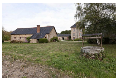
Fournil et étable, nord-ouest de la Guette. Phot. Yves Guillotin IVR52_20205300292NUCA
