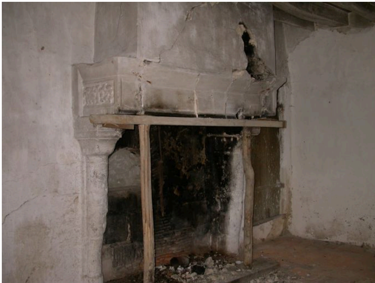
Rez-de-chaussée surélevé, salle nord : cheminée fin XVe siècle.
