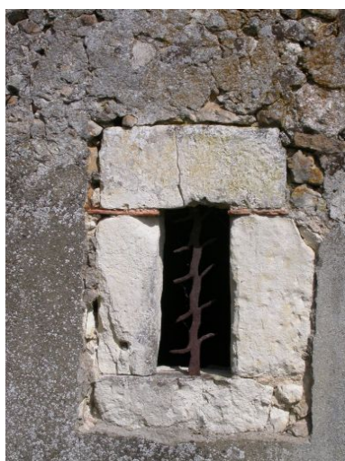
Aération sur la façade postérieure. Phot. Christine Toulhier IVR52_20047205141NUCA
