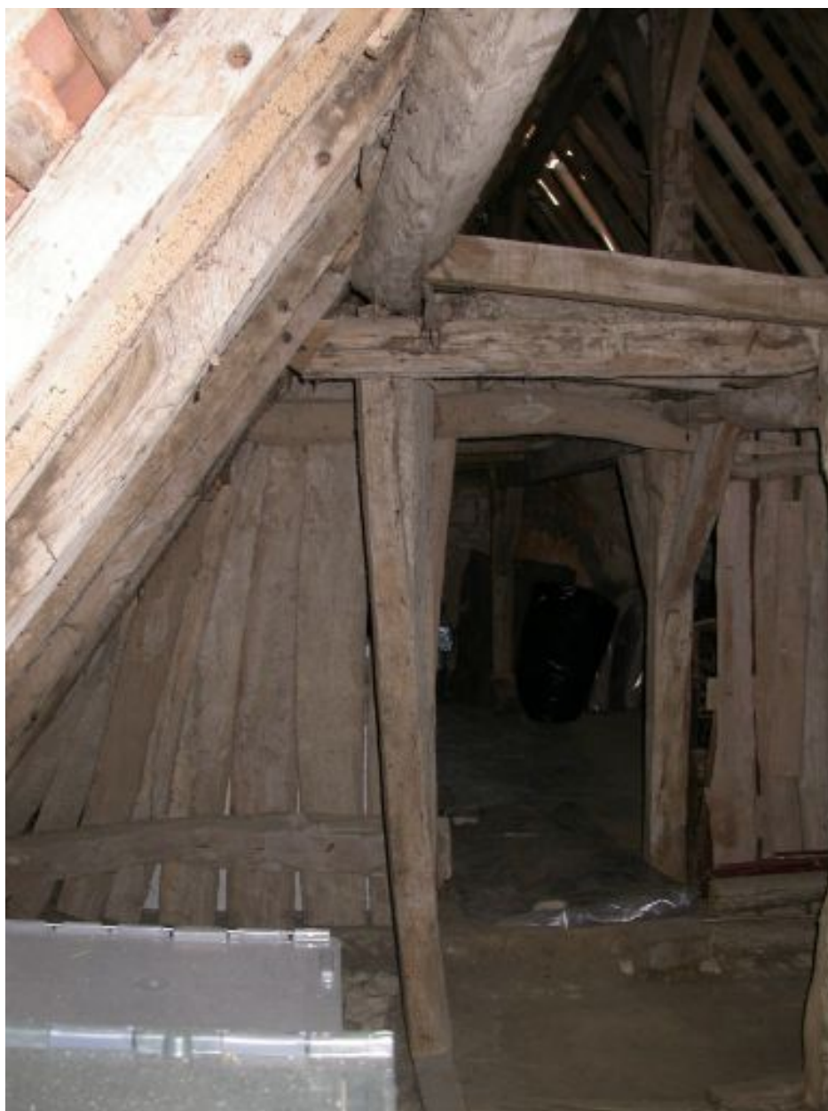
Les combles : cloison en planches (aix).
