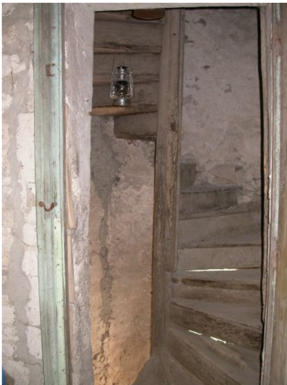
Escalier en vis en bois : palier du rez-de-chaussée surélevé.
