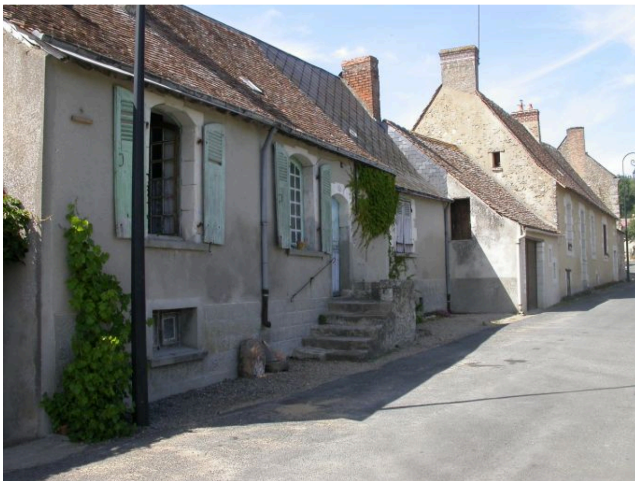
Façade antérieure sur rue.
