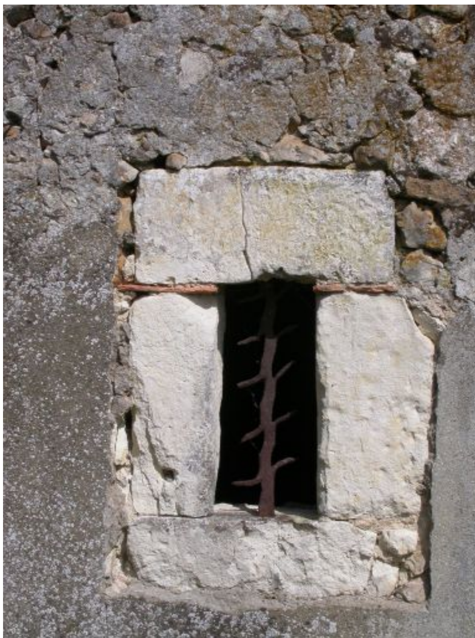
Aération sur la façade postérieure.
