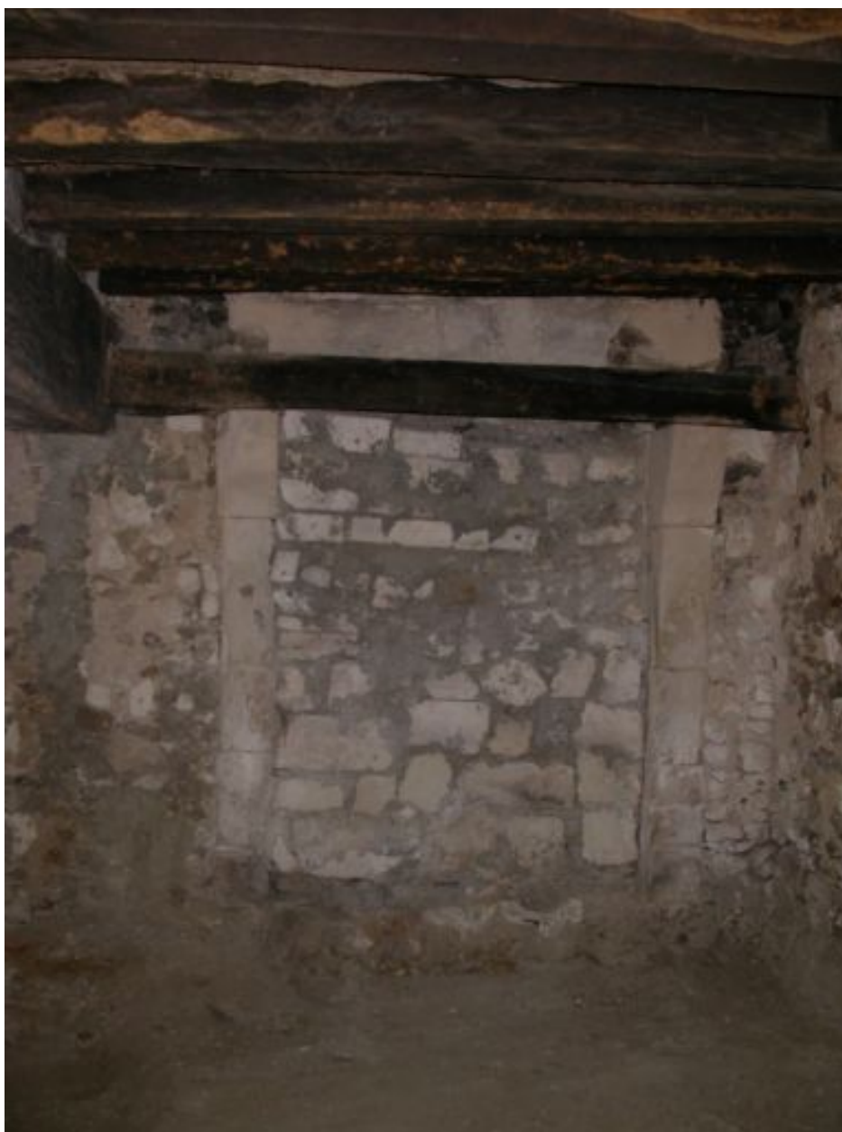
Entresol : vestige d'une cheminée tronquée.
