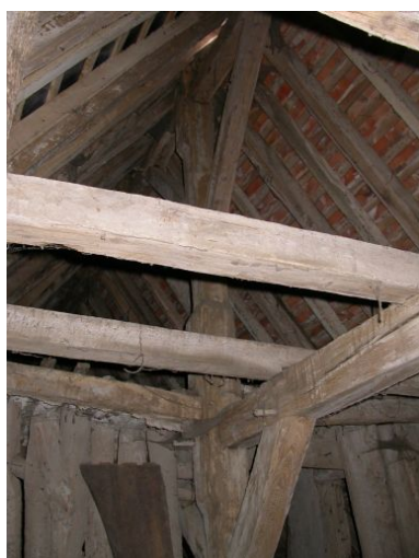
Charpente avec sous-faîtage. Phot. Christine Toulhier IVR52_20047205137NUCA
