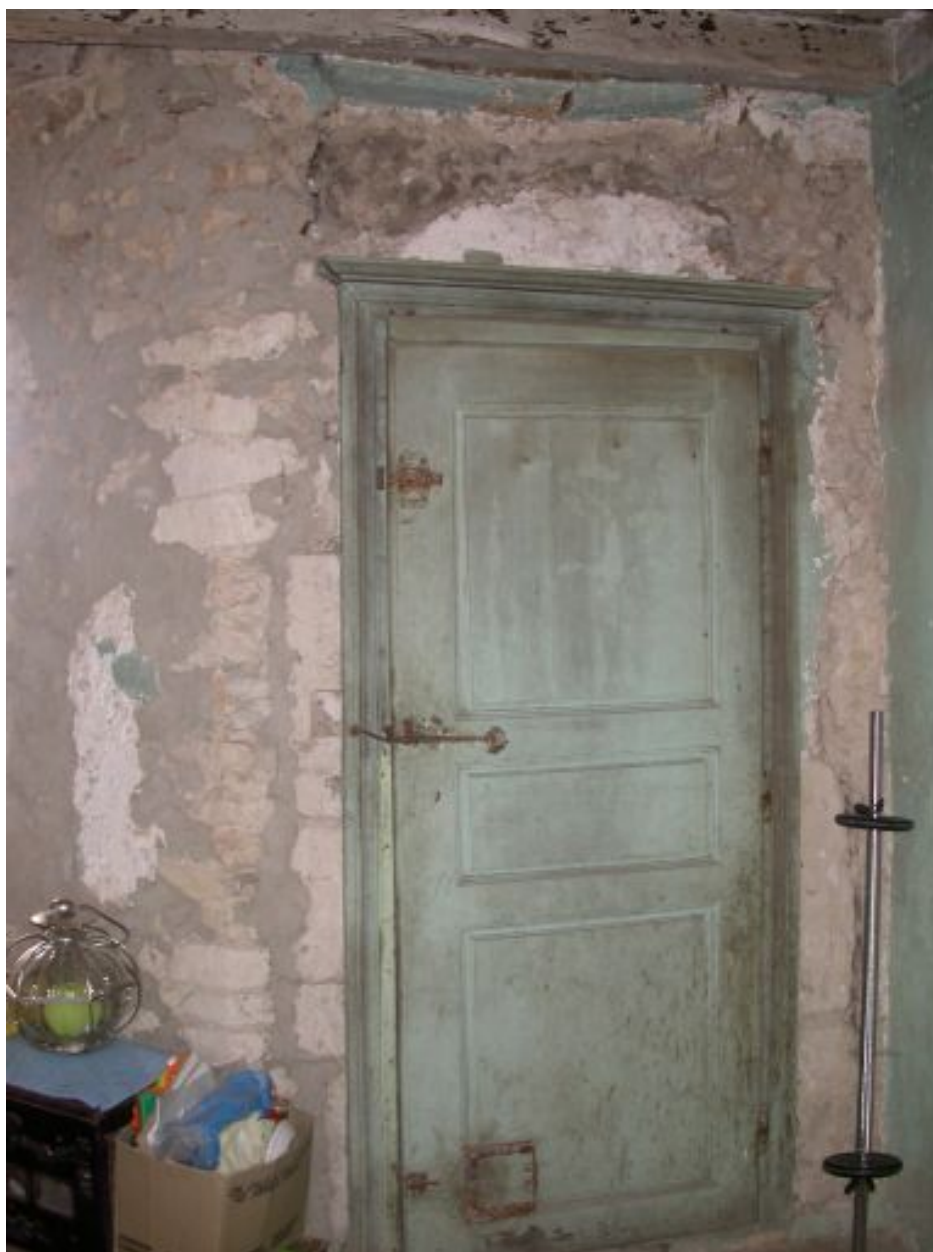
Porte de l'escalier dans la salle.
