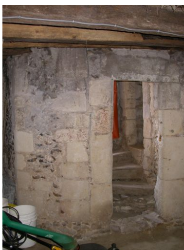
Cage d'escalier en pierre : niveau entresol. Phot. Christine Toulhier IVR52_20047205125NUCA
