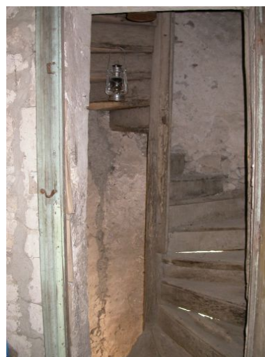
Escalier en vis en bois : palier du rez-de-chaussée surélevé. Phot. Christine Toulhier IVR52_20047205133NUCA
