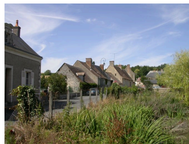
Vue d'ensemble. Phot. Christine Toulhier IVR52_20047205123NUCA
