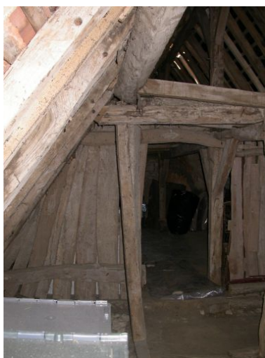
Les combles : cloison en planches (aix). Phot. Christine Toulhier IVR52_20047205139NUCA
