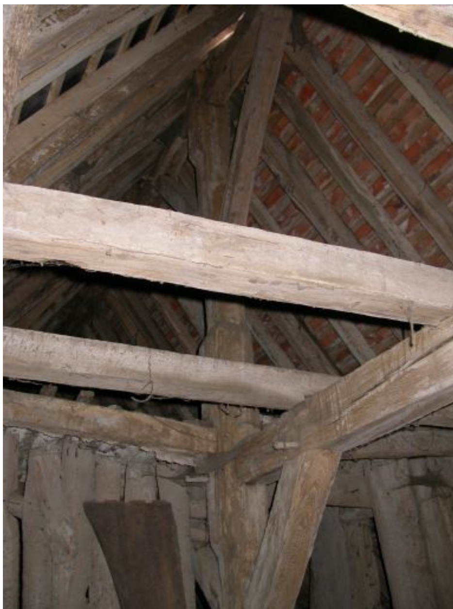
Charpente avec sous-faîtage.
