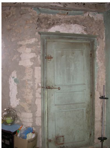
Porte de l'escalier dans la salle. Phot. Christine Toulhier IVR52_20047205135NUCA
