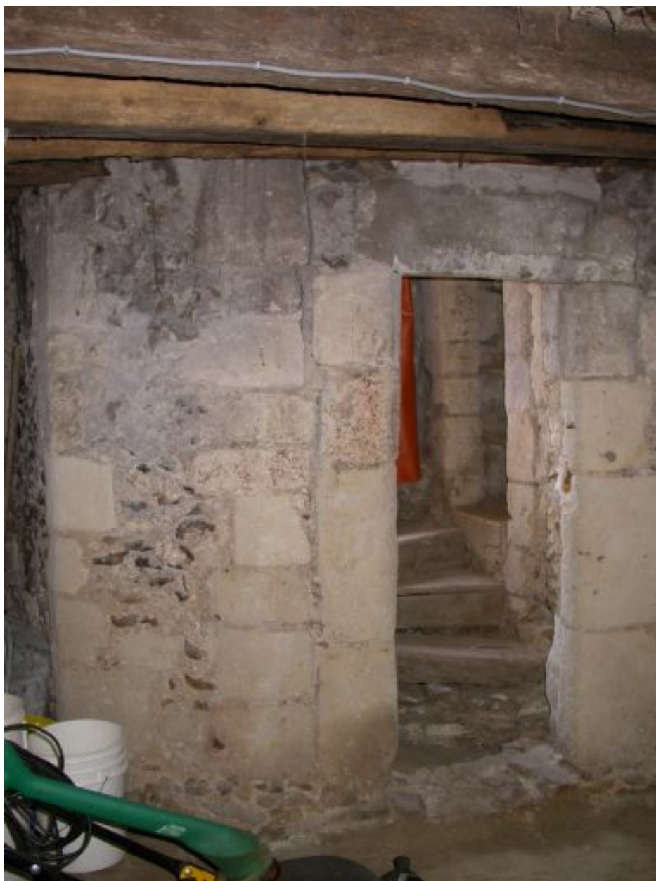
Cage d'escalier en pierre : niveau entresol.
