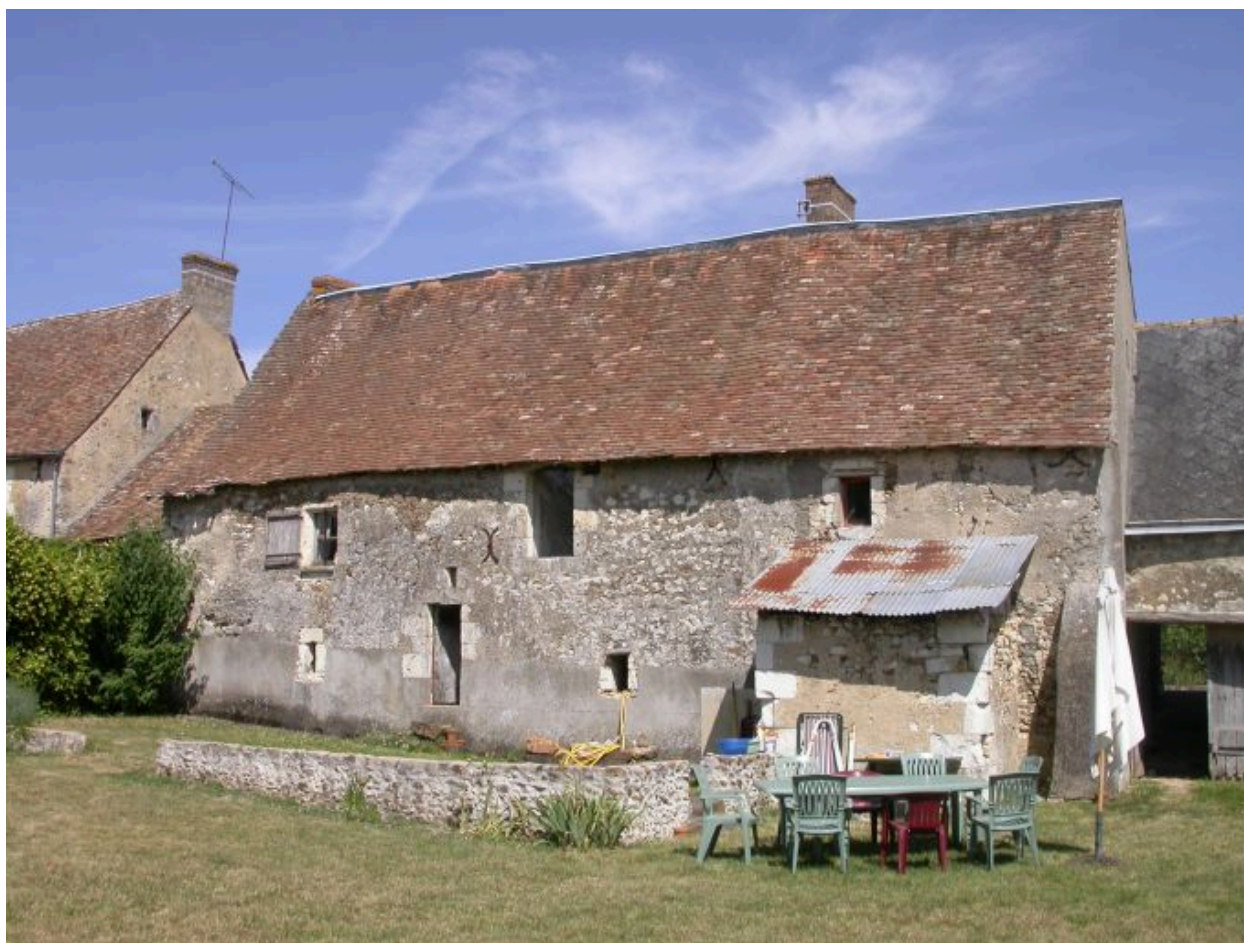
Façade postérieure sur le jardin : pas ou peu d'ouverture.
