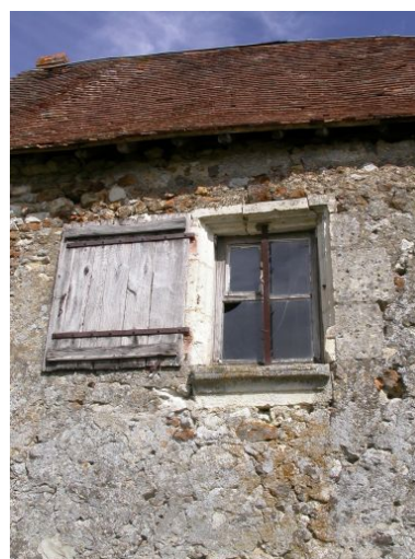
Façade sur le jardin : petite baie moulurée fin XVe siècle. Phot. Christine Toulhier IVR52_20047205140NUCA
