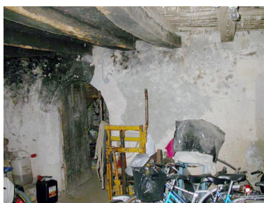
Entresol : porte plein cintre. Phot. Christine Toulhier IVR52_20047205127NUCA
