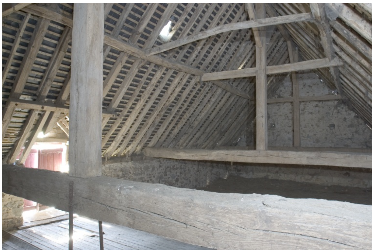
La charpente de l'étable-grange vue depuis l'est.
