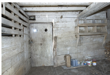
Intérieur de l'étable-grange-remise : l'étable à chevaux. A gauche la cloison la séparant du fond de grange ; à droite celle la séparant de la cave. Phot. François Lasa IVR52_20045302601NUCA
