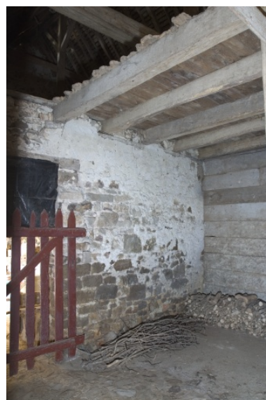
Intérieur de l'étable-grange-remise : le fond de grange. A gauche le mur le séparant de l'étable à vaches ; à droite la cloison le séparant de la cave. Phot. François Lasa IVR52_20045302599NUCA
