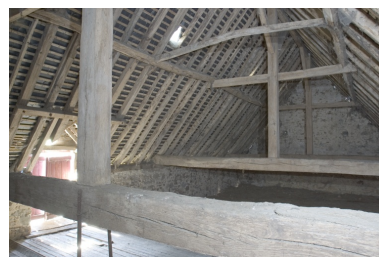
La charpente de l'étable-grange vue depuis l'est. Phot. François Lasa IVR52_20045302602NUCA
