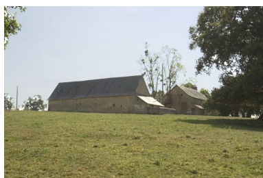
Vue d'ensemble depuis le chemin menant aux Chataigneraies au nord. À gauche, l'étable- grange-remise ; à droite, le logis. Phot. François Lasa IVR52_20045302593NUCA
