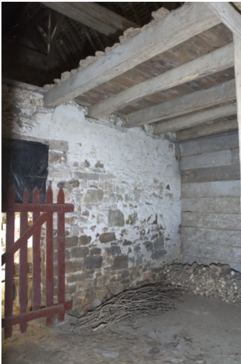
Intérieur de l'étable-grange-remise : le fond de grange. A gauche le mur le séparant de l'étable à vaches ; à droite la cloison le séparant de la cave.
