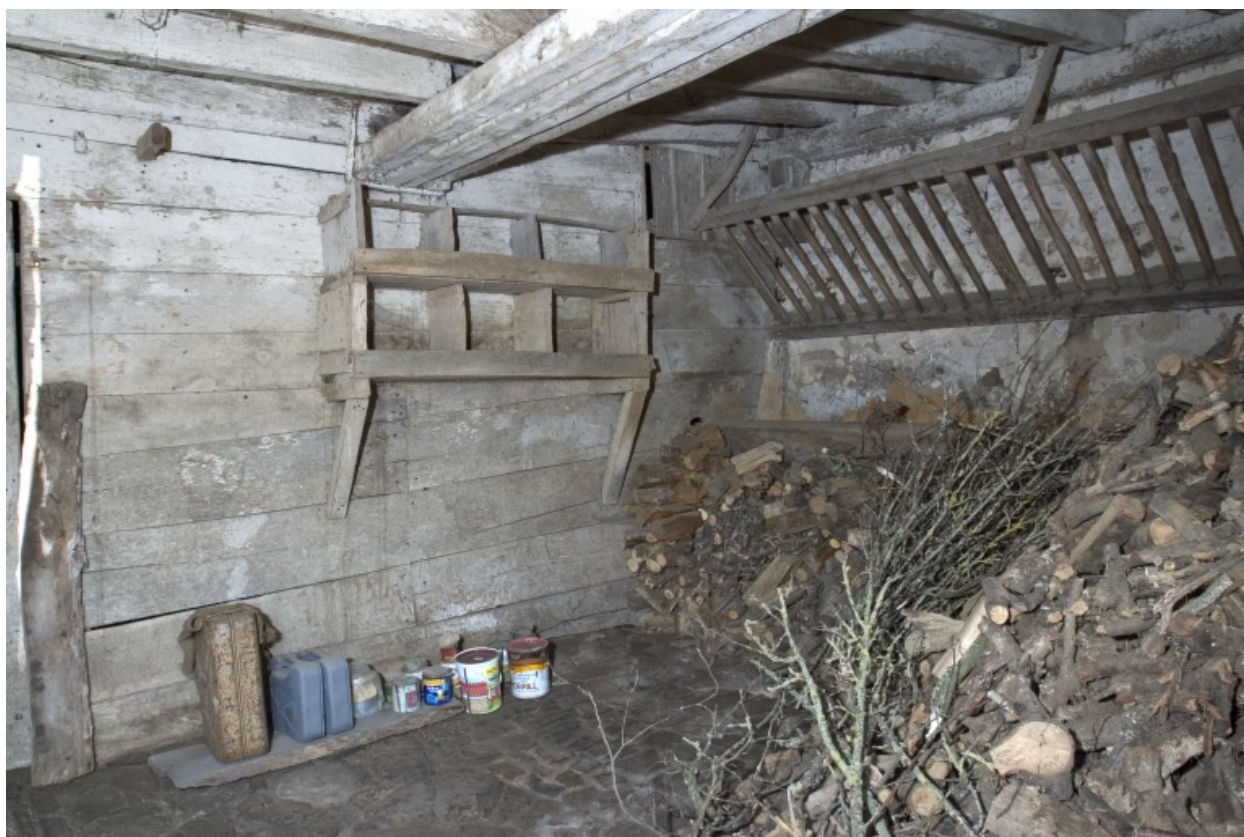
Intérieur de l'étable-grange-remise : l'étable à chevaux. A gauche la cloison la séparant de la cave ; à droite le mur la séparant de la remise.
