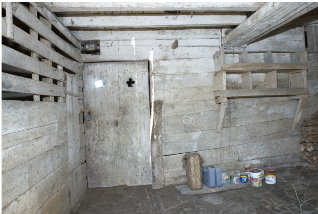
Intérieur de l'étable-grange-remise : l'étable à chevaux. A gauche la cloison la séparant du fond de grange ; à droite celle la séparant de la cave.
