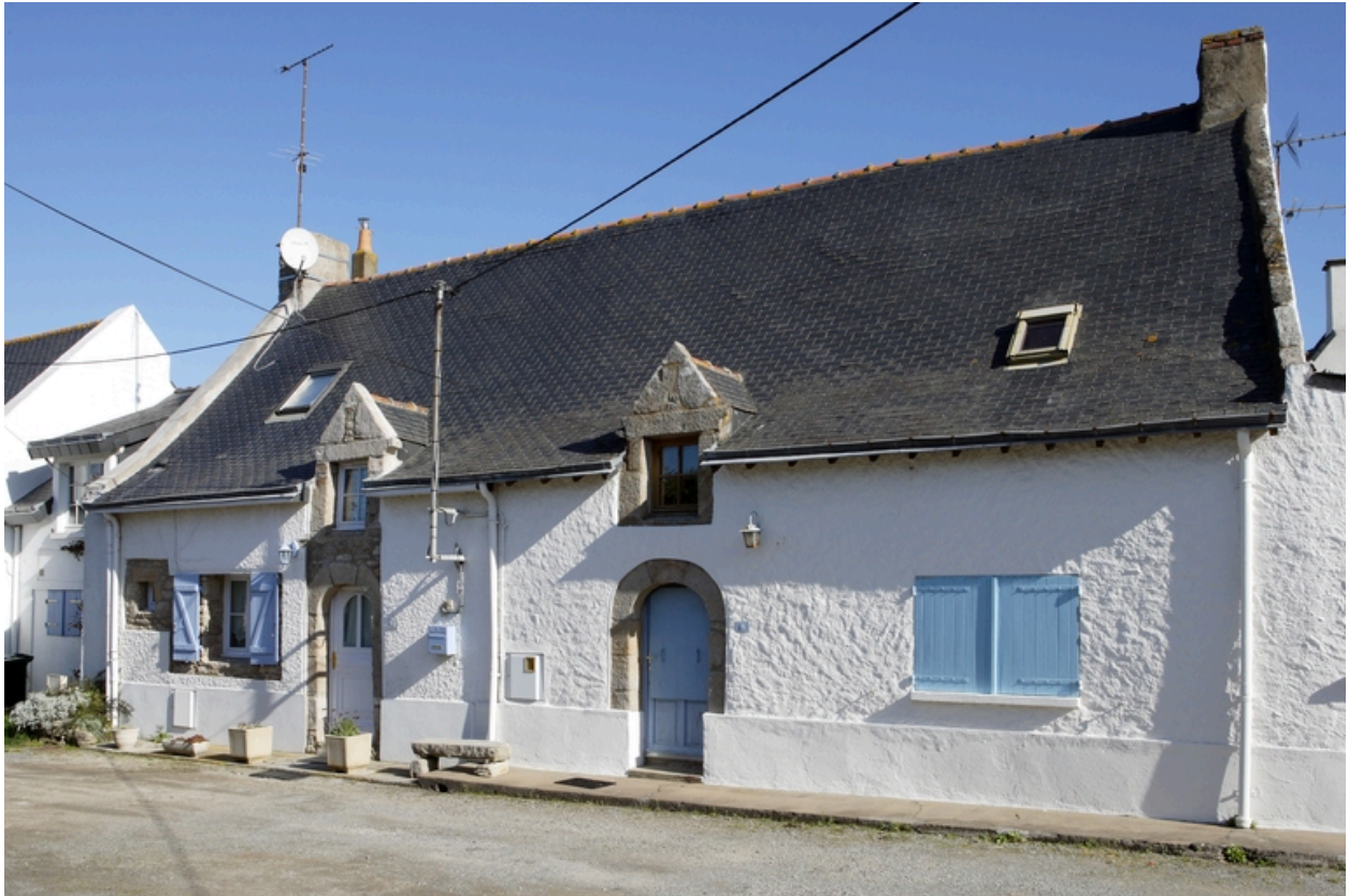
Vue des n° 8 et 10 rue de la Fontaine.
