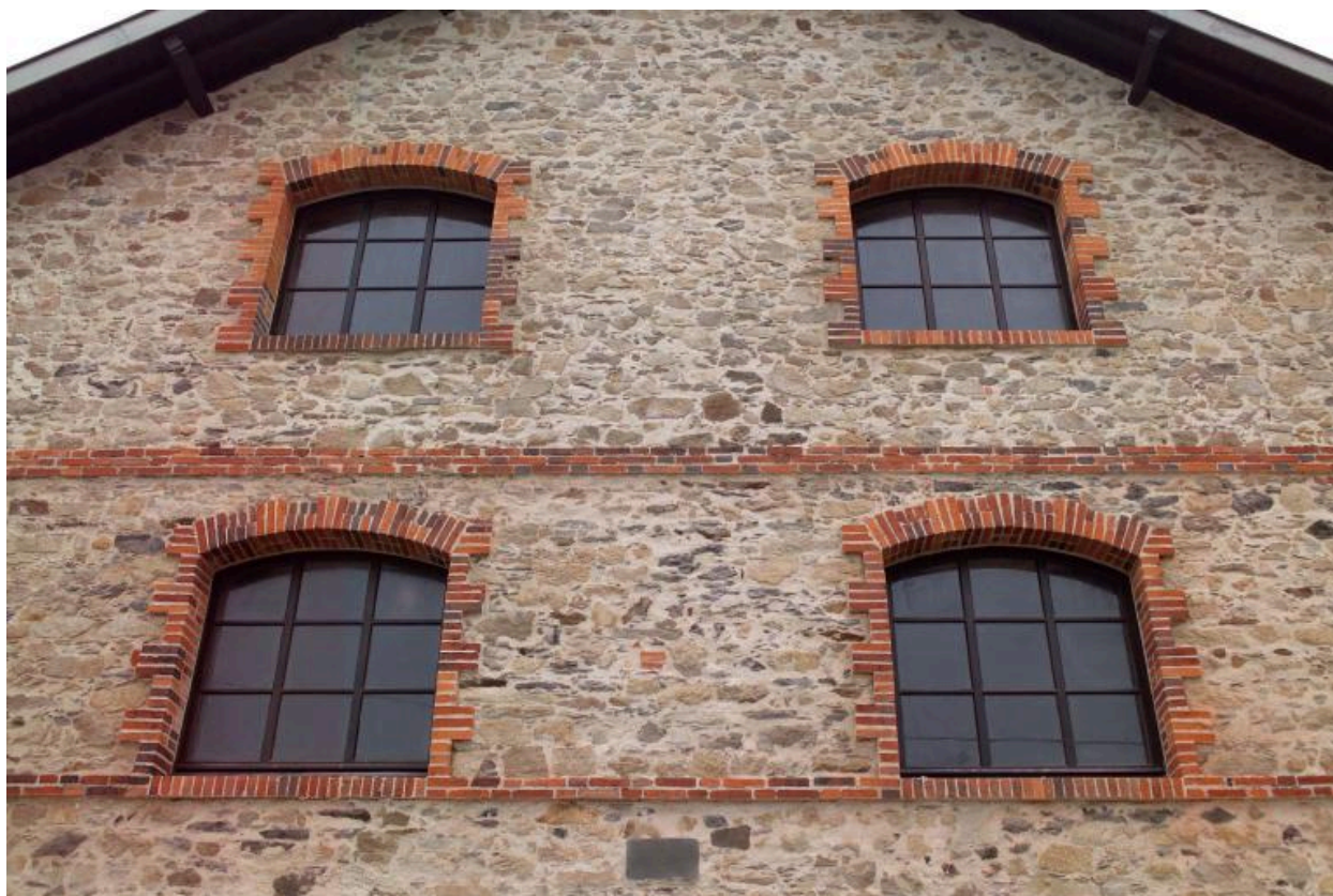
Détails de mise en oeuvre : bâtiment central, fenêtres du mur-pignon nord.
