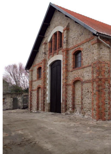
Bâtiment est. Mur-pignon nord.
