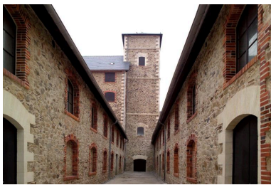
Façade ouest du bâtiment central (A, G, B du plan) et est du bâtiment est, vues du nord de l'allée entre eux.
