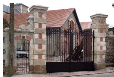
Portail d'entrée nord-est, à l'angle du chemin de Buzard et de la rue Réaumur. Phot. Denis Pillet IVR52_20054402094NUCA
