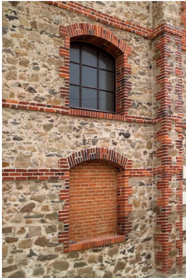
Détails de mise en oeuvre : bâtiment central, mur ouest. Phot. Denis Pillet IVR52_20054402076NUCA
