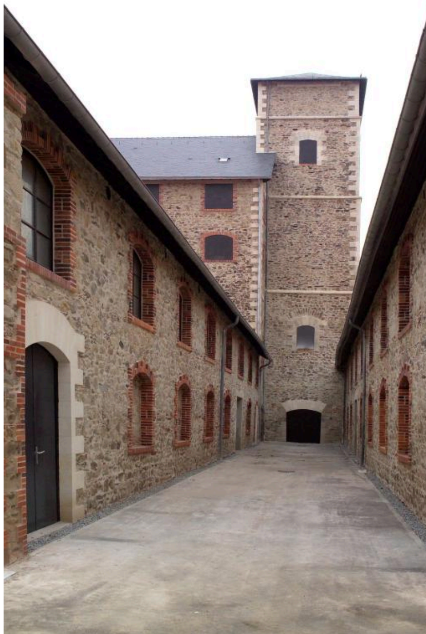
Façade ouest du bâtiment central (A, G, B du plan) et est du bâtiment est, vues du nord de l'allée entre eux.
