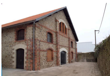
Bâtiment ouest. Mur-pignon nord.
