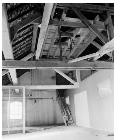
Tour. Vue du dernier étage. État en 1989. Phot. Denis Pillet IVR52_19894401726X
