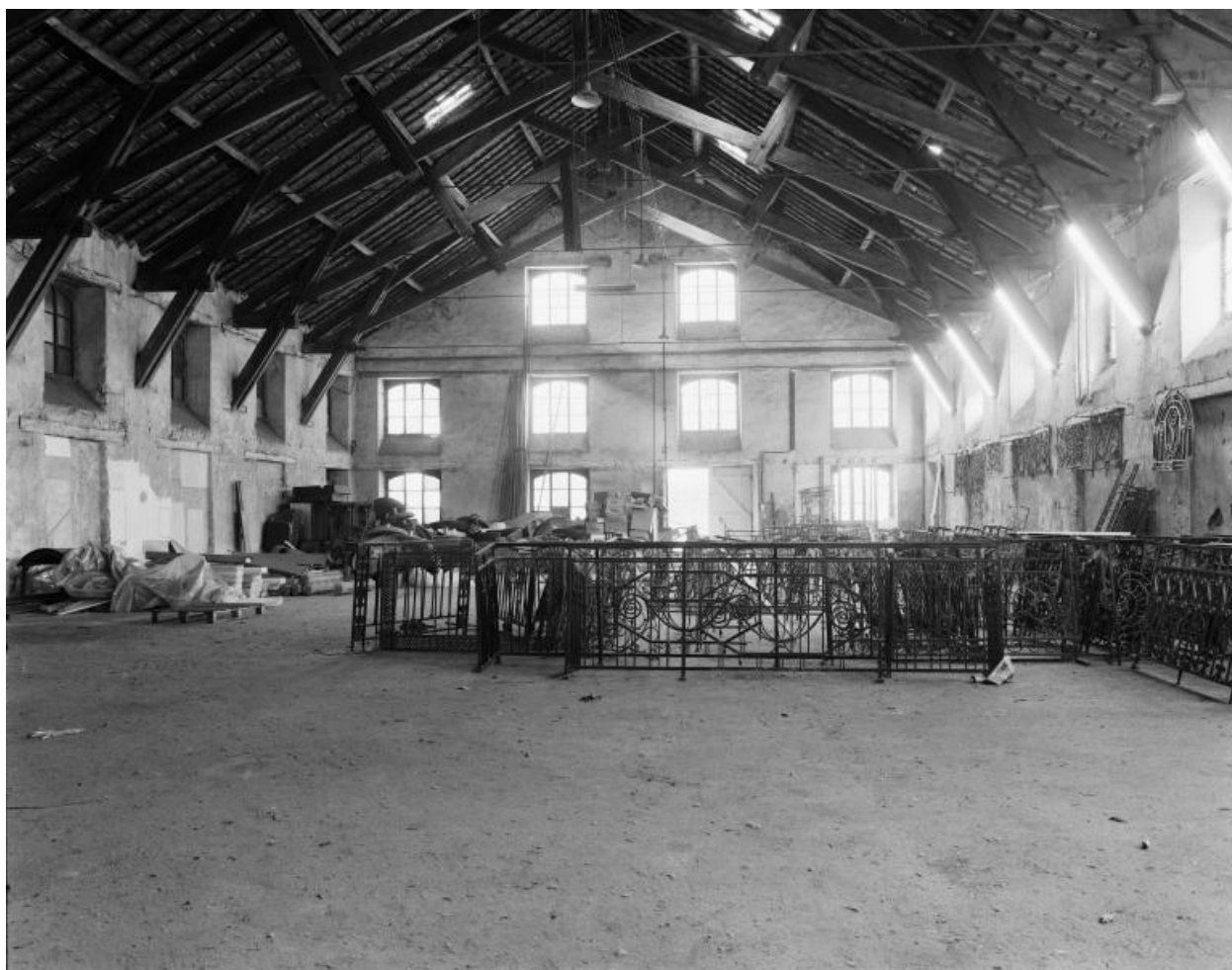
Bâtiment central. Intérieur vu du sud. État en 1989.
