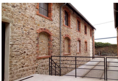
Façade est du bâtiment central (B, G du plan) vue du sud de l'allée entre les bâtiments ouest et central.
