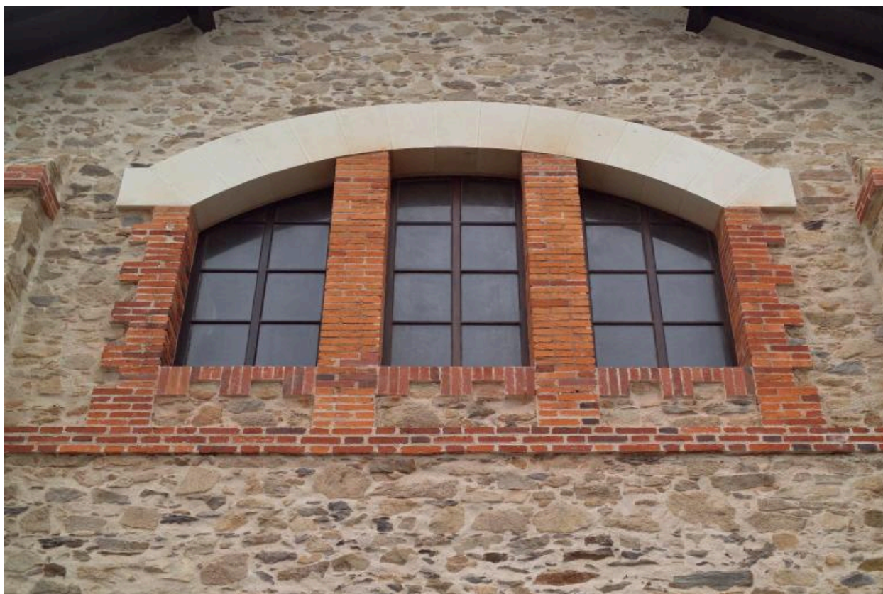
Bâtiment est. Mur-pignon nord. Fenêtre située au-dessus de la porte.
