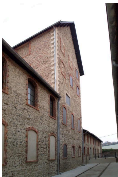
Façade est du bâtiment central (A, B, G du plan) vue du sud de l'allée entre les bâtiments ouest et central.
