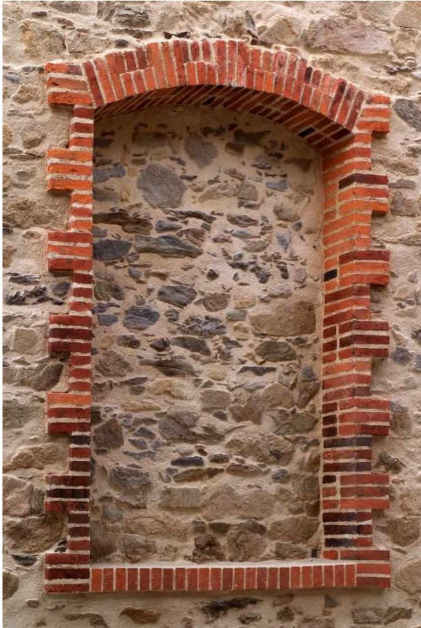
Détail de mise en oeuvre : fausse fenêtre.
