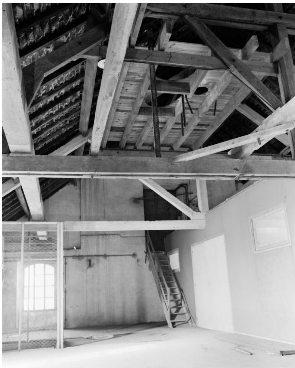
Tour. Vue du dernier étage. État en 1989.
