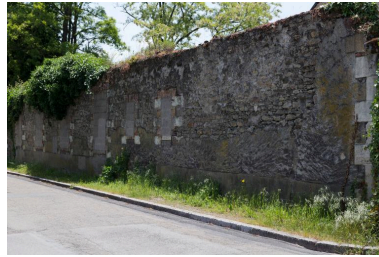
Ancienne façade ouest. Phot. Denis Pillet IVR52_20134402229NUCA
