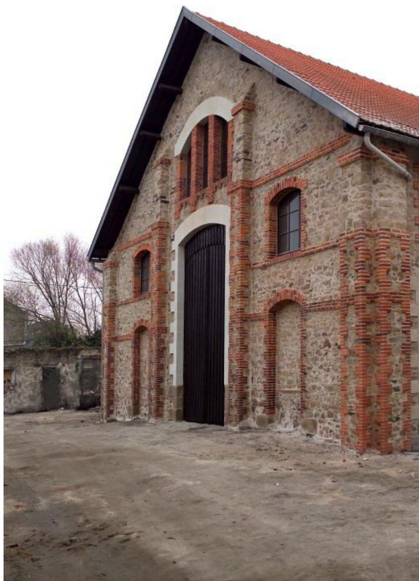
Bâtiment est. Mur-pignon nord.
