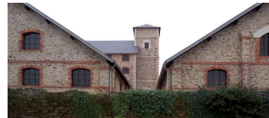
Bâtiments central et ouest vus du chemin de Buzard.
