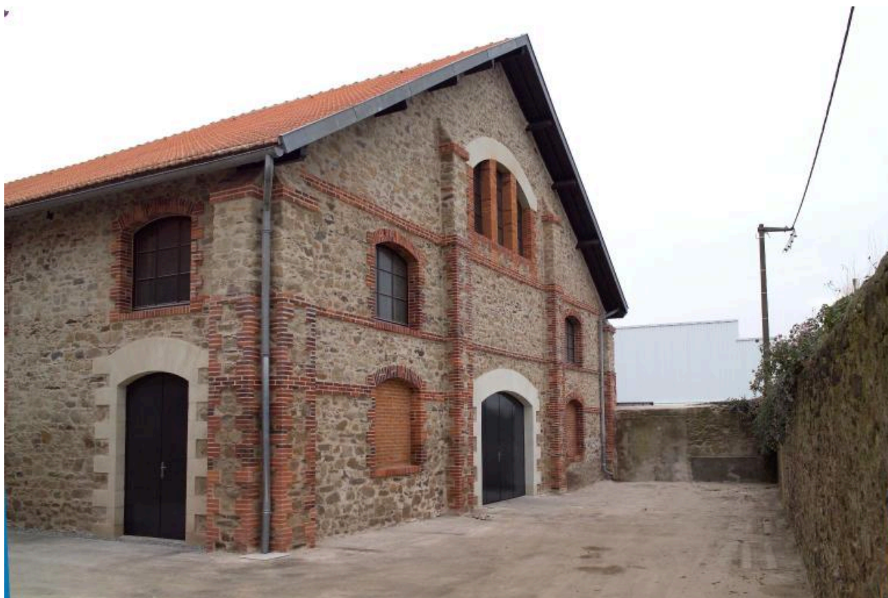
Bâtiment ouest. Mur-pignon nord.
