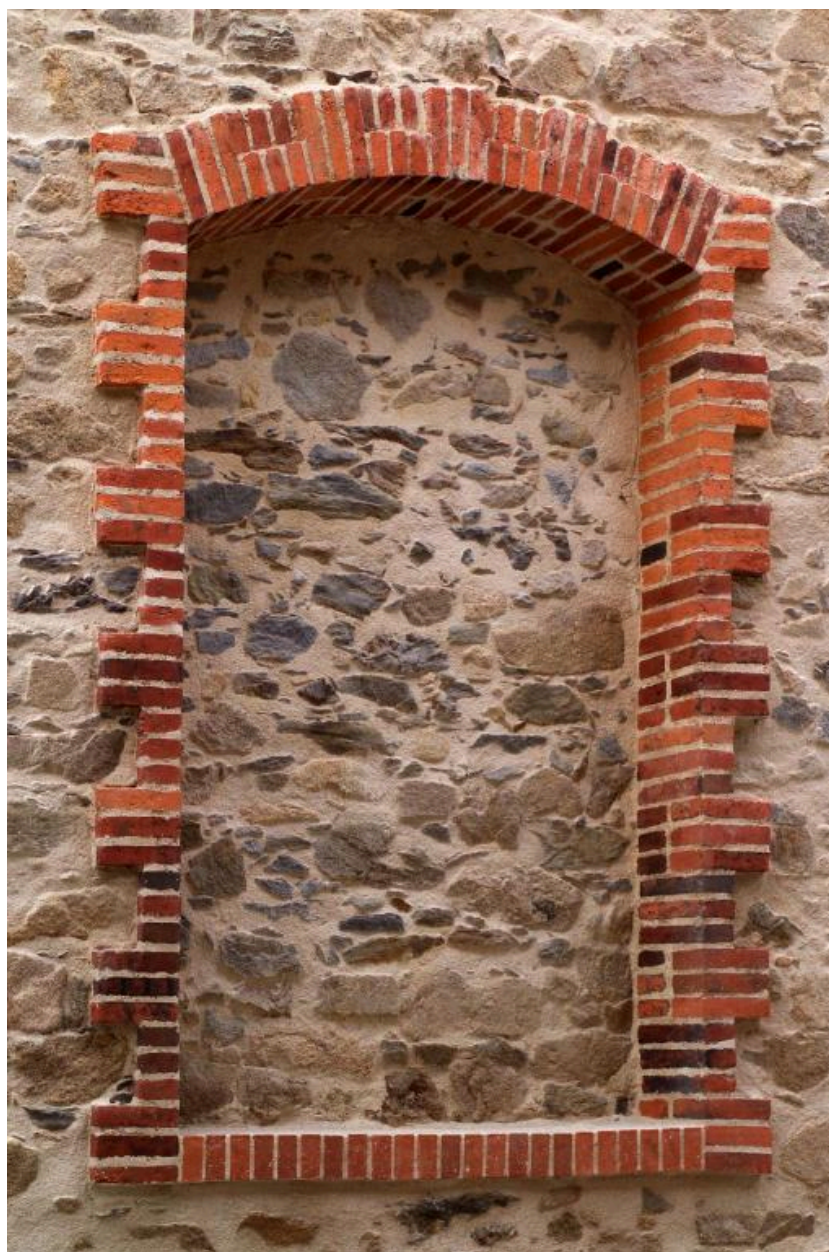
Détail de mise en oeuvre : fausse fenêtre.
