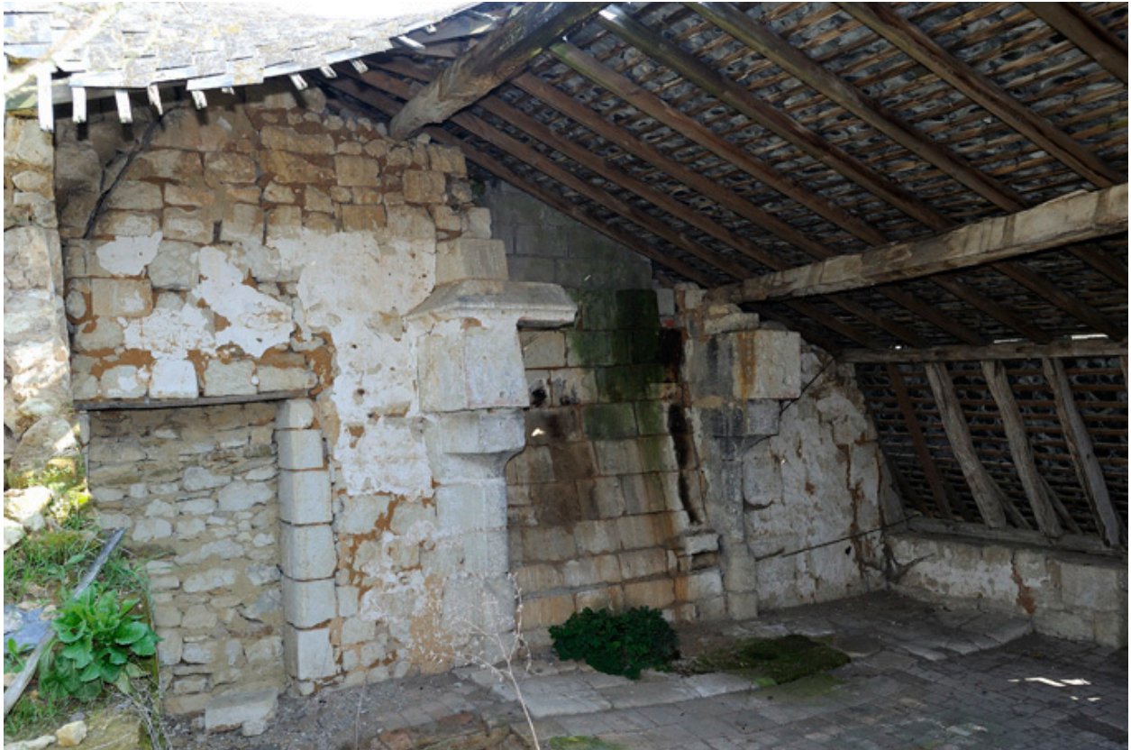
Vue du comble actuel (ancienne salle haute sous charpente, remaniée), avec cheminée du XVe ou du début du XVIe siècle.
