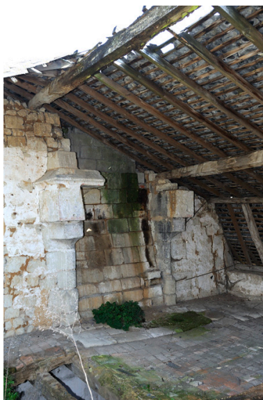
Vue de la cheminée (XVe ou début XVIe siècle) de l'actuel comble. Phot. Bruno Rousseau, Phot. Youenn Communeau IVR52_20114900654NUCA
