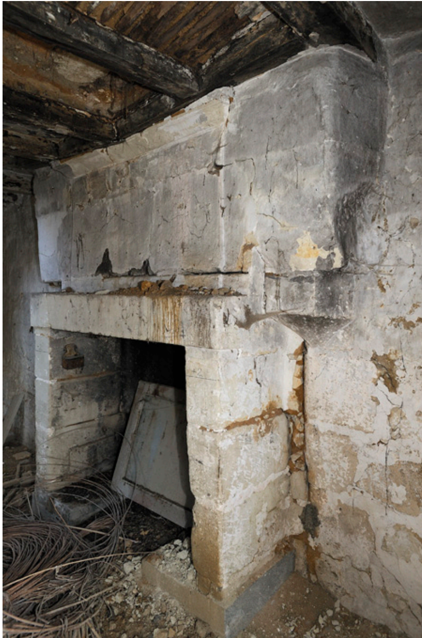
Cheminée du rez-de-chaussée (XVe ou début XVIe, très remaniée).
