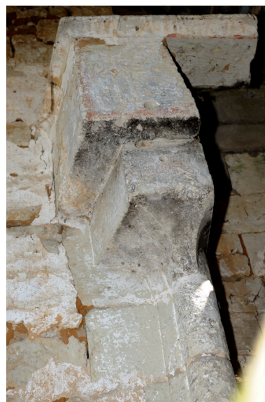
Piédroit et console gauche de la cheminée du comble. Phot. Bruno Rousseau, Phot. Youenn Communeau IVR52_20114900782NUCA
