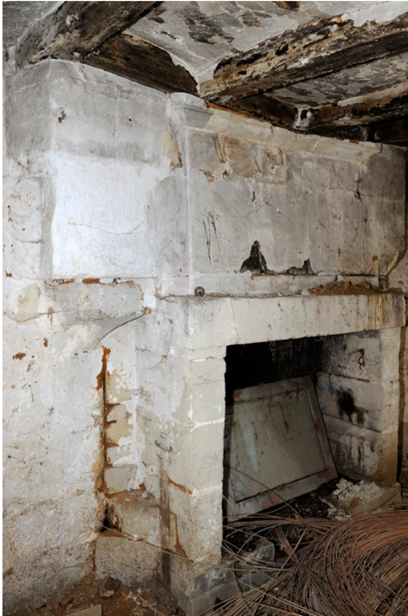
Cheminée du rez-de-chaussée : détail des vestiges de la cheminée médiévale.
