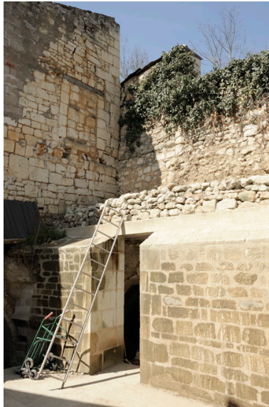
Pignon est du logis. Phot. Bruno Rousseau, Phot. Youenn Communeau IVR52_20114900785NUCA
