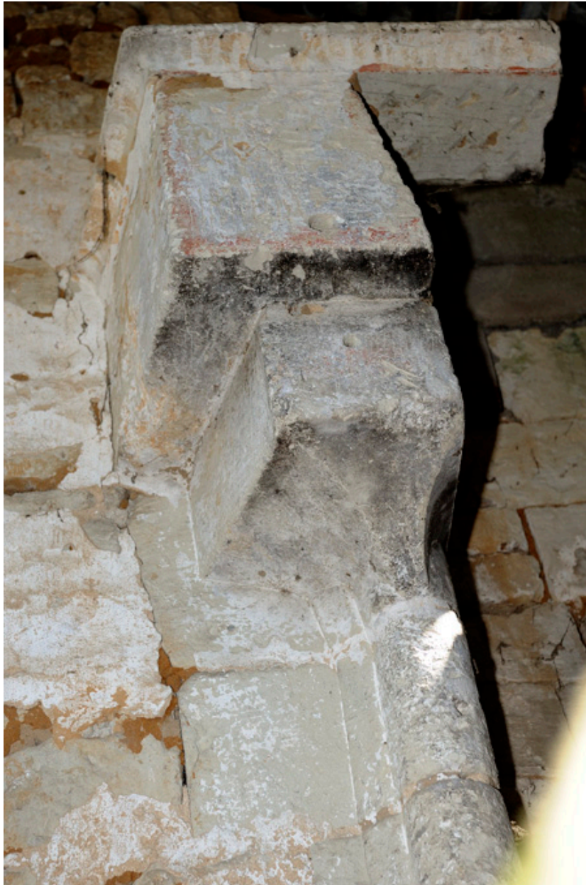
Piédroit et console gauche de la cheminée du comble.
