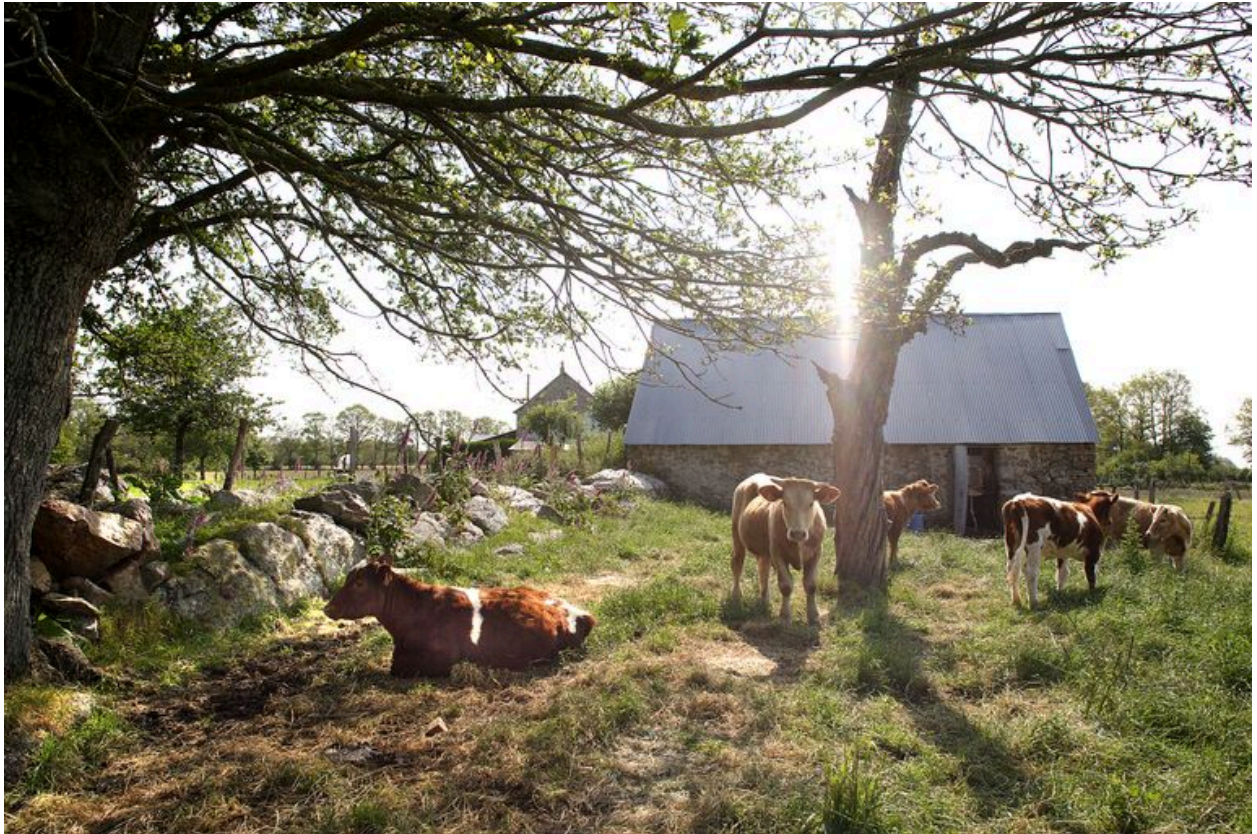
La façade postérieure de l'ancien logis indépendant.
