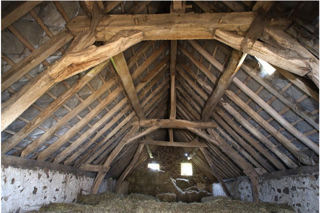
La charpente de l'étable à chevaux vue depuis le nord.
