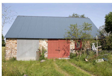
L'ancien logis indépendant. Phot. François Lasa IVR52_20055301695NUCA
