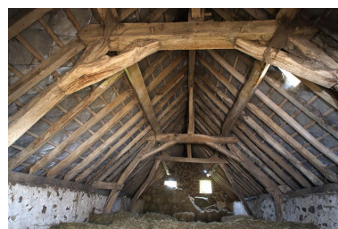
La charpente de l'étable à chevaux vue depuis le nord. Phot. François Lasa IVR52_20055301698NUCA
