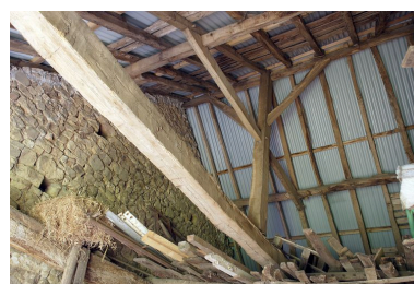
La charpente de l'ancien logis indépendant. Phot. François Lasa IVR52_20055301694NUCA
