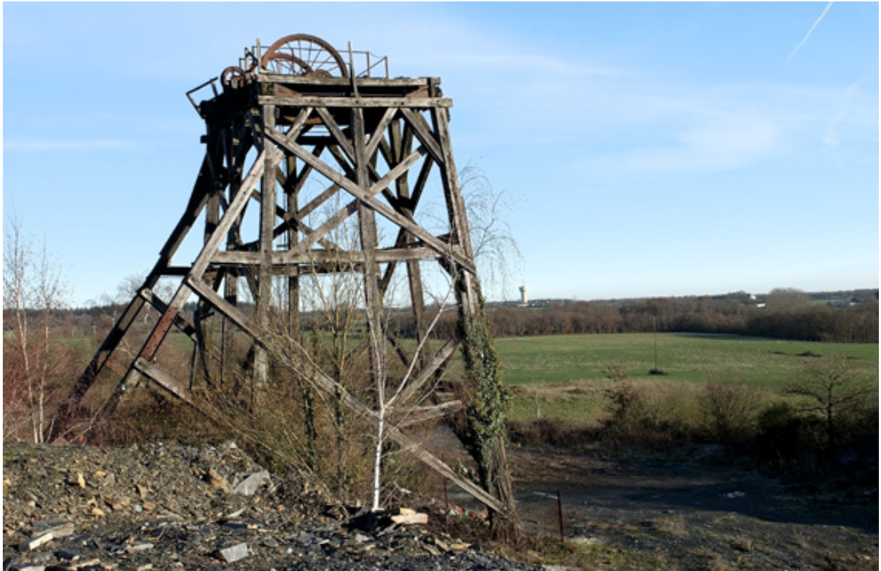
Chevalement en bois, Ardoisière, La Pouëze (Maine-et-Loire).
