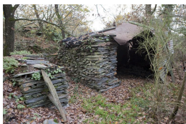
Cabane de fendeur, ardoisière de Nozay (Loire-Atlantique). Phot. Denis Pillet IVR52_20114401215NUCA
