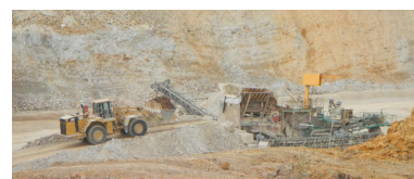
Concasseur, carrière de Chazé-Henry (Maine-et-Loire). Phot. Gaëlle Caudal IVR52_20154900649NUCA
