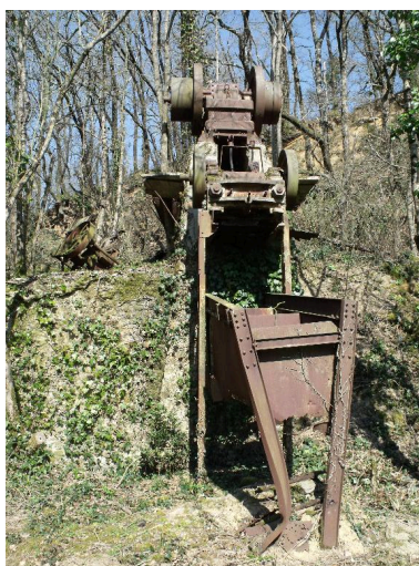
Concasseur mobile, carrière de Fruché-Chauché (Vendée). Phot. Thomas Gonnord IVR52_20158500149NUCA
