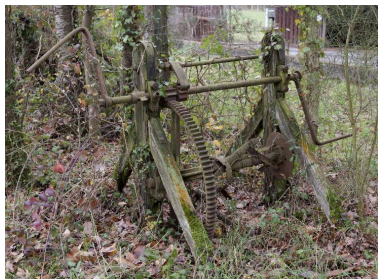
Treuil à structure bois, Ardoisière de Nozay (Loire-Atlantique). Phot. Denis Pillet IVR52_20114401252NUCA
