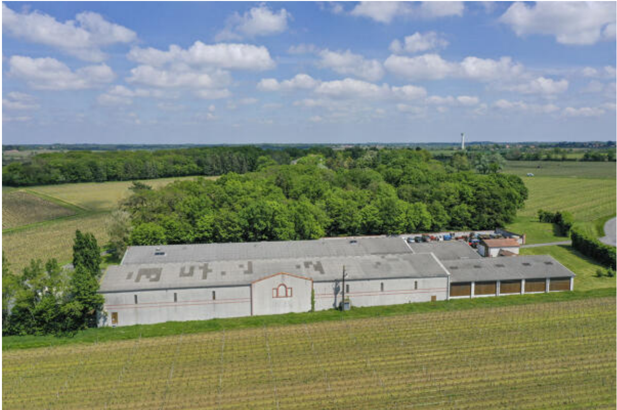
Magasin à vin, vue générale.
