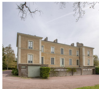
Premiers chais viticoles au revers du château. Phot. Pierre-Bernard Fourny IVR52_20224400144NUCA
