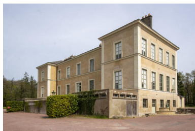
Premiers chais viticoles au revers du château. Phot. Pierre-Bernard Fourny IVR52_20224400143NUCA
