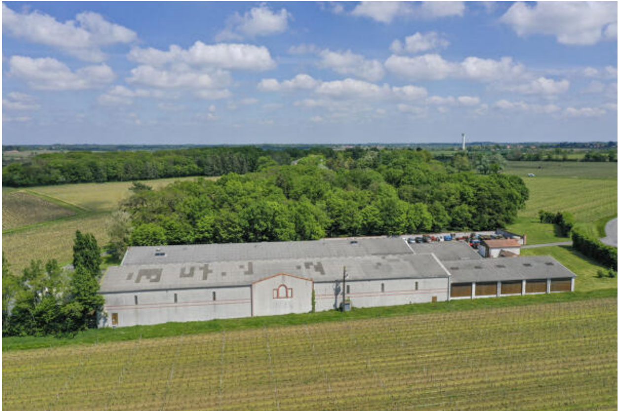
Magasin à vin, vue générale.
