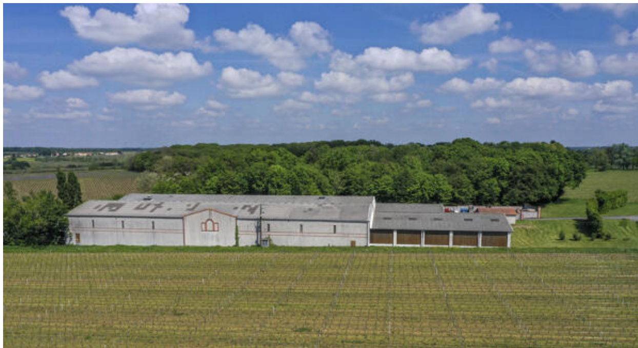
Magasin à vin, vue générale.
