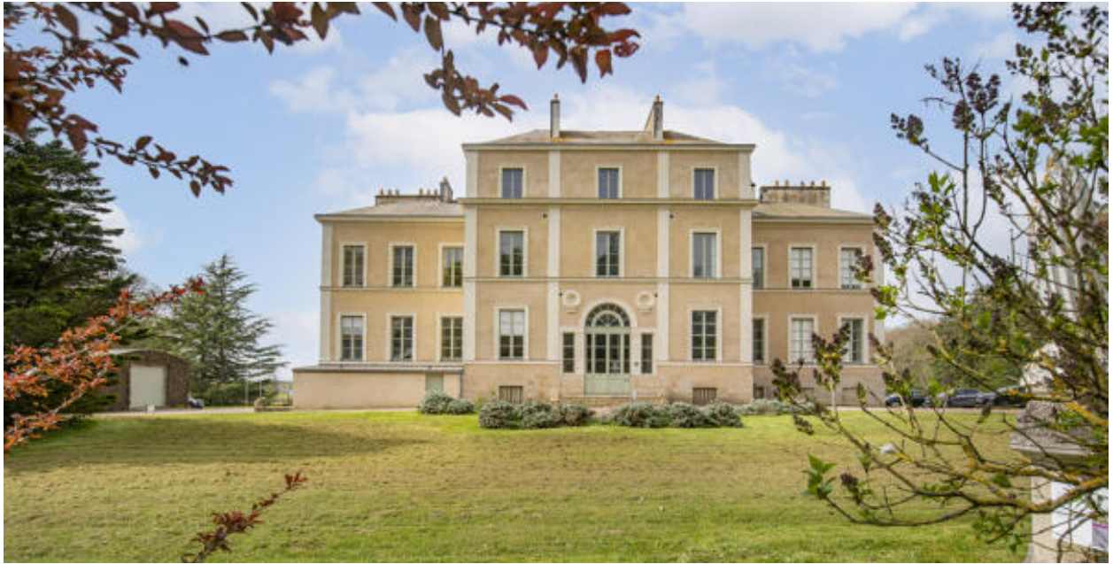
Vue générale du château.
