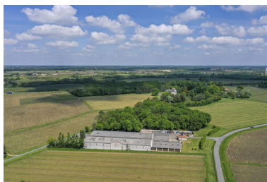
Vue générale du site. Phot. Pierre-Bernard Fourny IVR52_20224400205NUCA
