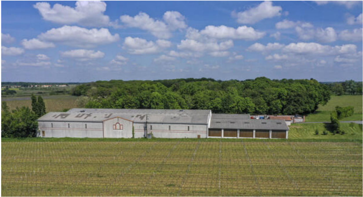
Magasin à vin, vue générale.
