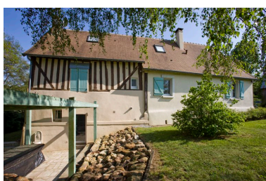
Elévation postérieure du logis. Phot. Yves Guillotin IVR52_20117200504NUCA
