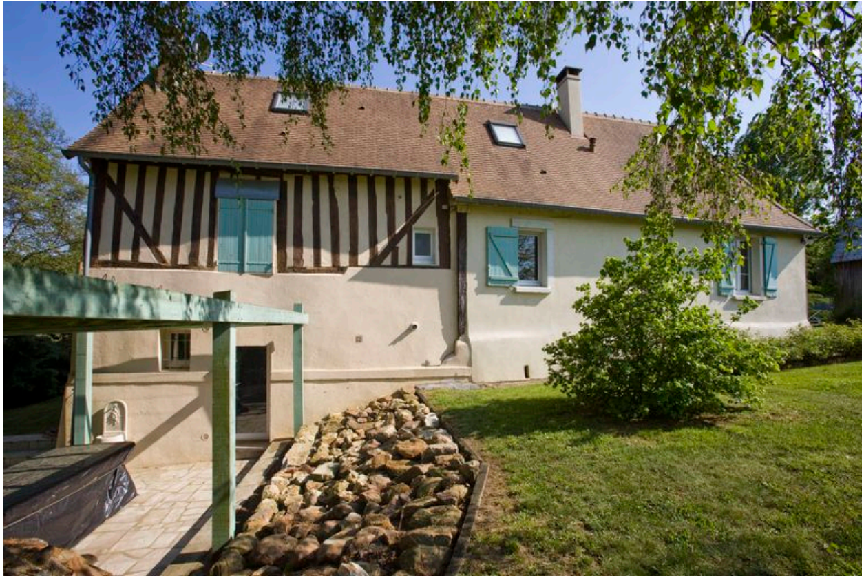
Elévation postérieure du logis.
