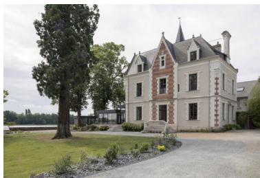
Le Mesnil-Riant à Chantourteau. Phot. Armelle Maugin IVR52_20194900538NUCA
