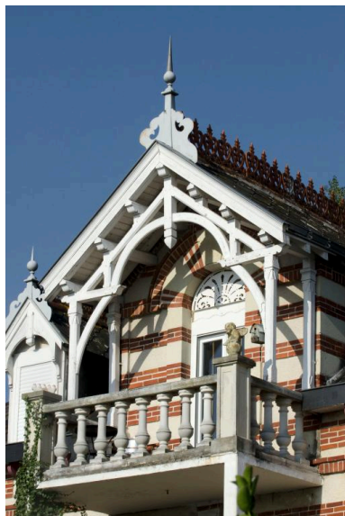
La villa Le Reposoir à Béhuard. Phot. Bruno Rousseau IVR52_20134901610NUCA
