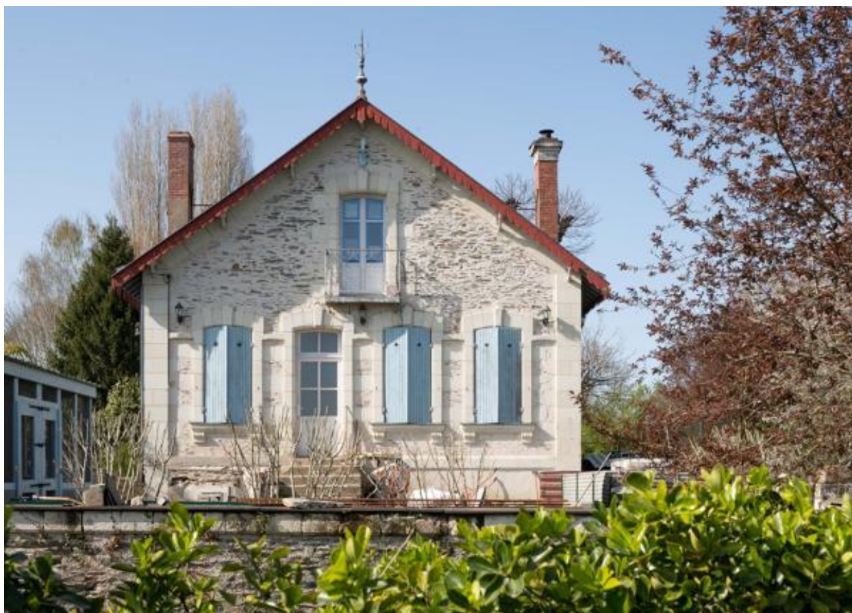
Béhuard. Maison de villégiature construite en 1890 pour Camille Brochet, ferblantier à Angers.
