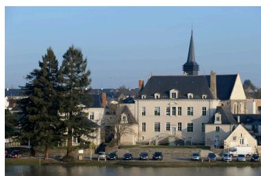
Maison de maître dite l'Abbaye à Bouchemaine. Phot. Bruno Rousseau IVR52_20134901314NUCA
