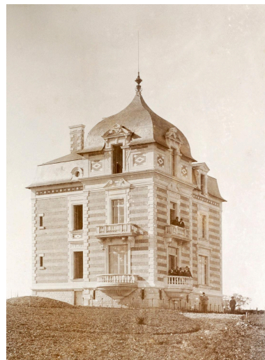
Le castel du Petit-Port à Bouchemaine. Photographie, vers 1900 (Archives municipales d'Angers, 14 Fi 96). Repro. Bruno Rousseau IVR52_20134901565NUCA
