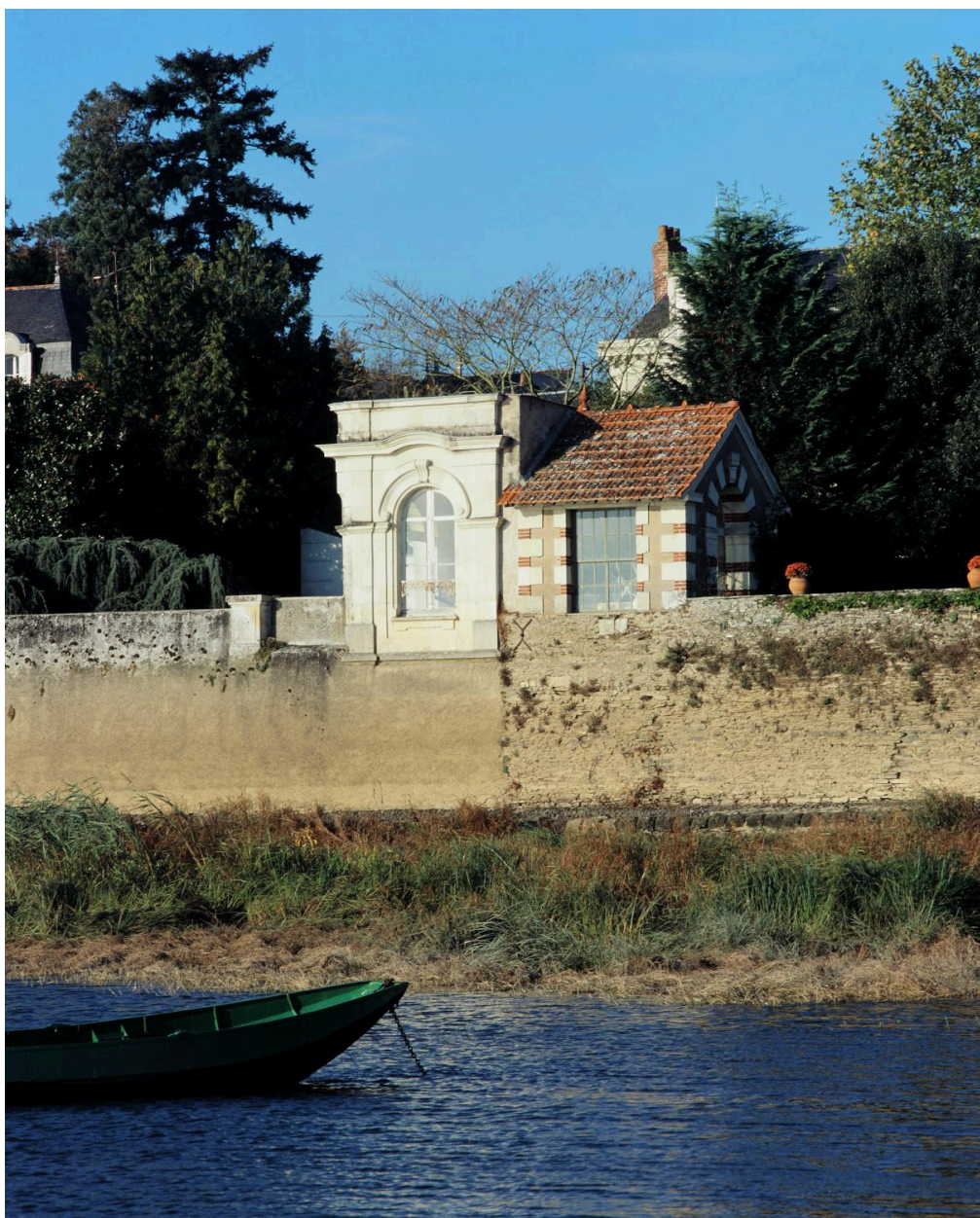
Pavillons de bords de Loire à Chantourteau.
