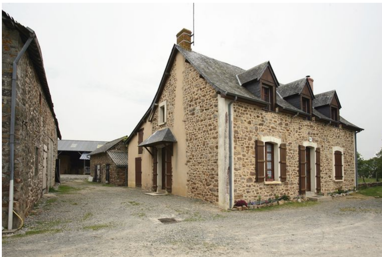
Le logis vu depuis l'ouest. A gauche, le logis-étable, au fond, la porcherie.
