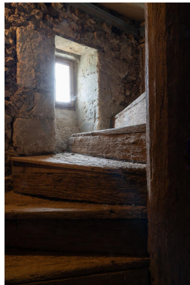
Logis : escalier en vis. Phot. Jeanne Minier IVR52_20257200323NUCA
