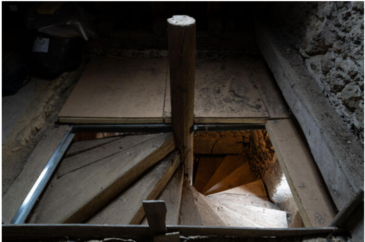
Logis : escalier en vis.
