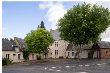
Vue d'ensemble depuis la place de l'Église. Phot. Jeanne Minier IVR52_20257200319NUCA
