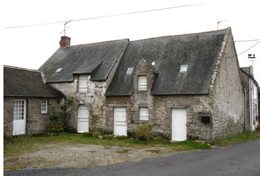
Vue d'ensemble depuis le nord-ouest. Phot. Denis Pillet IVR52_20074401621NUCA
