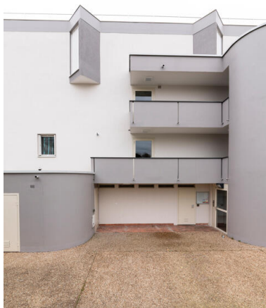
Vue des cursive et escalier sur la façade latérale d'un immeuble. Phot. Thierry Seldubuisson IVR52_20227201785NUCA
