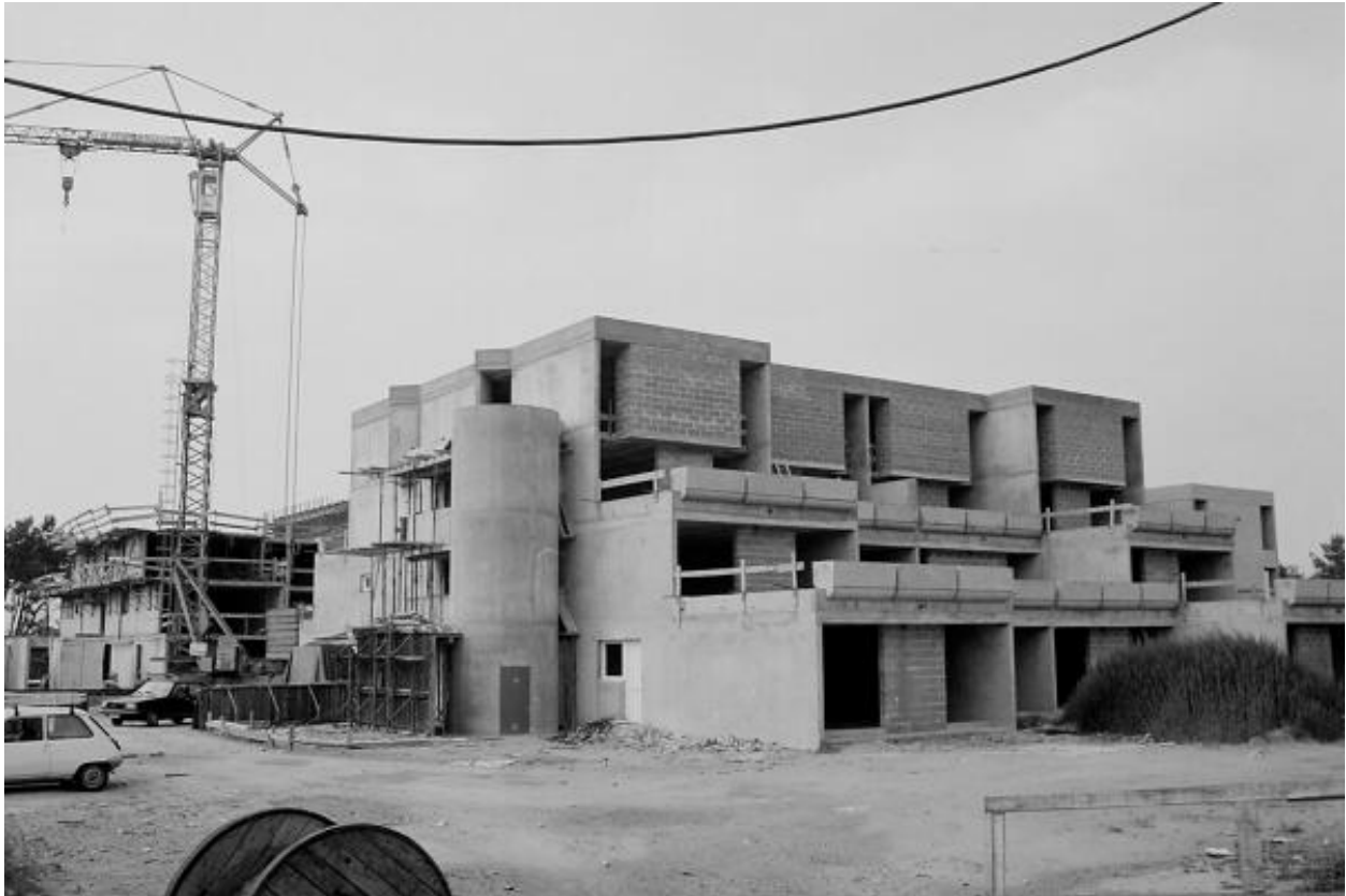
Vue du chantier de construction des immeubles à gradins aux Bruyères.
