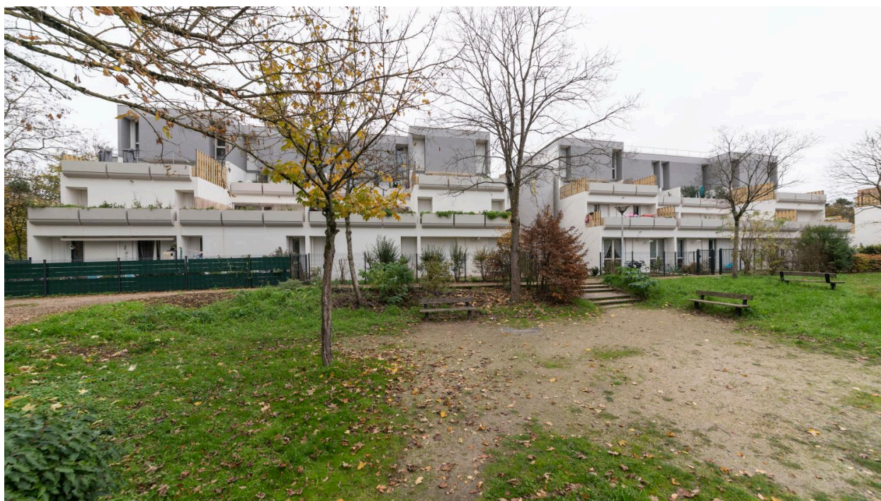
Vue des façades principales d'immeubles depuis le sud.
