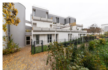
Vue de deux immeubles liés par des coursives joignant la cage d'escalier. Phot. Thierry Seldubuisson IVR52_20227201787NUCA
