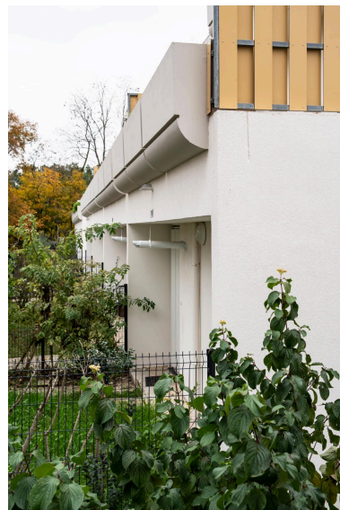
Détail d'un rez-de-chaussée surmonté d'une terrasse. Phot. Thierry Seldubuisson IVR52_20227201789NUCA
