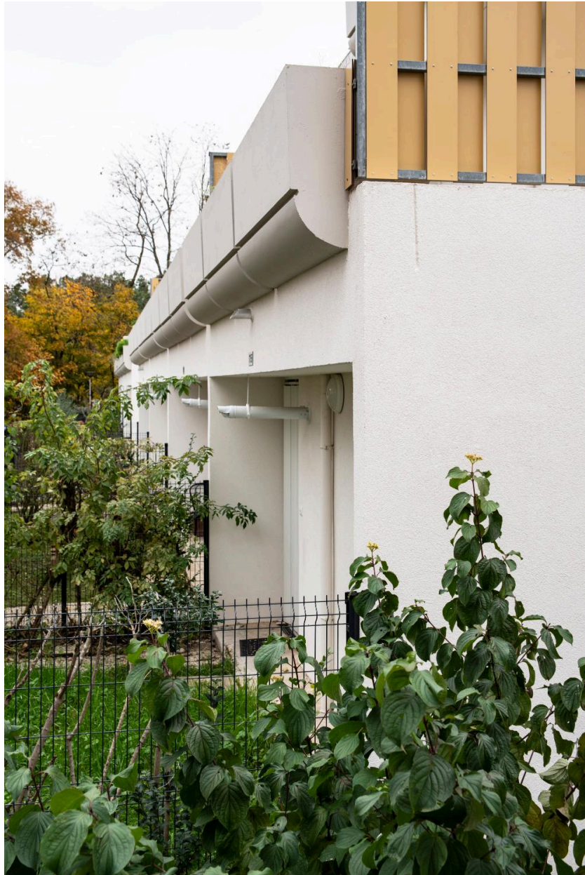
Détail d'un rez-de-chaussée surmonté d'une terrasse.
