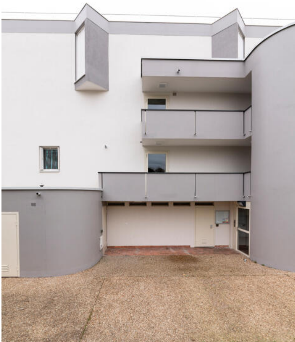
Vue des cursive et escalier sur la façade latérale d'un immeuble.
