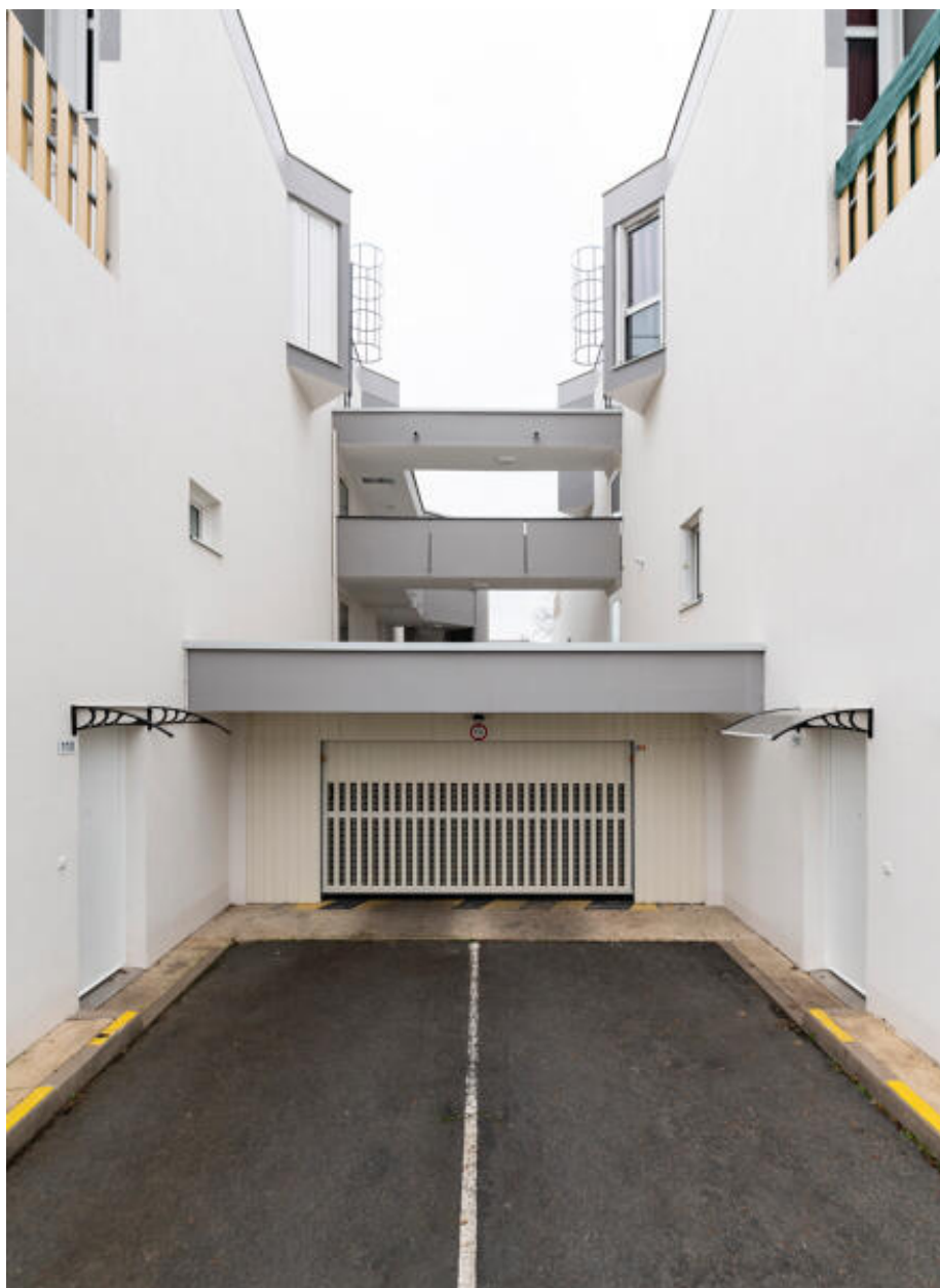
Vue des cursives faisant communiquer deux immeubles.
