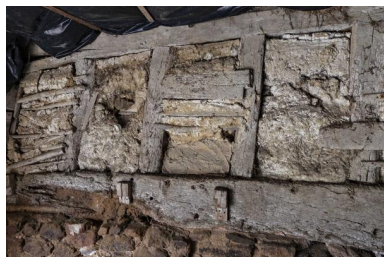
Cloison de refend de la grange. Phot. Yves Guillotin IVR52_20205300410NUCA
