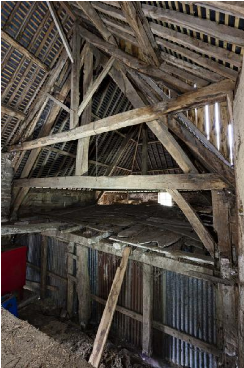
Ferme nord de la charpente de la grange.
