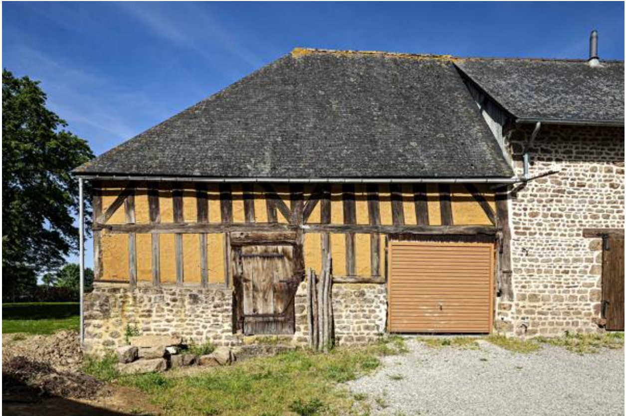
Façade orientale de la grange.
