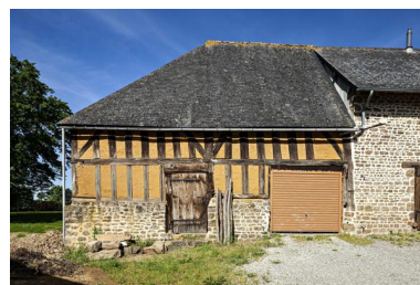
Façade orientale de la grange. Phot. Yves Guillotin IVR52_20215300655NUCA
