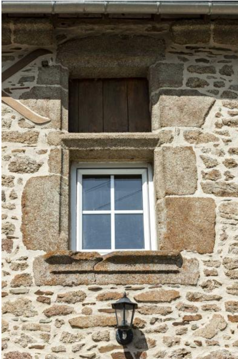
Demi-croisée du manoir, façade orientale.
