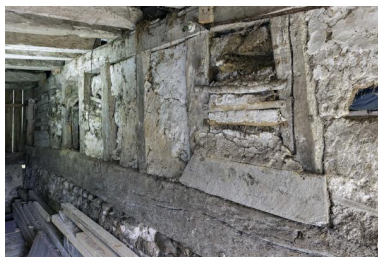
Cloison de refend de la grange. Phot. Yves Guillotin IVR52_20205300409NUCA
