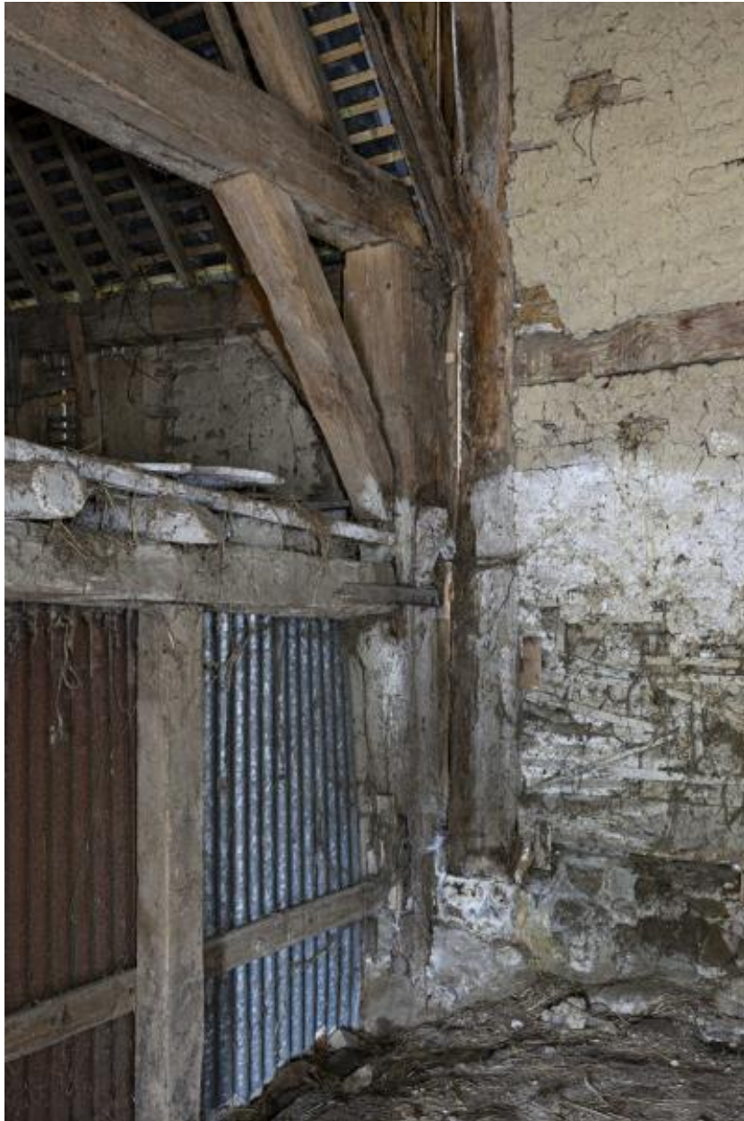
Poteau et lien nord-ouest de la grange.
