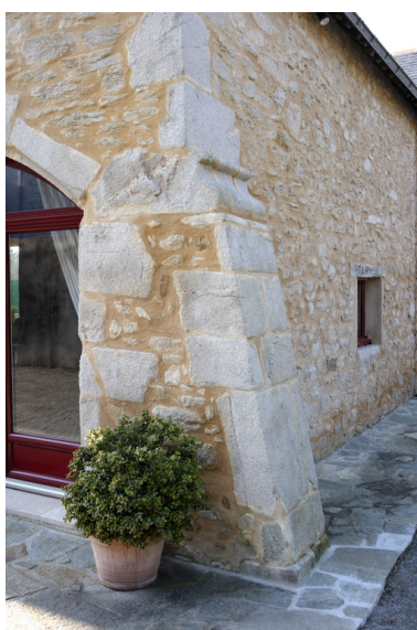
Détail de l'un des contreforts de l'écurie. Phot. Denis Pillet IVR52_20084400356NUCA
