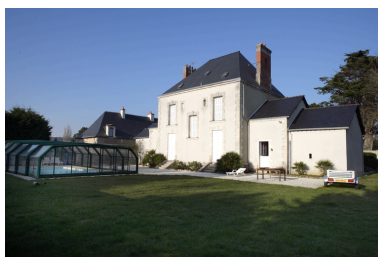
Vue de la façade sud. Phot. Denis Pillet IVR52_20084400354NUCA
