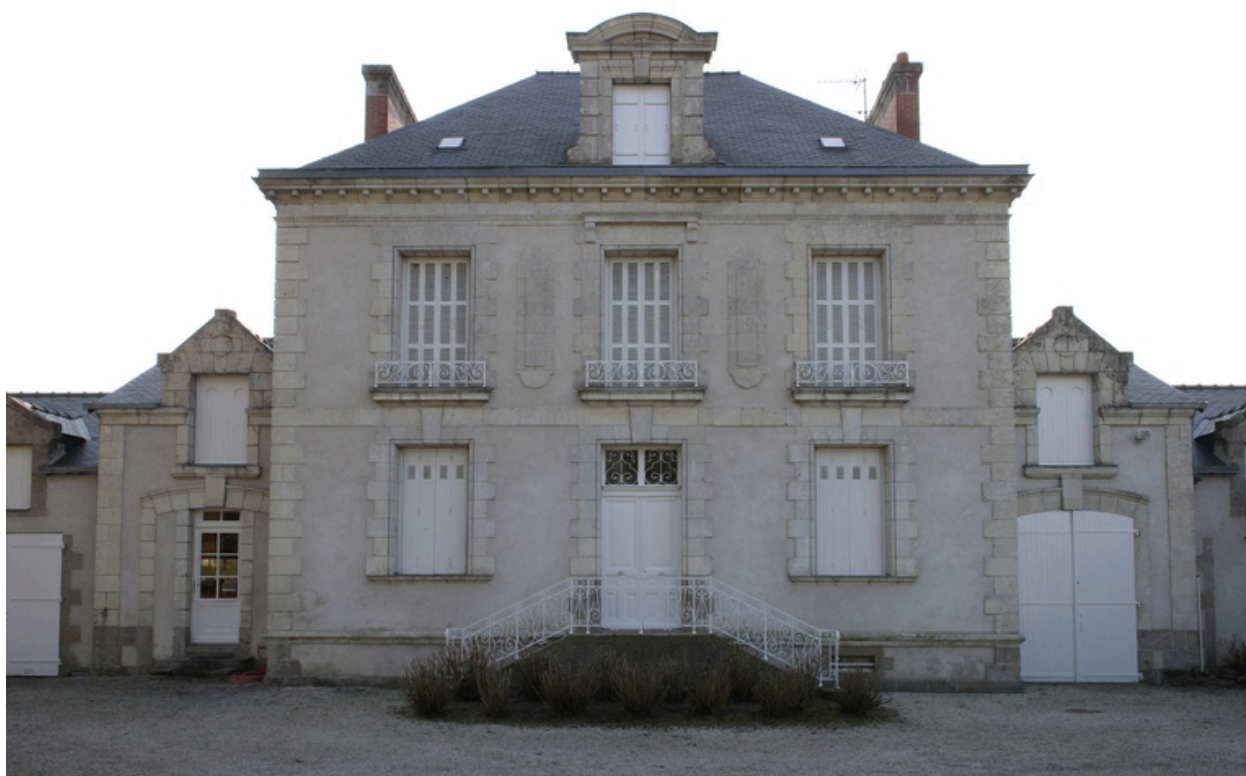
Vue de la façade nord.
