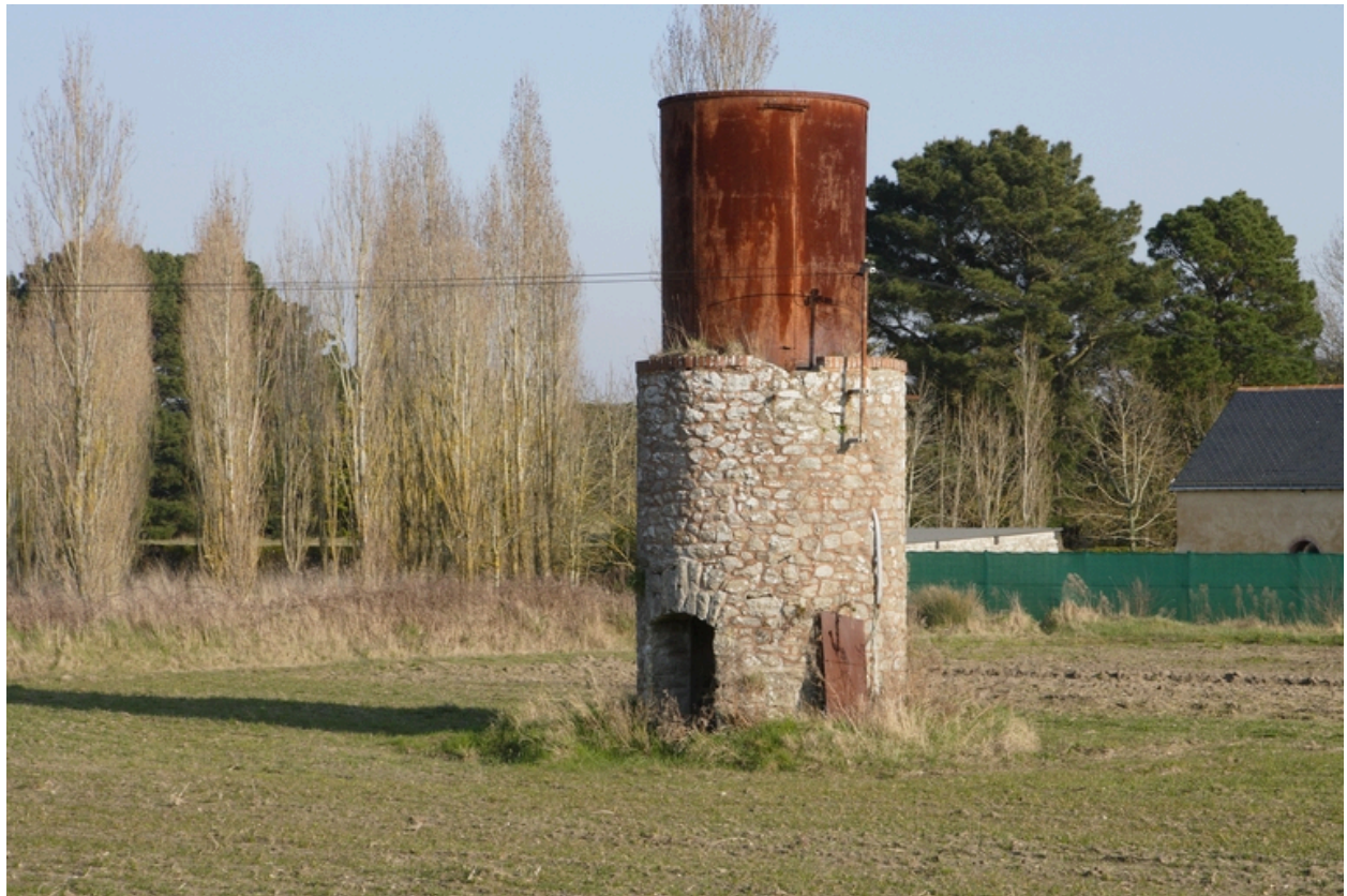
Citerne (?), vue depuis le sud-ouest.
