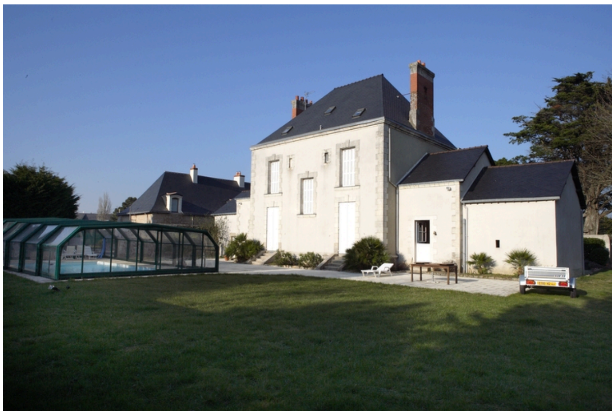
Vue de la façade sud.
