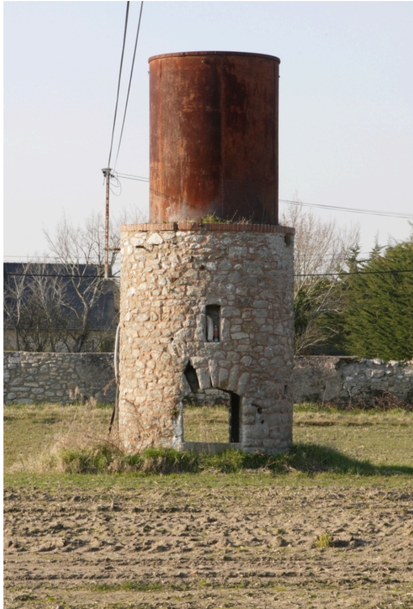
Citerne (?), vue depuis l'ouest.
