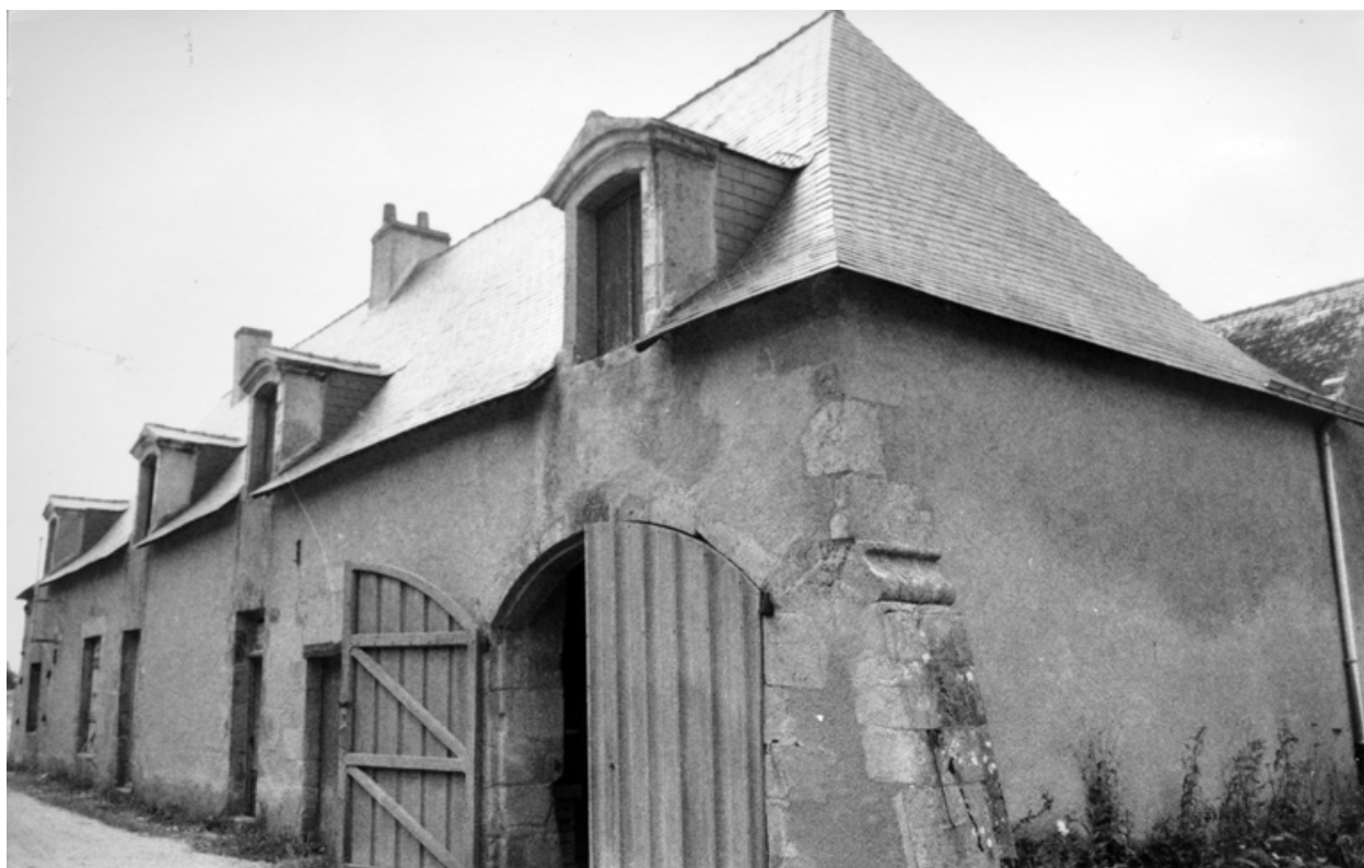
Vue des commons avant restauration, 1990.
