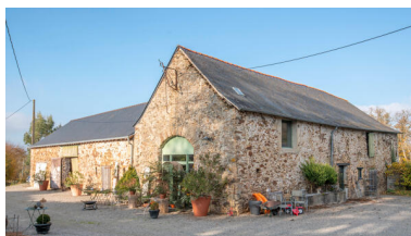
Les anciennes dépendances agricoles. Phot. Pierre-Bernard Fourny IVR52_20225301179NUCA
