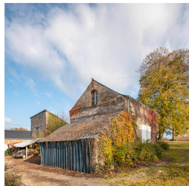
Un pavillon à l'entrée de la cour. Phot. Pierre-Bernard Fourny IVR52_20225301185NUCA
