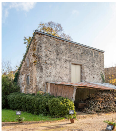
Un vestige de l'ancien manoir. Phot. Pierre-Bernard Fourny IVR52_20225301181NUCA
