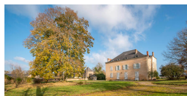
La demeure côté cour. Phot. Pierre-Bernard Fourny IVR52_20225301187NUCA
