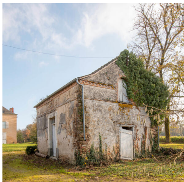
Un pavillon à l'entrée de la cour. Phot. Pierre-Bernard Fourny IVR52_20225301186NUCA
