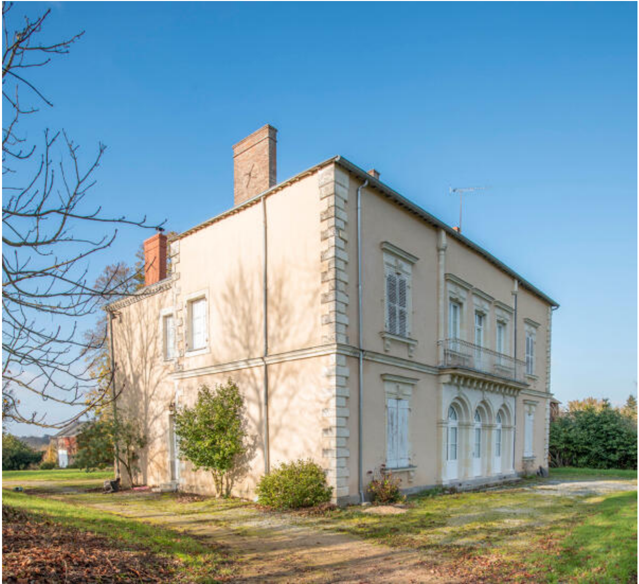
L'élévation latérale sud de la demeure.
