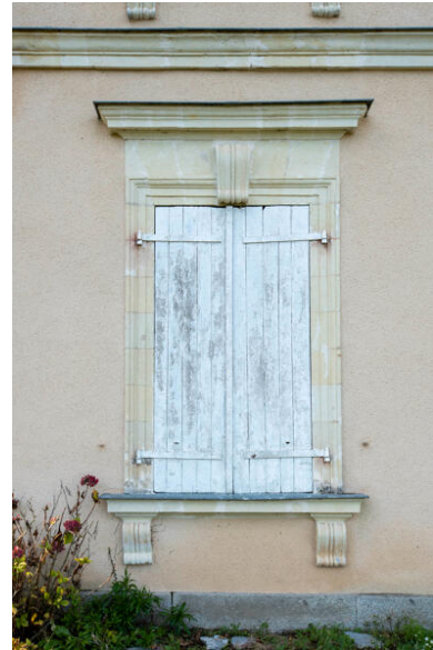
La façade sur le parc, détail d'une fenêtre. Phot. Pierre-Bernard Fourny IVR52_20225301195NUCA
