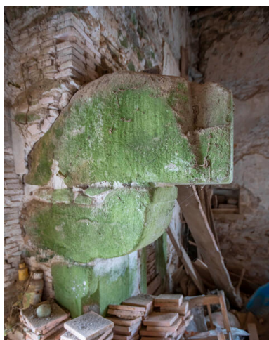
Un corbeau vestige d'une cheminée de l'ancien manoir. Phot. Pierre-Bernard Fourny IVR52_20225301206NUCA
