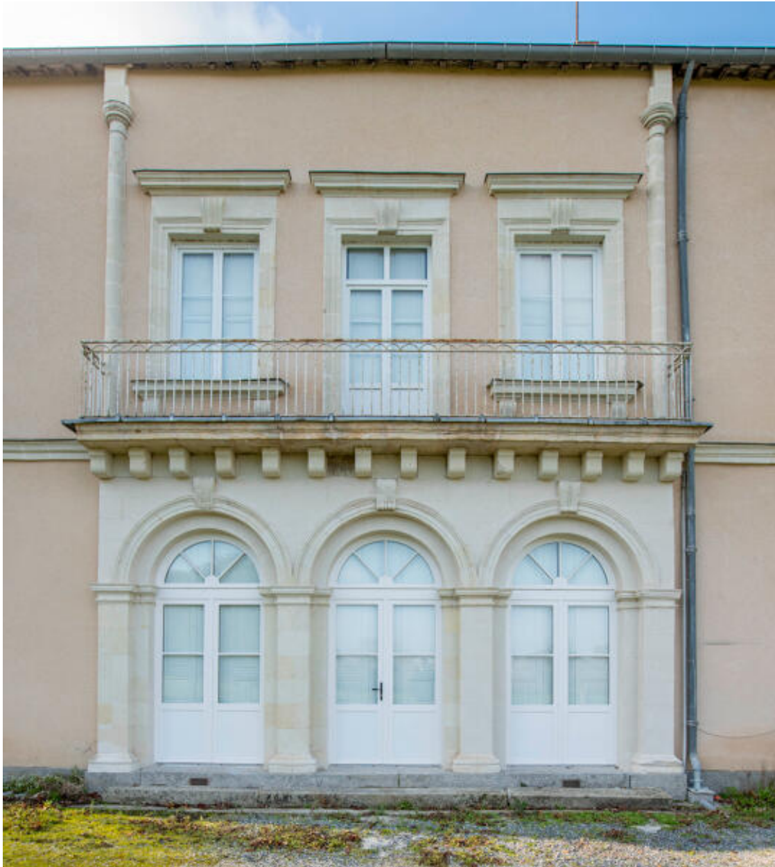
La façade sur le parc, détail des travées centrales.
