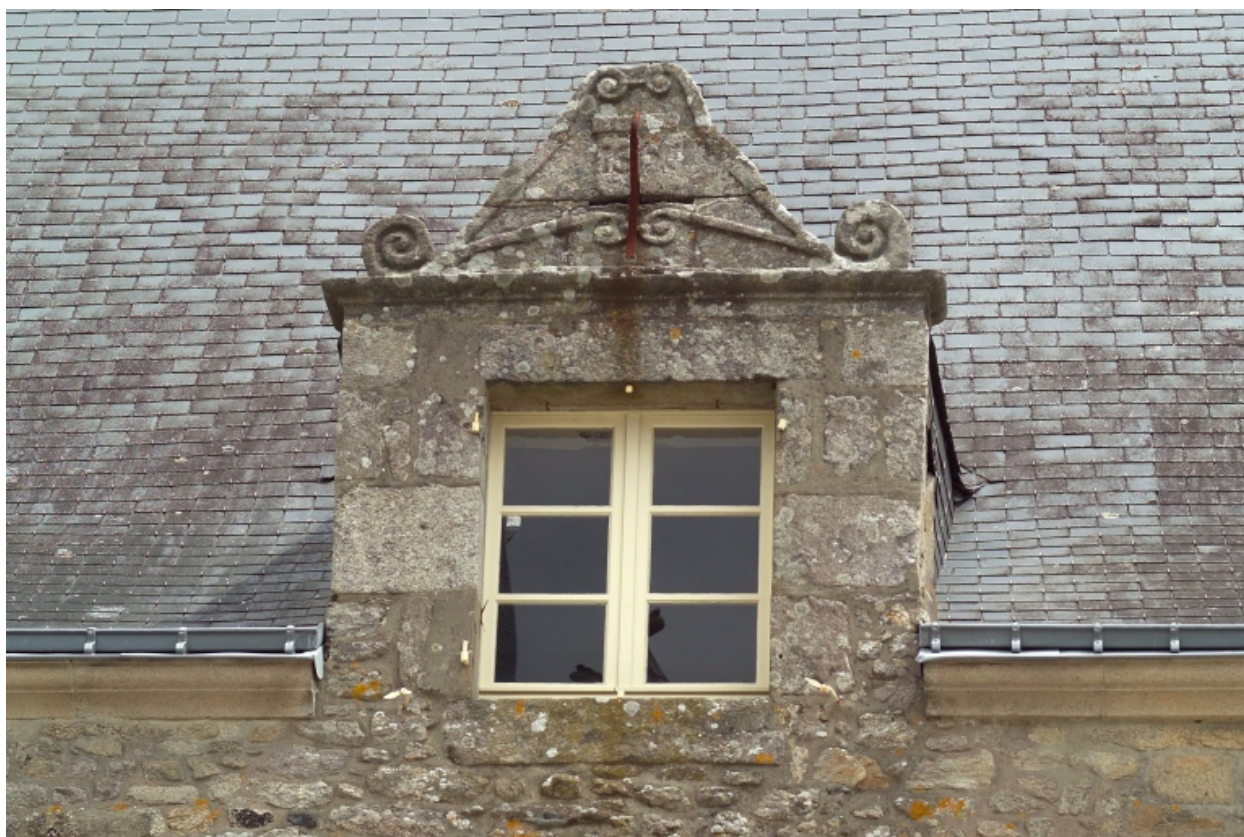
Détail de la lucarne daté sur la façade au Nord.
