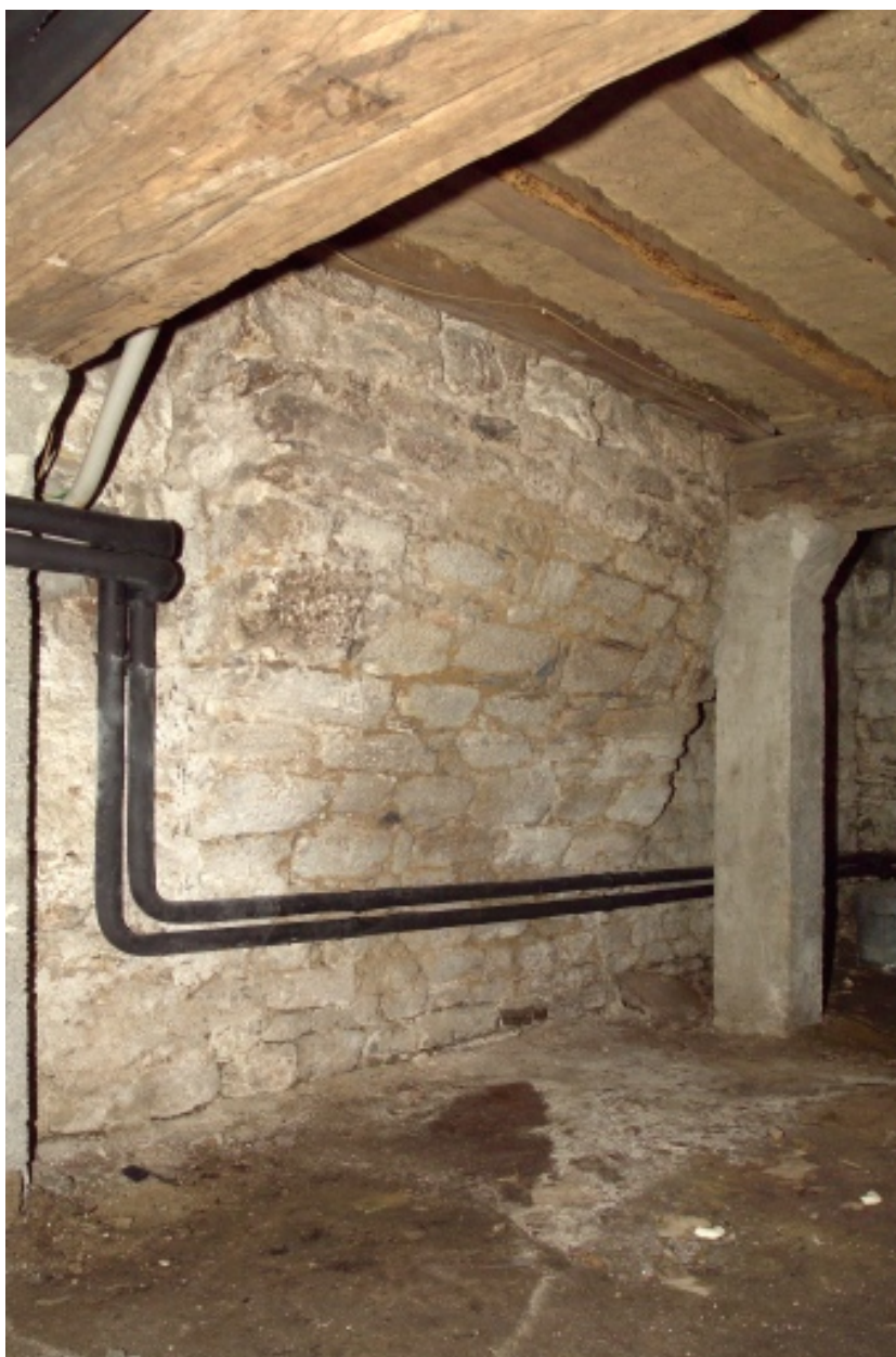
Soubassement de cheminée en encorbellement dans la cave.
