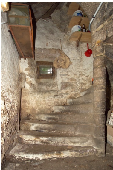
Escalier en vis vu depuis la cave. Phot. Denis Pillet IVR52_20074400818NUCA
