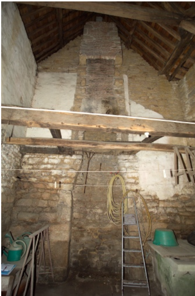
Vue de l'intérieur de la dépendance est, mur pignon.
