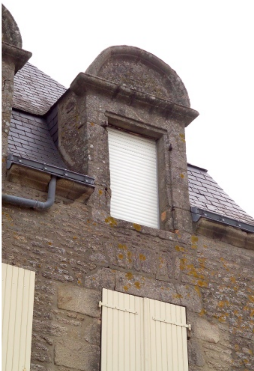
Détail d'une lucarne sur la façade au Sud.
