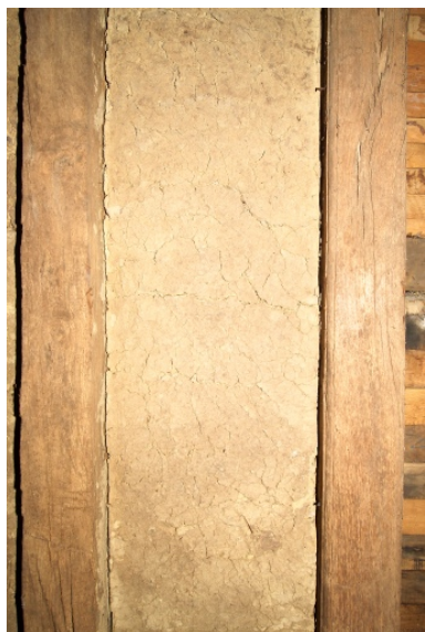
Détail de bousillis entre les solives du plancher du rez- de-chaussée vu depuis la cave. Phot. Denis Pillet IVR52_20074400820NUCA
