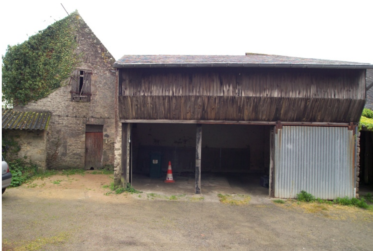
Vue générale du séchoir et de la dépendance à l'Est.
