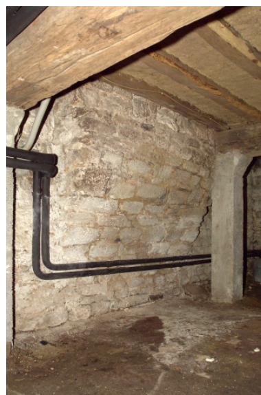
Soubassement de cheminée en encorbellement dans la cave. Phot. Denis Pillet IVR52_20074400817NUCA
