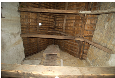
Charpente de la dépendance est. Phot. Denis Pillet IVR52_20074400827NUCA
