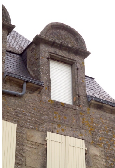
Détail d'une lucarne sur la façade au Sud. Phot. Denis Pillet IVR52_20074400423NUCA
