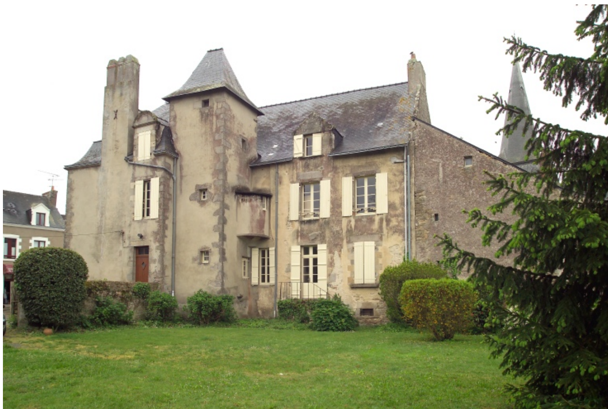
Vue de la façade postérieure.
