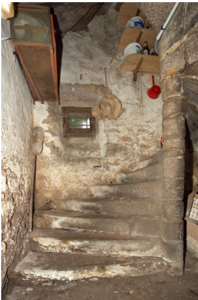
Escalier en vis vu depuis la cave.
