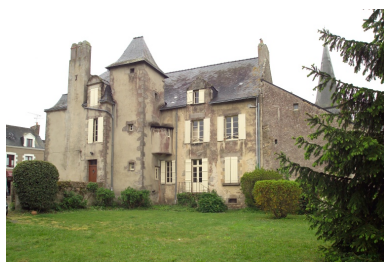
Vue de la façade postérieure. Phot. Denis Pillet IVR52_20074400821NUCA
