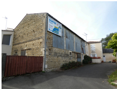
Les dépendances, étable et fenil, perpendiculaires à l'arrière du logis, vues depuis l'est. Phot. Yannis Suire IVR52_20228500554NUCA
