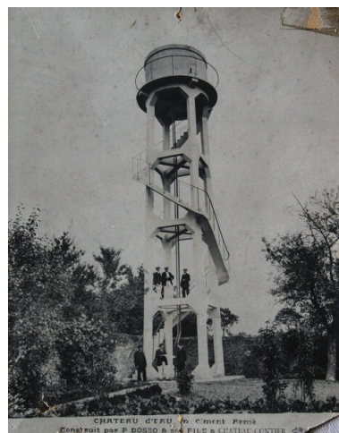
L'inauguration du château d'eau, 1912 ou 1913. Repro. Pierrick Barreau IVR52_20245300011NUCA
