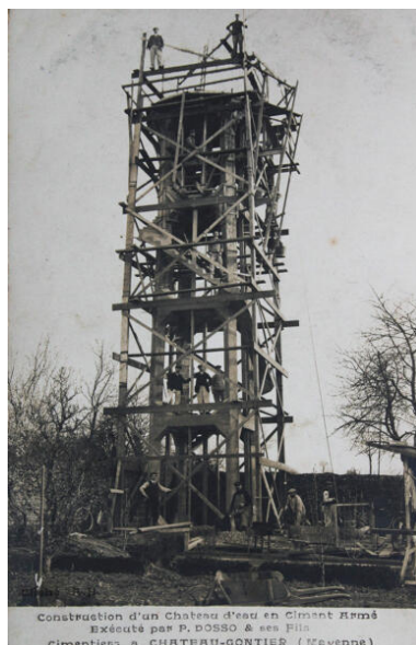
Construction d'un Château d'eau en Ciment Armé Exécuté par P. DOSSO & ses FILS Cimentiers à CHÂTEAU-GONTIER (Mayenne) Le château d'eau en construction, 1912 ou 1913. Repro. Pierrick Barreau IVR52_20245300010NUCA
