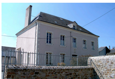
Vue d'ensemble de l'école. Phot. Ronan Durandière IVR52_20064903531NUCA
