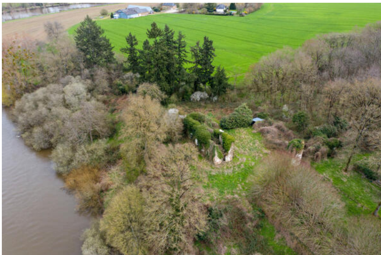
Une vue aérienne du site de Fuseaux.
