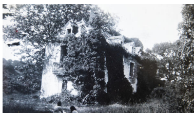
La maison de maître en 1942. Repro. Pierre-Bernard Fourny IVR52_20235301370NUCA
