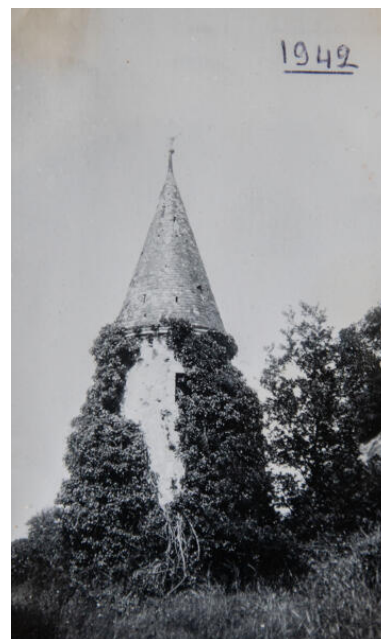
La tour circulaire en 1942. Repro. Pierre-Bernard Fourny IVR52_20235301369NUCA
