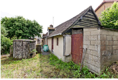
Vue des maisons 4 et 5 depuis le nord Phot. Yves Guillotin IVR52_20137200440NUCA
