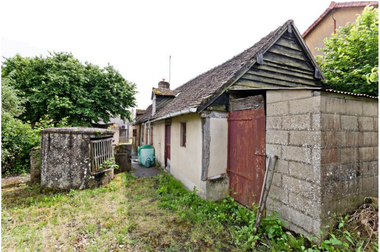
Vue des maisons 4 et 5 depuis le nord
