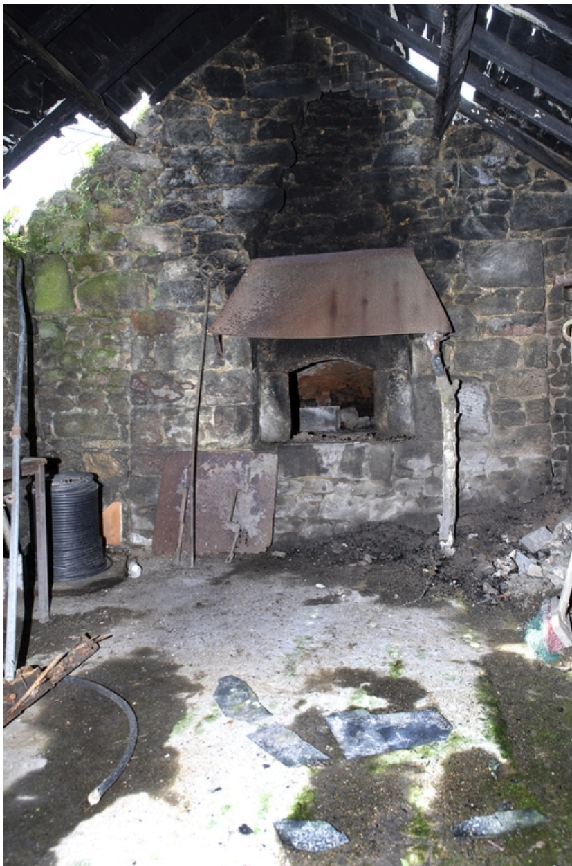
Cannevé. Détail de la gueule du fournil couverte d'un linteau délardé en arc segmentaire.
