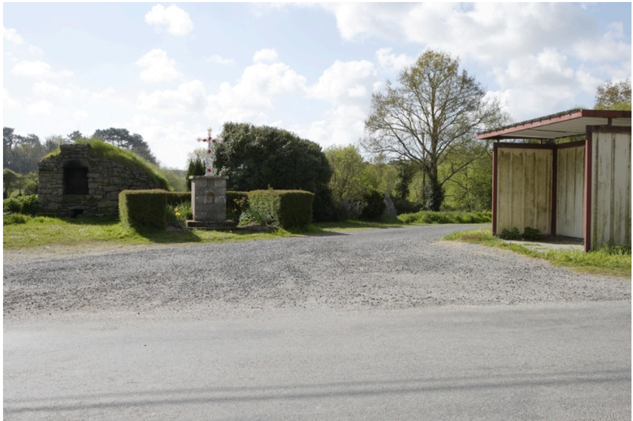
Kergourdin. Four à pain au centre d'un placître associé à une croix de chemin et un puits.
