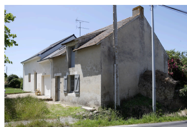
Brézéan. Four à pain sur le pignon du logis. Phot. Denis Pillet IVR52_20084402130NUCA
