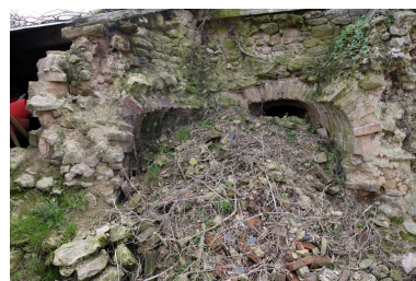
Le Blanc. Coupe de la voûte en brique du fournil. Phot. Denis Pillet IVR52_20084400559NUCA
