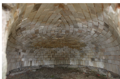
Léveno. Détail de la voûte du four. Phot. Denis Pillet IVR52_20084401649NUCA
