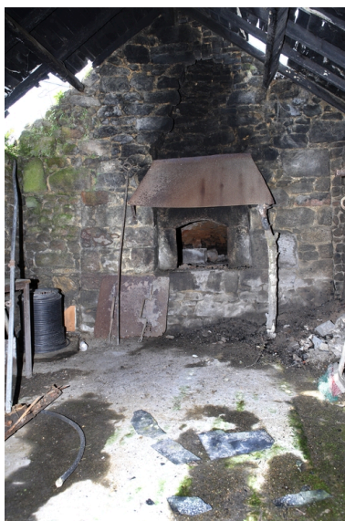
Cannevé. Détail de la gueule du fournil couverte d'un linteau déclardé en arc segmentaire. Phot. Denis Pillet IVR52_20084400528NUCA
