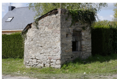
Rosconan. Toiture en appentis massé. Phot. Denis Pillet IVR52_20084401423NUCA
