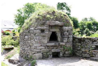
Kergaigne. Four à pain avec niche au sol pour recueillir les braises. Phot. Denis Pillet IVR52_20084401732NUCA
