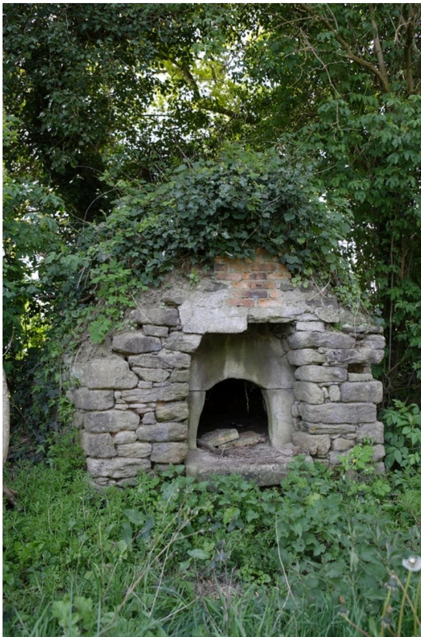
Métairie de Lévera. Four à pain construit après 1819.
