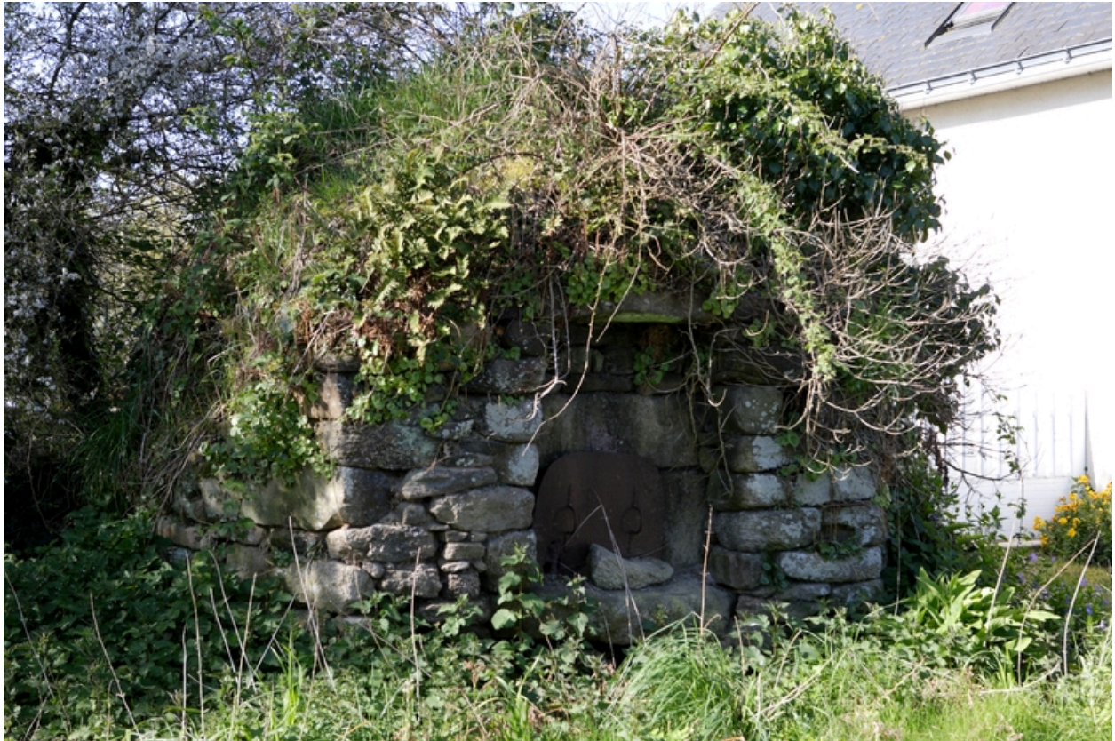
Le Mené. Four à pain avec sa couverture d'origine en mottes.
