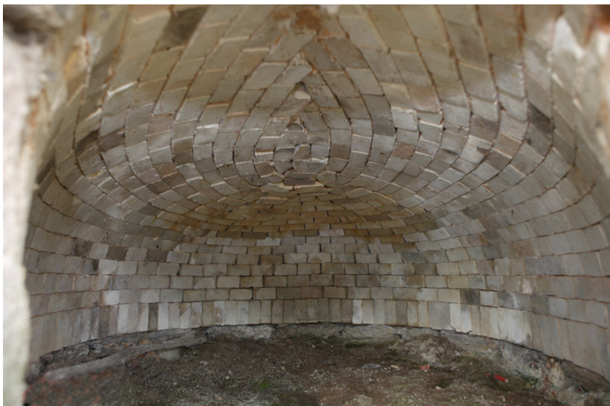
Léveno. Détail de la voûte du four.
