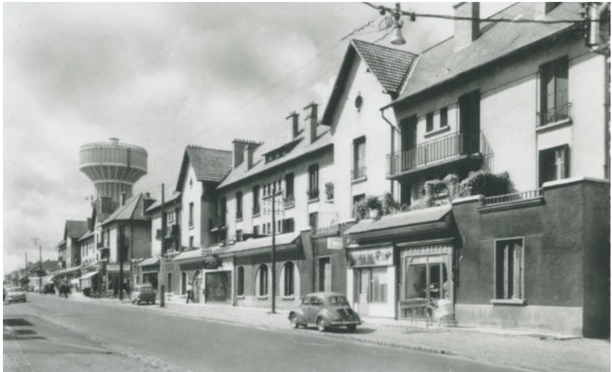
Vue des immeubles avenue Felix Geneslay avec le chateau d'eau en fond.
