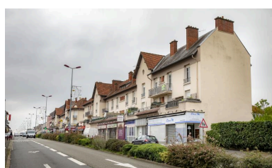
Vue des immeubles côté rue de l'avenue Felix Geneslay. Phot. Pierre-Bernard Fourny IVR52_20197202602NUCA
