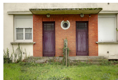
Détail de l'entrée du pavillon de type 2. Phot. Pierre-Bernard Fourny IVR52_20197202575NUCA
