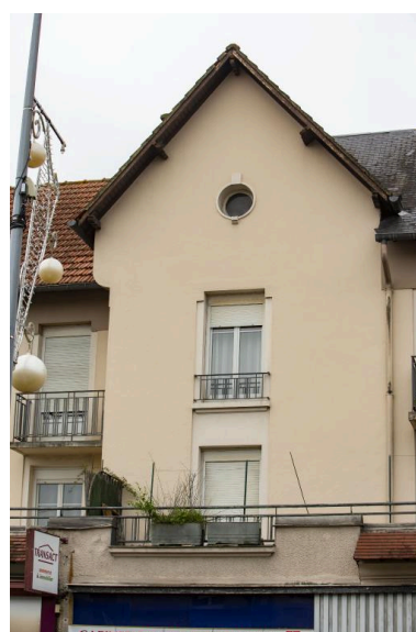
Vue d'une travée pignon sur la façade côté de l'immeuble avenue Felix Geneslay. Phot. Pierre-Bernard Fourny IVR52_20197202603NUCA
