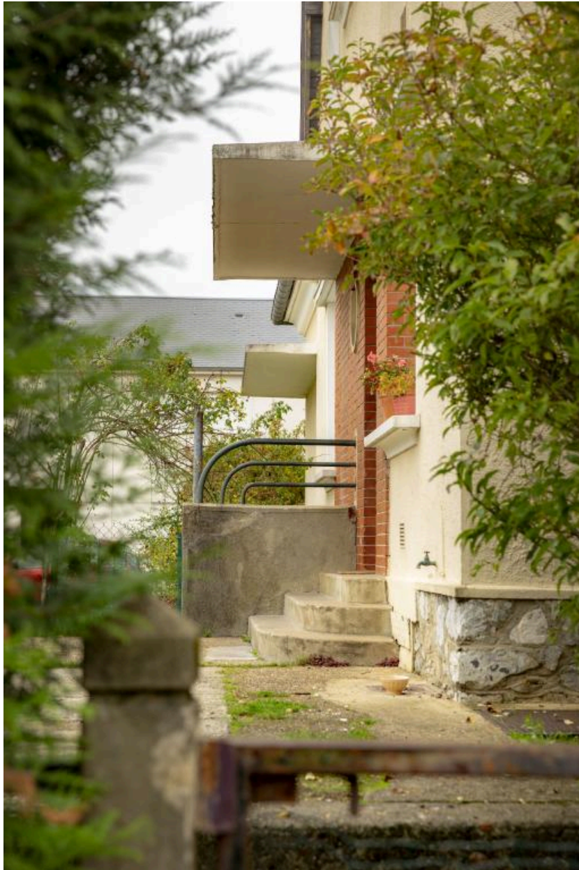
Vue de l'entrée de pavillon de type 1.
