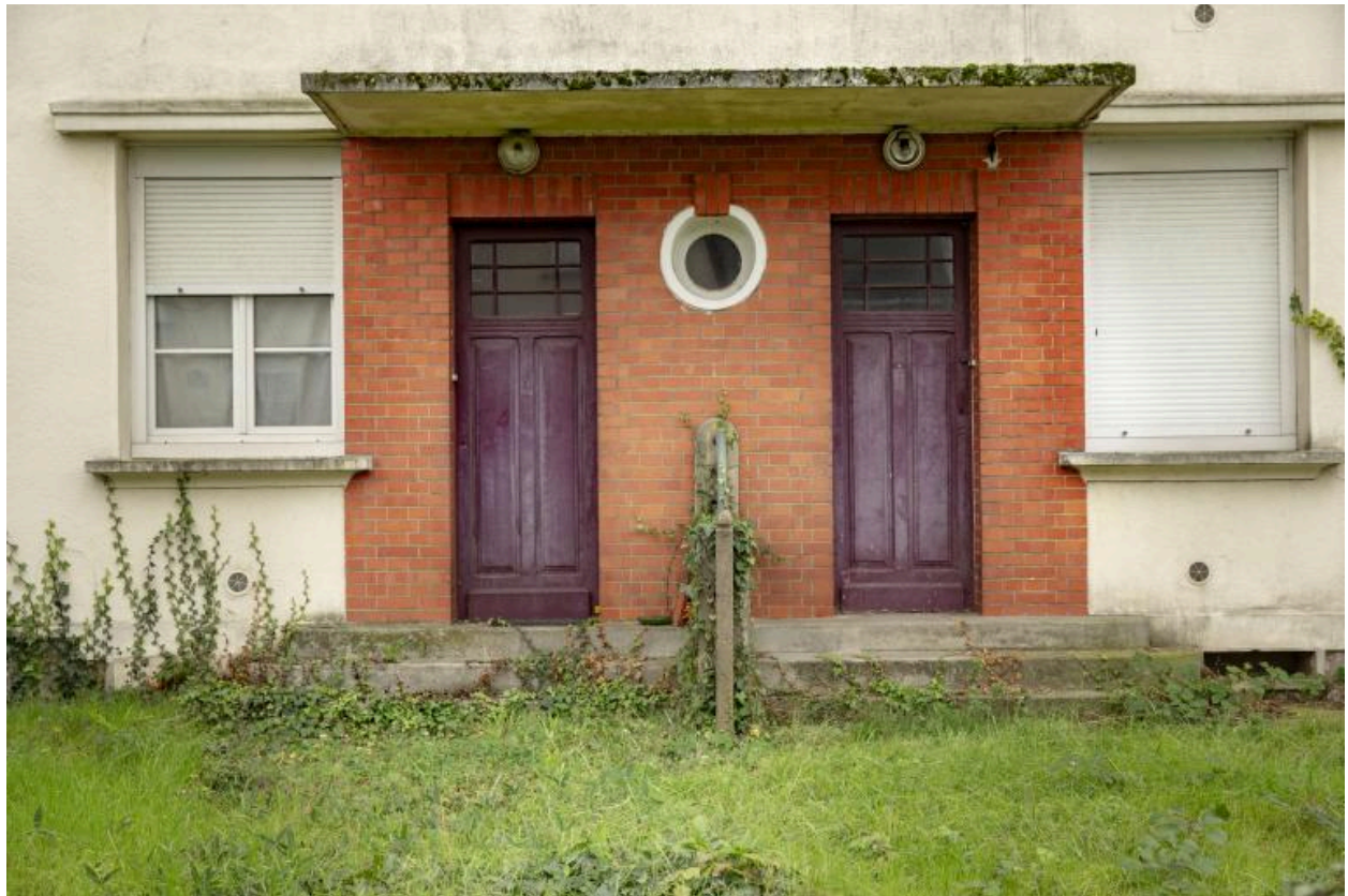
Détail de l'entrée du pavillon de type 2.
