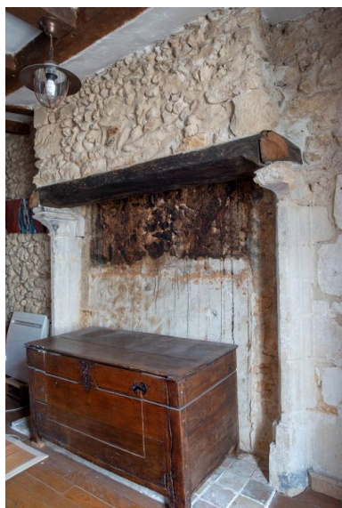
La cheminée de l'étage. Phot. Pierre-Bernard Fourny IVR52_20197200864NUCA
