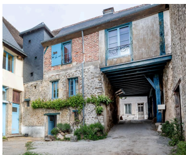
La maison côté cour. Phot. Pierre-Bernard Fourny IVR52_20197200868NUCA
