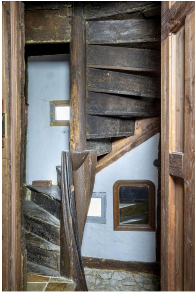
L'escalier au niveau de l'étage. Phot. Pierre-Bernard Fourny IVR52_20197200865NUCA
